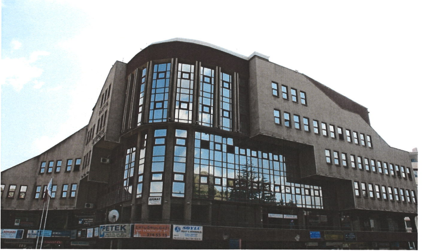
Belediye Merkez Binası
