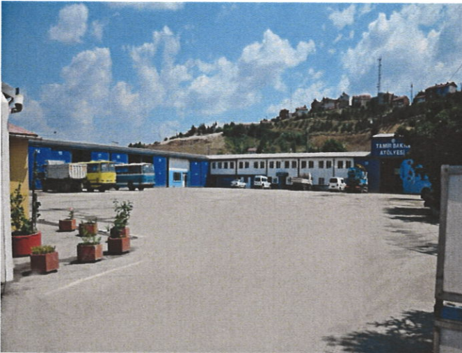
Belediye İtfaiye ve Garaj Binası
