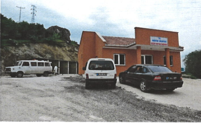
Hayvan Bakım Evi
