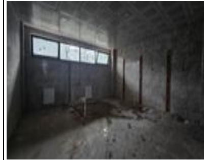
Resim 12: Bilim Merkezi atölyelerin inşaat hali
