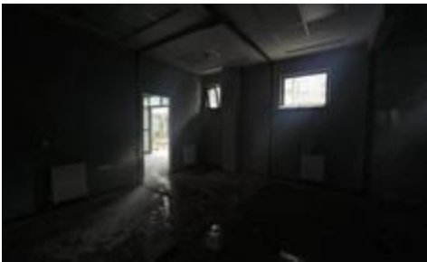
Resim 13: Bilim Merkezi atölyelerin inşaat hali
