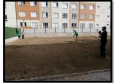
Latif Dörtçelik M.T.A Lisesi toprak tesviyesi
