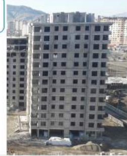
Kazımkarabekir Mah. 12438 Ada 1 Parsel A-B Blok 94 Daire Kentsel Dönüşüm Konutu Yapılması İş'i 2017 yılı içerisinde ihale edilmiş olup her iki blokta kaba inşaat + ince işler imalatları ile devam etmektedir. Toplam İhale Bedeli 8.079.000,00 TL
