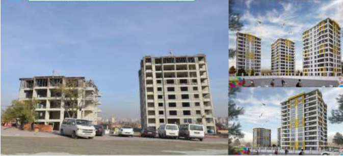
Kazımkarabekir Mah. 12438 Ada 1 Parsel C-D Blok 94 Daire Kentsel Dönüşüm Konutu Yapılması İş'i 2017 yılı içerisinde ihale edilmiş olup her iki blokta kaba inşaat + ince işler imalatları ile devam etmektedir. Toplam İhale Bedeli 8.682.000,00 TL
