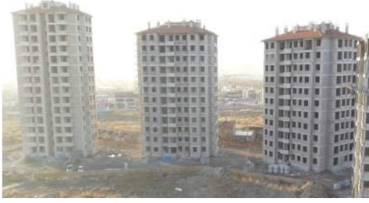
Anbar Mah. Geçici 2. Ada 3 Blok 185 Daire Kentsel Dönüşüm Konutları Yapılması İş'i 2017 Yılı içerisinde ince işlere ait imalatları devam etmiştir. Toplam İhale Bedeli 12.540.000,00 TL
