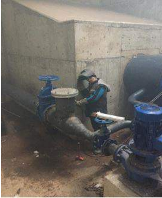
Akçay Barajı Kör Tapa Çalışması
