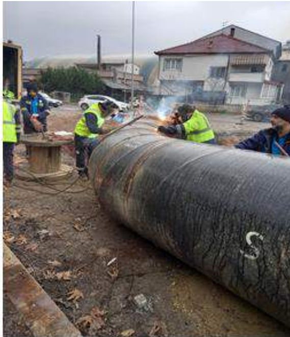
SSK Kavşağı 1400 mm. Deplase Çalışması
