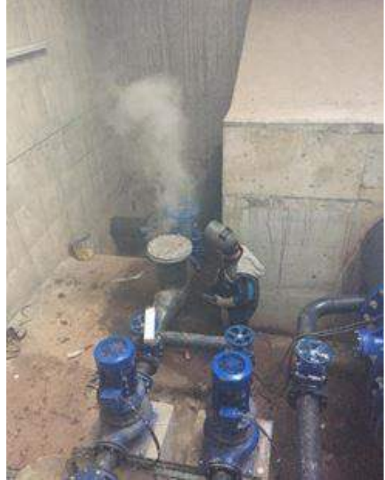
Akçay Barajı Kör Tapa Çalışması
