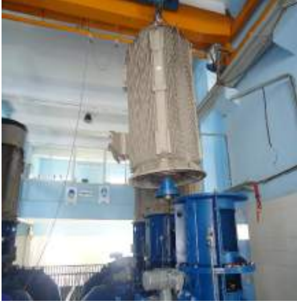
Göl Tesisleri 6 numaralı Motor Bakımı
