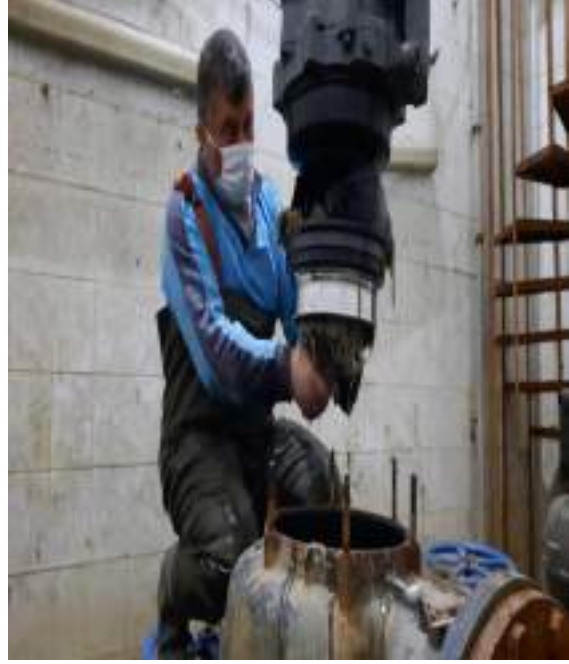
Atıksu Terfi Merkezi Motor Temizliği
