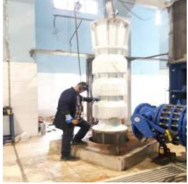
Göl Tesisleri 3 Numaralı Pompa Değişim
