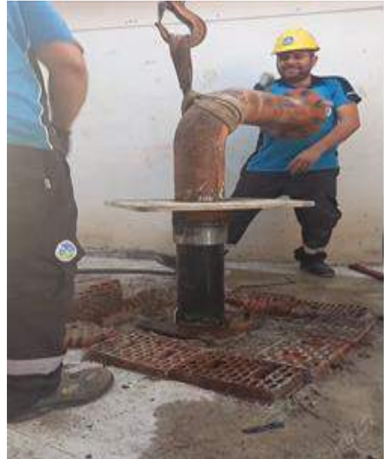
Pamukova Pompa Montajı
