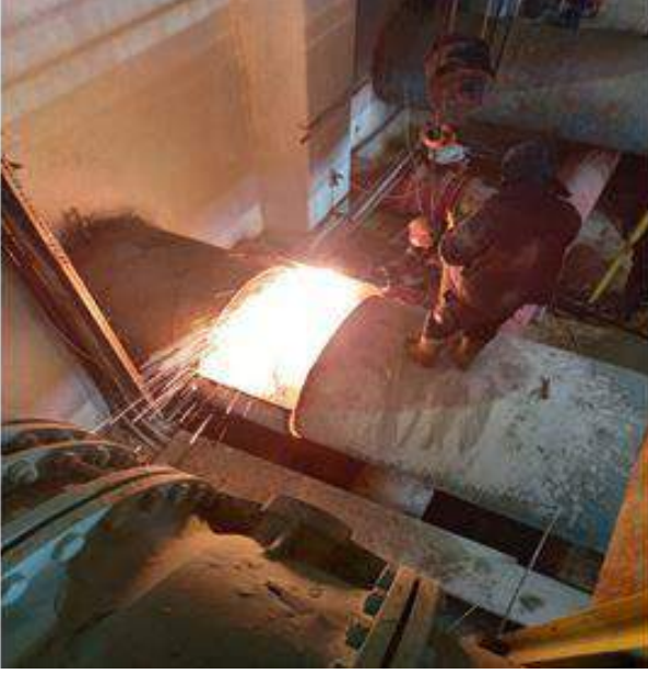
Hızırilyas Tesisleri 1400 mm Vana Montajı
