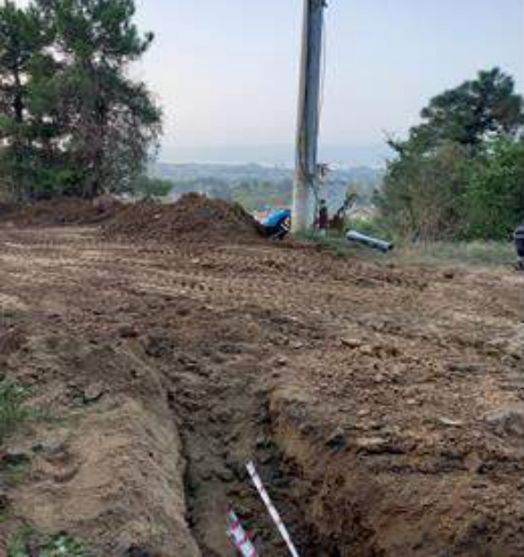
Sapanca Çamlık TM Enerji Nakil Hattı yapımı
