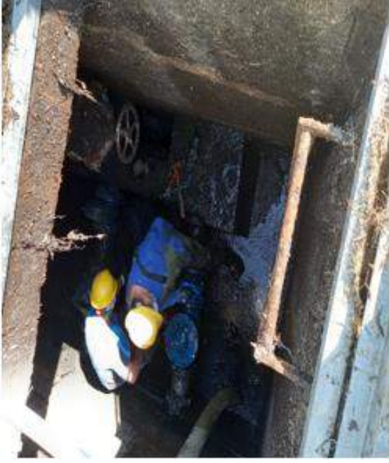
Özlem Evler Atm 400 mm. Kör tapa Kaynağı
