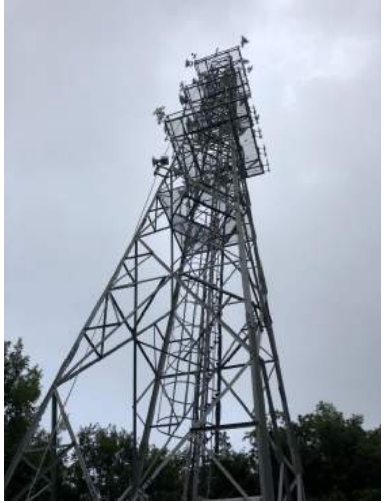
SASKİ Transmisyon Haberleşme Kulesi
