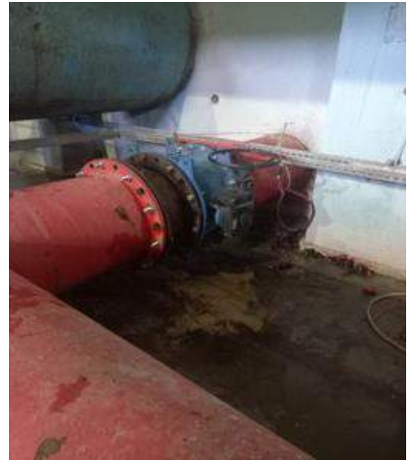
Hızırilyas Tesisleri Tahliye Vanası Montajı
