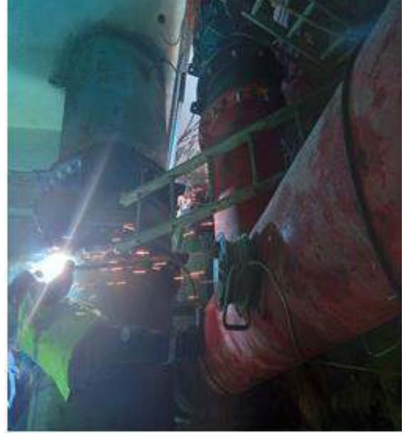
Hızırilyas Tesisleri 1400 mm Vana Montajı
