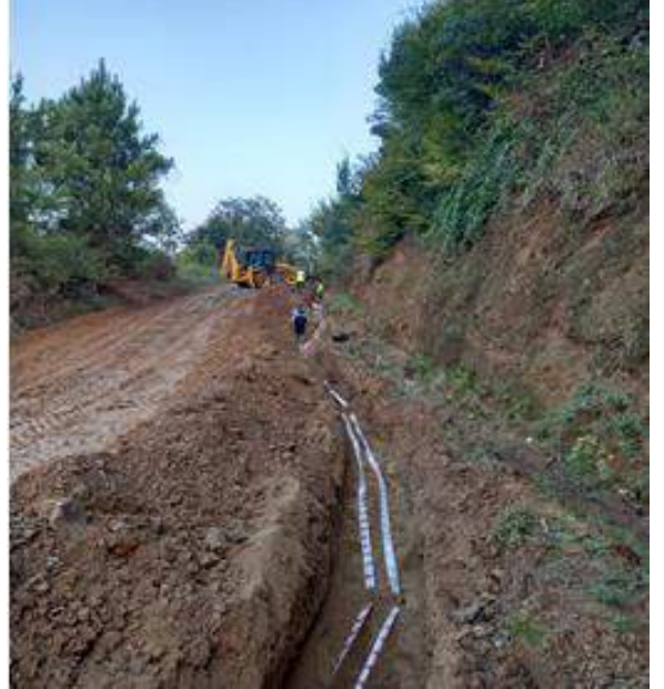
Sapanca Çamlık TM Enerji Nakil Hattı yapımı
