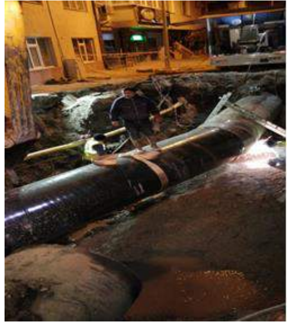
SSK Kavşağı 1400 mm. Deplase Çalışması
