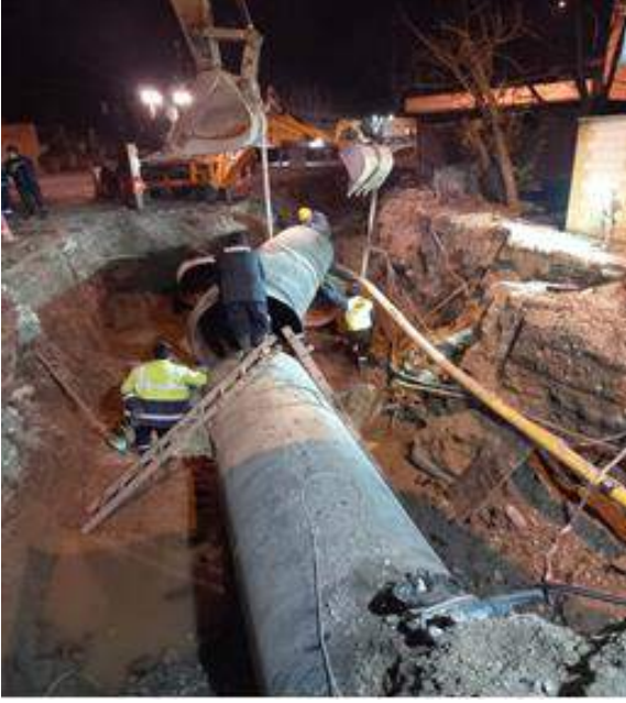
SSK Kavşağı 1400 mm. Deplase Çalışması
