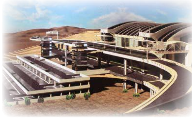
Ağrı Havalimanı Terminal Binası Yapımı
