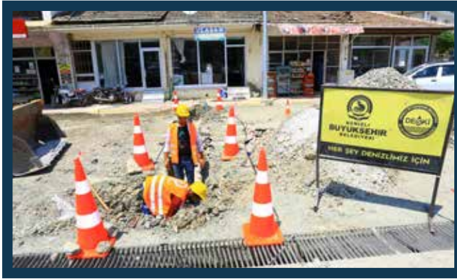
Beyağaç İçmesuyu Abone Bağlantı Hattı Yapımı
