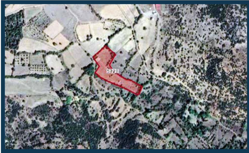
Tavas-Yorga İçme Suyu Tesisi
