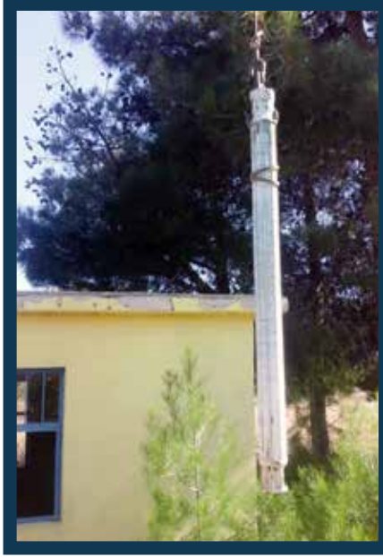
Dalgıç Pompa Değişim İşlemi-Eski Pompa Dalgıç Pompa Değişim İşlemi-Yeni Pompa
