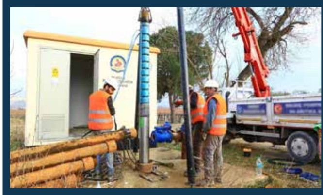
Pompa Değişim İşlemi
