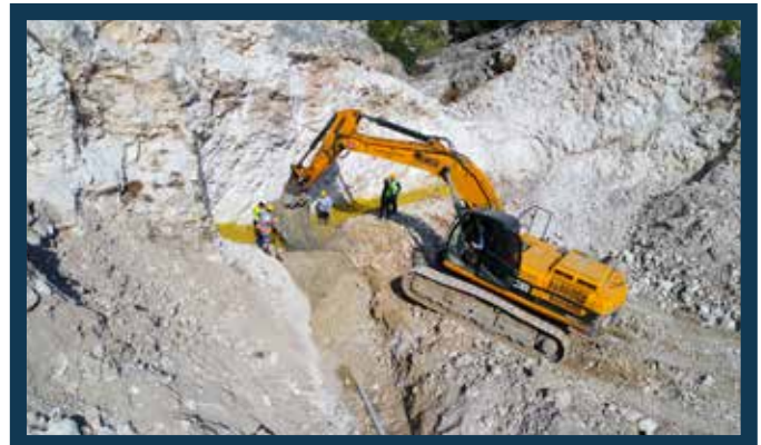
Eymir Kaynağı Drenaj Çalışması
