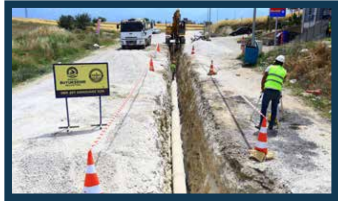
Merkezefendi İlçesi Hacıyüplü Mahallesi Kanalizasyon Hattı İmalatı
