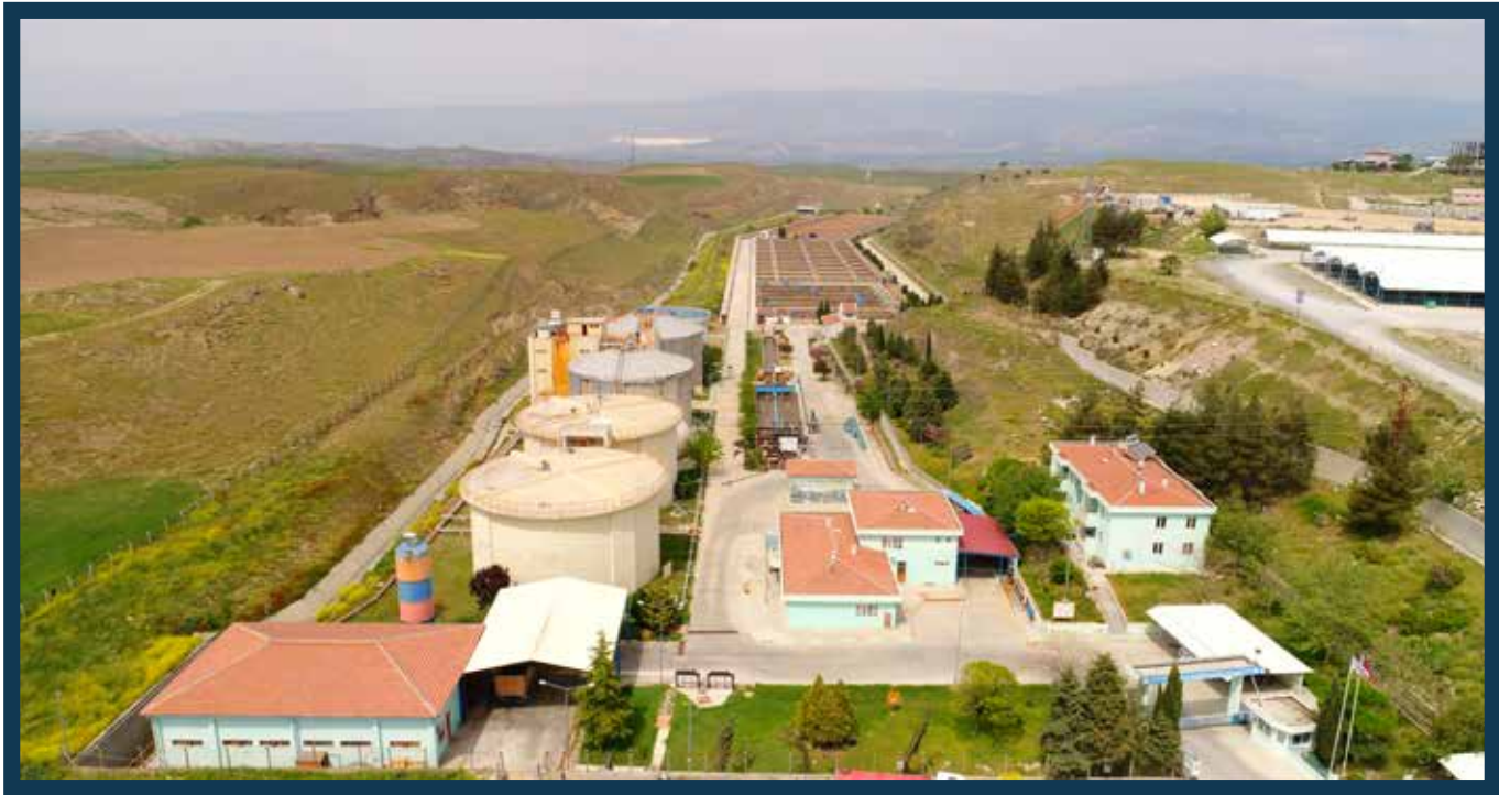
Merkez Atıksu Arıtma Tesis
