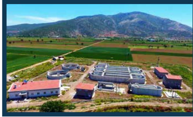
Tavas Atıksu Arıtma Tesisi Yapımı
