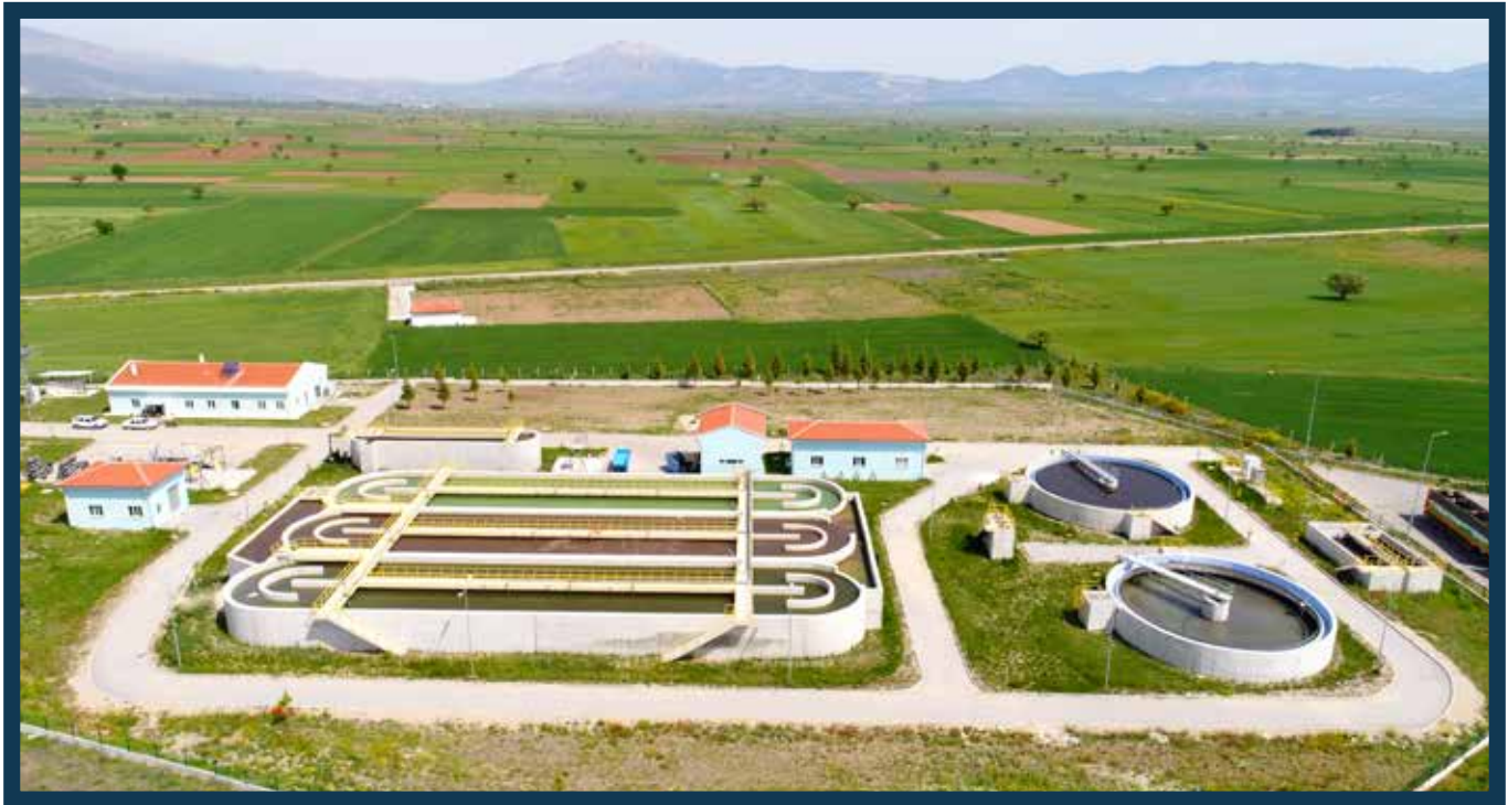
Acıpayam Atıksu Arıtma Tesisi
