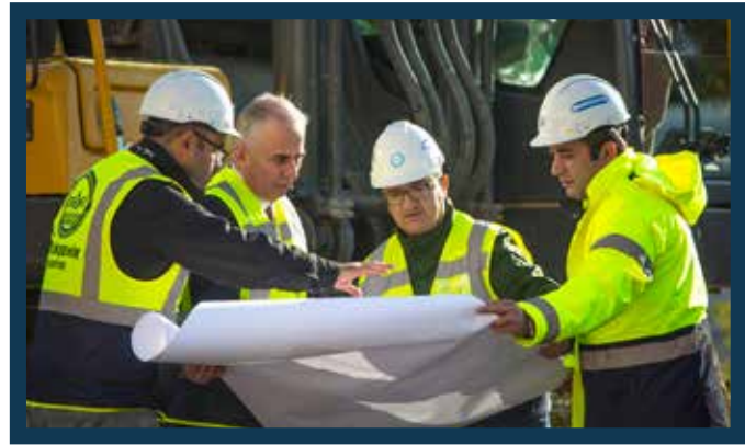
Altyapı Çalışmaları-Aktepe Mahallesi
