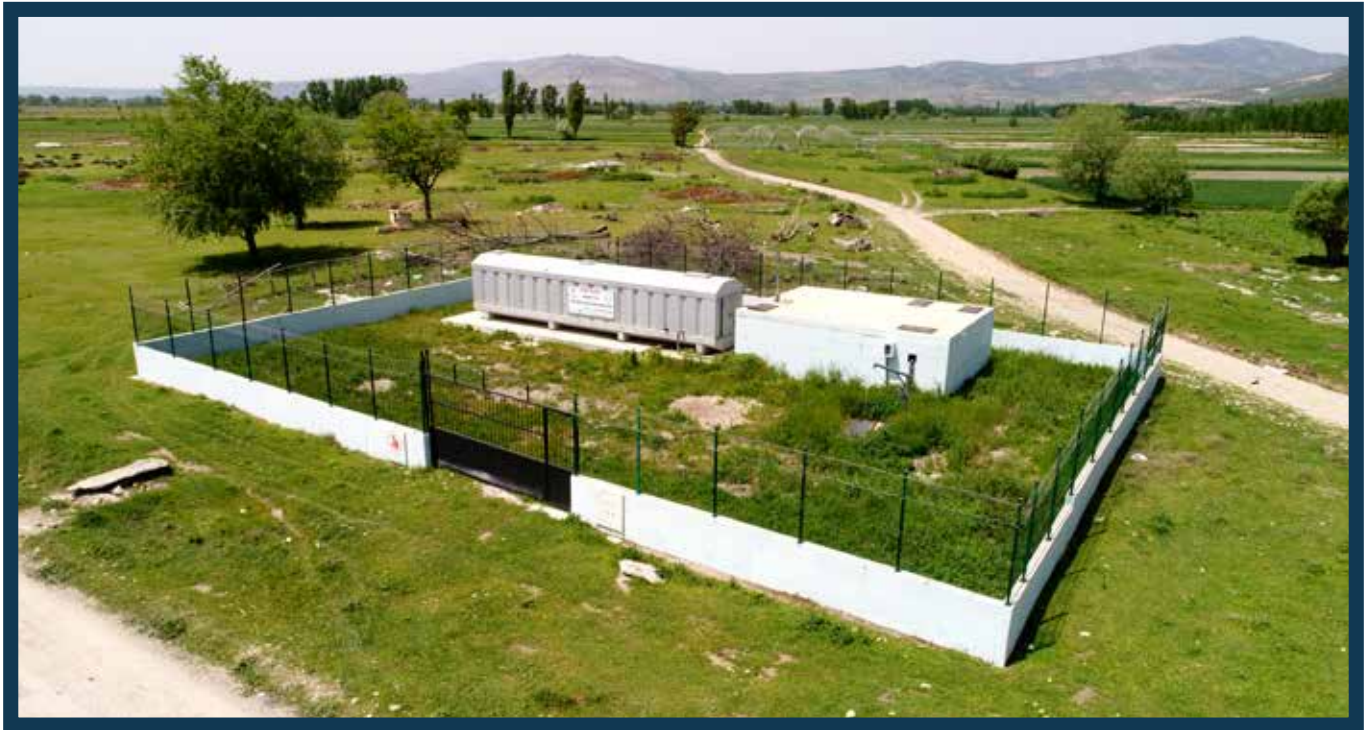
Çivril-Beydilli Paket Atıksu Arıtma Tesisi
