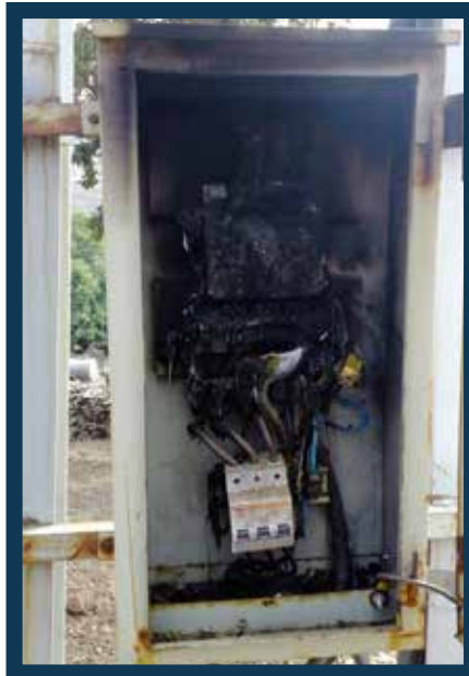
Yanan Elektrik Dağıtım (Sayaç) Panosunun Yenisiyle Değiştirilmesi İşlemi-Öncesi
