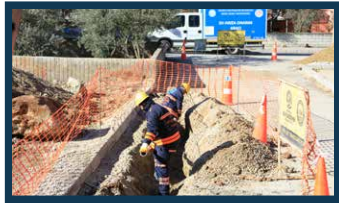
Adalet Mahallesi Ana Şebeke İmalatı
