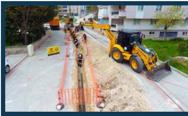
Çakmak Mahallesi Ana Şebeke İmalatı
