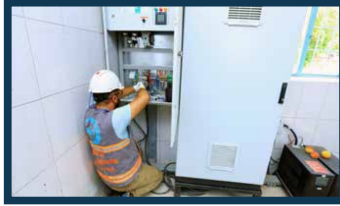
Elektrik Pano Yenileme Çalışması
