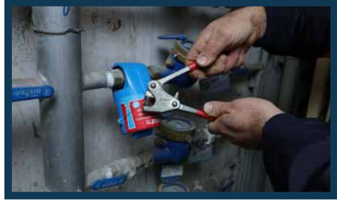
Borçtan Aparat Yardımı ile Kesim İşlemi
