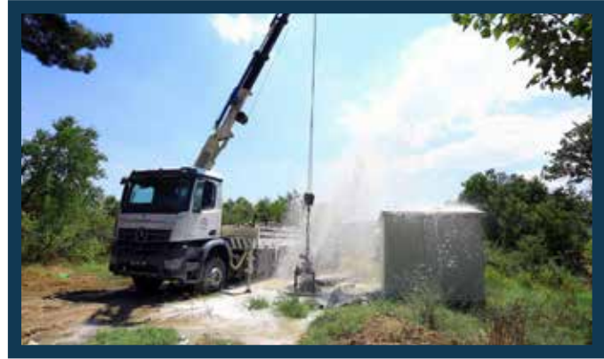
Buldan-Bozalan Mahallesi Sondaj Çalışması
