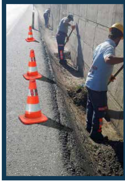
Merkezefendi İlçesi Ali Aygören Bulvarı Açık Kanal Temizliği
