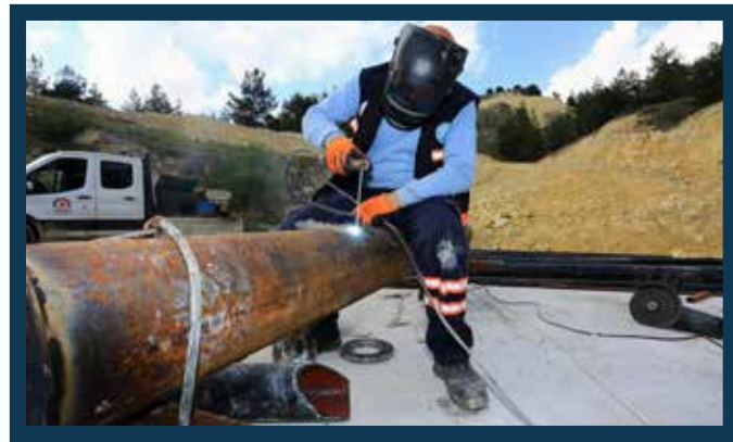
Yeniköy Mahallesi Terfi Hattı İmalatı
