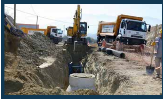
Merkezefendi İlçesi Eskihsar Mahallesi Kanalizasyon Hattı Yapımı
