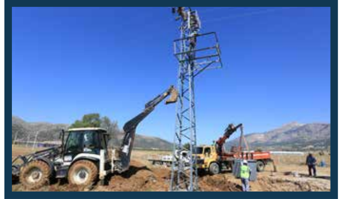
Trafo Değişim İşlemi
