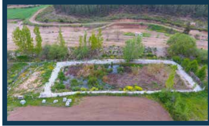
Bozkurt – Alikurt Doğal Atıksu Arıtma Tesisi
