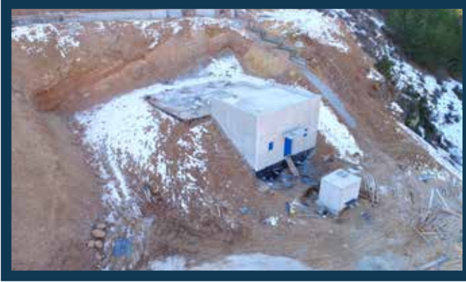
Serinhisar İğmesuyu Deposu (400 m 3 ) Yapımı
