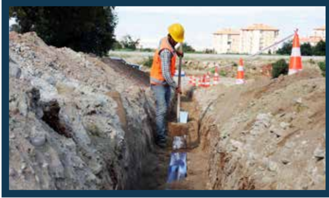
Çakmak Mahallesi Ana Şebeke İmalatı
