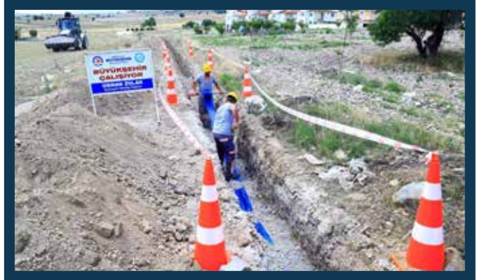
Çardak İlçesi Saray Mahallesi İçmesuyu Hattı Çalışması
