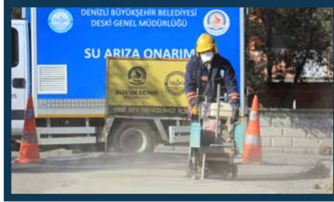
Adalet Mahallesi Şebeke Asfalt Kesme Çalışması
