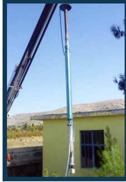
Dalgıç Pompa Değişim İşlemi-Eski Pompa Dalgıç Pompa Değişim İşlemi-Yeni Pompa
