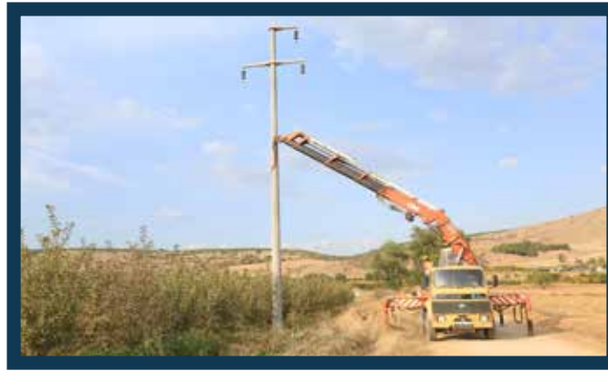
Yeni Açılan Sondaj Kuyusu için Enerji Nakil Hattı Çekilmesi
