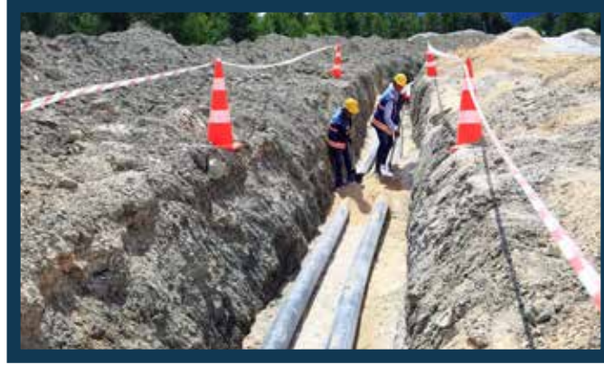
Acıpayam Dariveren İçmesuyu Hattı Yapımı
