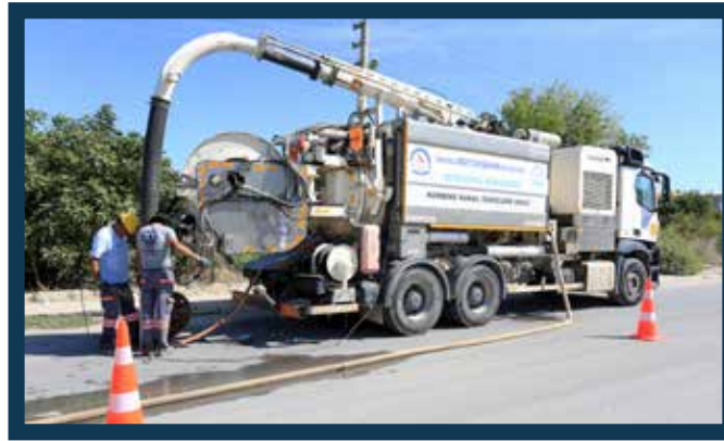
Sarayköy İlçesi Bala Mahallesi Kombine Aracı ile Kanal Temizleme İşi
