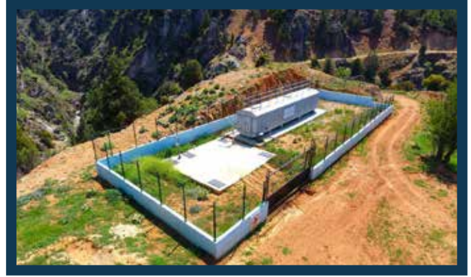
Acıpayam - Eskiköy Paket Atıksu Arıtma Tesisi
