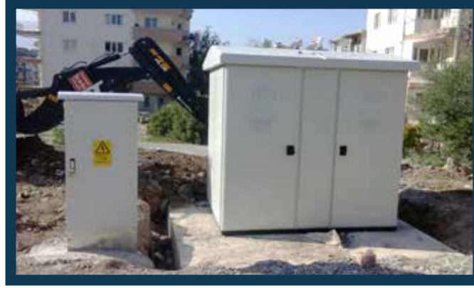
Sondaj Kuyularının ve Kabinlerinin Yenilenmesi Çalışması
