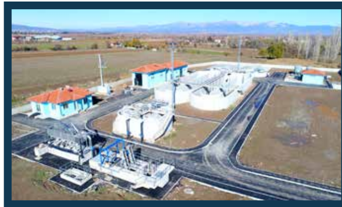
Kale Atıksu Arıtma Tesisi Yapımı
