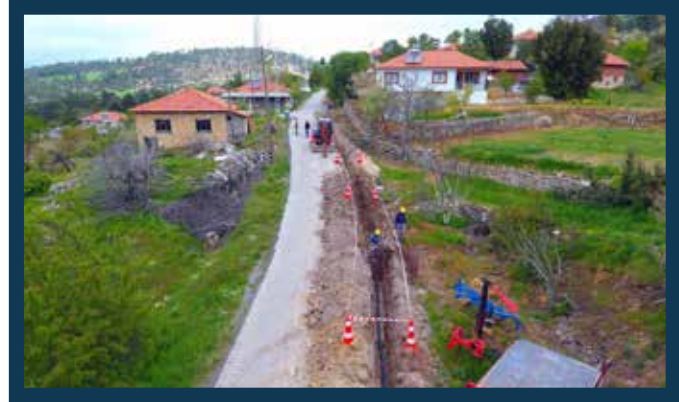
Çameli İlçesi Kolak Mahallesi Taşdibi Mevkii İçmesuyu Hattı Çalışması
