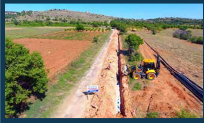
Bekilli İlçesi Kutlubey Mahallesi İletim Hattı Çalışması
