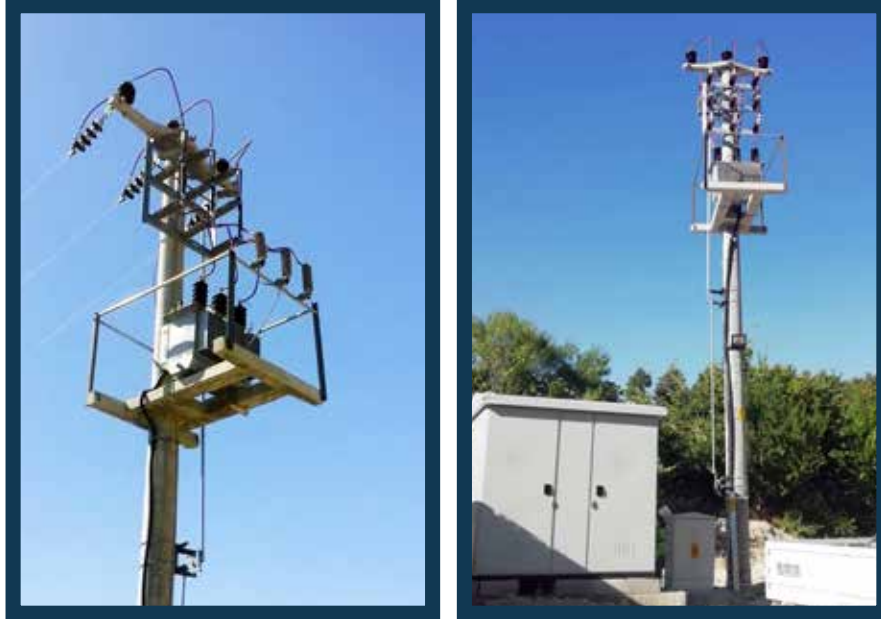
Trafolu Orta Gerilim Tesisleri Bakım-Onarım İşleri OG Tesisleri Yeni Kabin, Trafo Direği Dikme Trafo & Pano Bağlama İşleri
