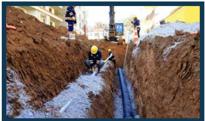
Acıpayam İlçesi Yukarı Mahalle İçmesuyu ve Kanalizasyon Hattı Çalışması
