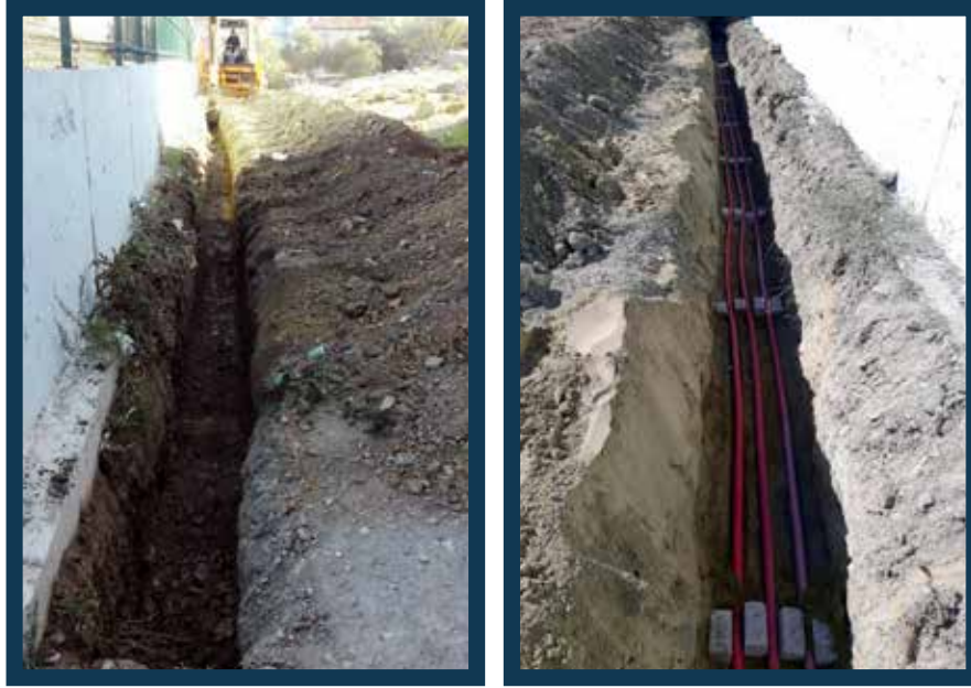
Enerji Besleme Hattı Çekilmesi Çalışması
