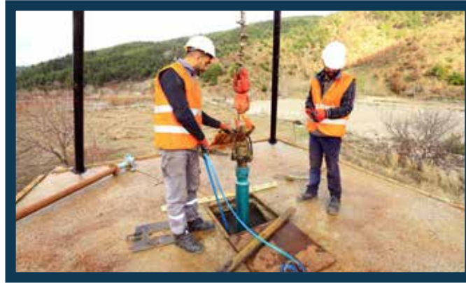
Pompa İndirme İşlemi
