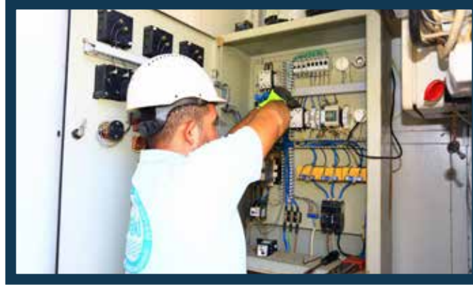
Elektrik Arızasının Giderilme Çalışması
