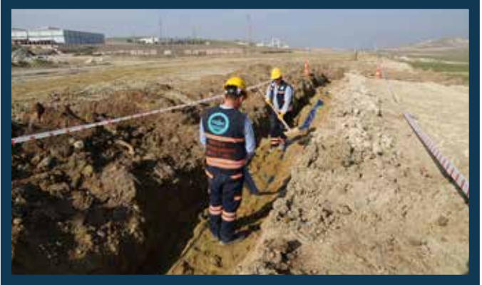
Bozburun Mahallesi Ana Şebeke İmalatı
