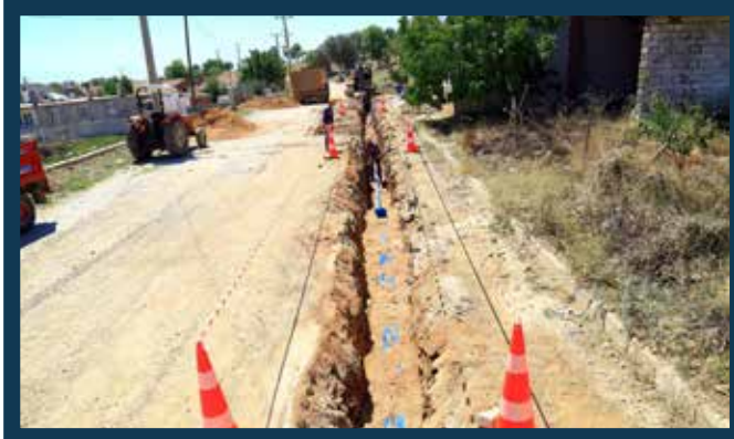
Serinhisar İçmesuyu Hattı Yapımı
