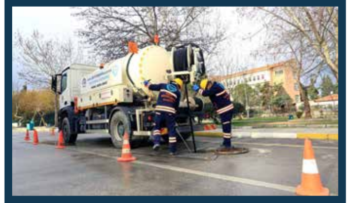
Merkezefendi İlçesi Sümer Mahallesi Kanal Açma Temizliği
