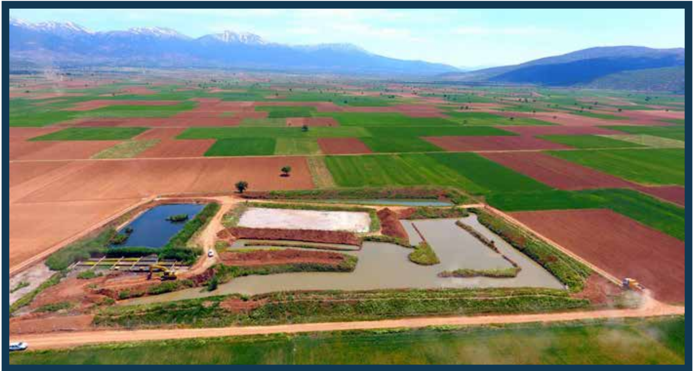
Tavas-Nikfer Doğal Atıksu Arıtma Tesisi
