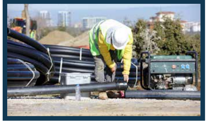
Hacıyüplü Mahallesi Ana Şebeke İmalatı
