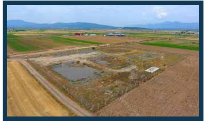
Acıpayam - Yumrutaş Doğal Atıksu Arıtma Tesisi
