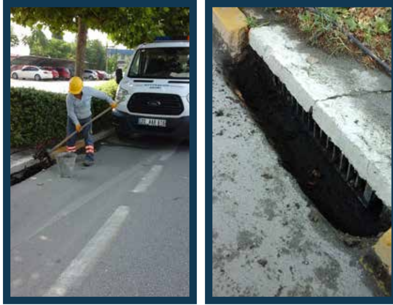
Merkezefendi İlçesi İzmir Yolu Üzeri Yağmursuyu Izgara Temizliği
