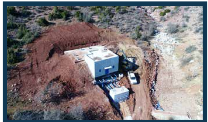
Serinhisar İçmesuyu Deposu (500 m 3 ) Yapımı
