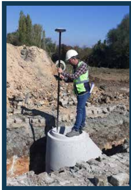
Denizli İli Kale İlçesi Arıtma Tesisi Kolektör Hattı Yapım İşi
