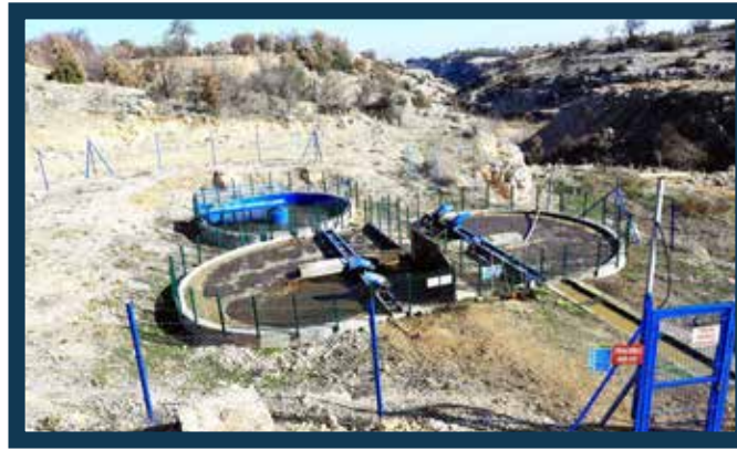
Gözler Atıksu Arıtma Tesisi Genel Görünüm
