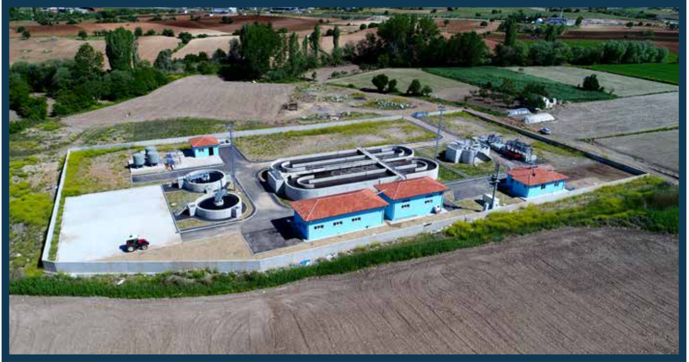
Kale Atıksu Arıtma Tesisi
