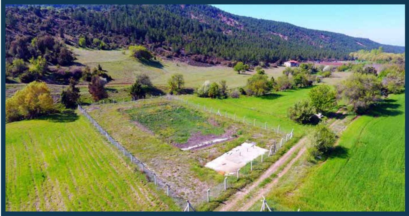
Tavas-Pınarlık Doğal Atıksu Arıtma Tesisi
