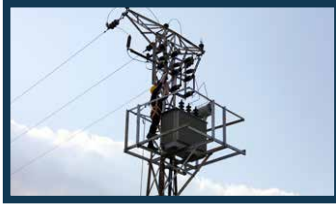
Hat Bakım Onarım Çalışması
