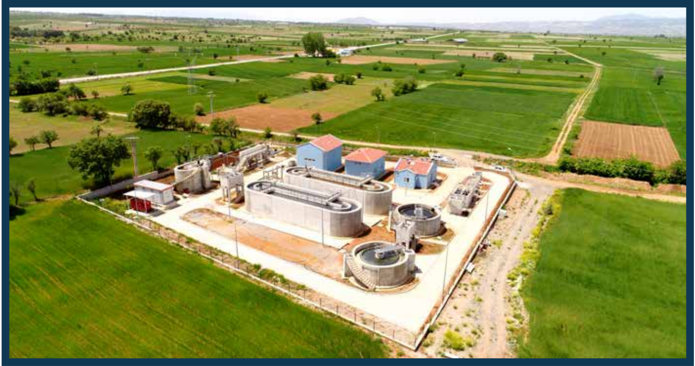
Baklan Atıksu Arıtma Tesisi
