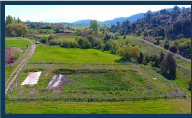
Tavas - Pınarlık Doğal Atıksu Arıtma Tesisi
