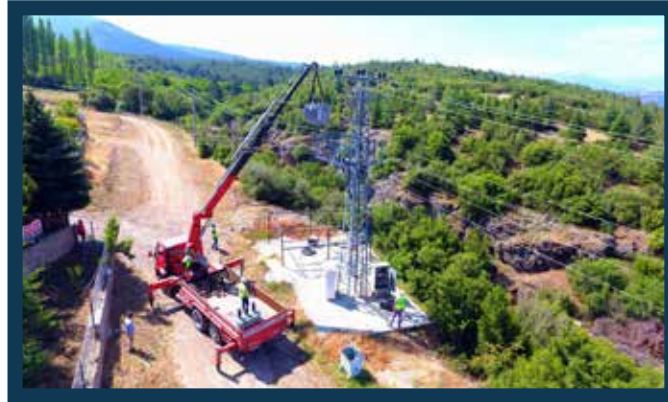
Trafo Yerleştirme Çalışması
