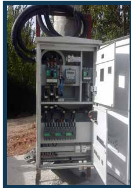
Yanan Elektrik Dağıtım (Sayaç) Panosunun Yenisiyle Değiştirilmesi İşlemi-Sonrası
