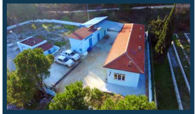
Çamlık Klor Depolama Tesisi
