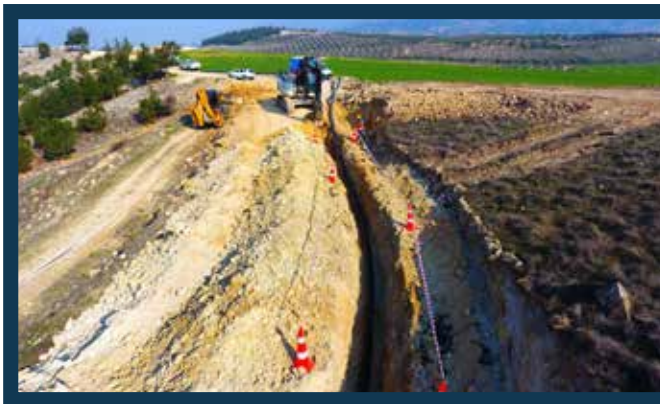
Pamukkale Mahallesi Ana Şebeke İmalatı
