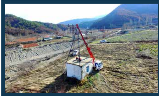
Pompa İndirme İşlemi
