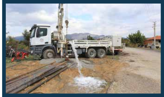
Tavas-Vakıf Mahallesi Pompa Tecrübesi
