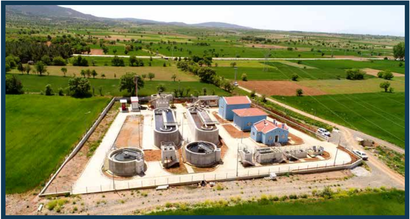
Baklan Atıksu Arıtma Tesisi
