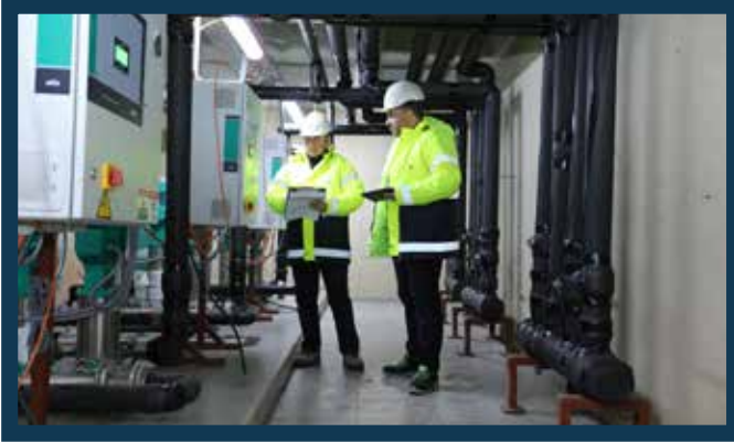
Yapı Kullanım İzin Belgesine İstinaden Yerde Pompa ve Hidrofor Sistemi İnceleme
