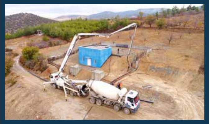
Baklan İçmesuyu Deposu İmalatı Yapımı (500 m 3 )
