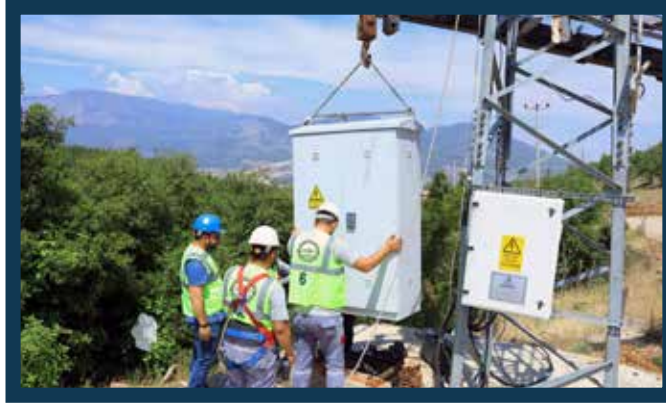
Elektrik Panosu Bakım Onarım İşlemi
