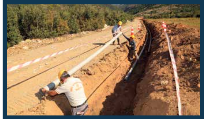
Tavas İlçesi Yorga Mahallesi Cazibeli İçmesuyu Hattı Çalışması
