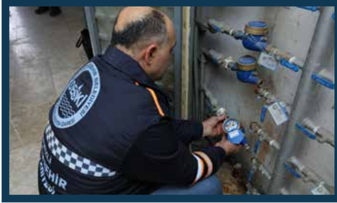
Borçtan Kör Tapa Yardımı ile Kesim İşlemi
