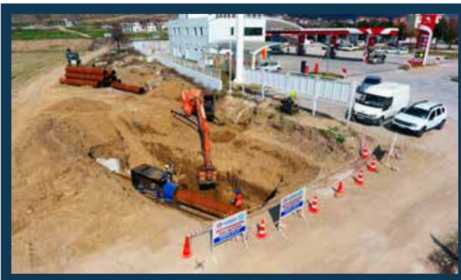
Çardak İlçesi Saray Mahallesi Yatay Sondaj Çalışması
