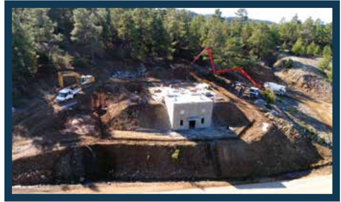
Beyağaç İçmesuyu Deposu (1.000 m 3 ) Yapımı
