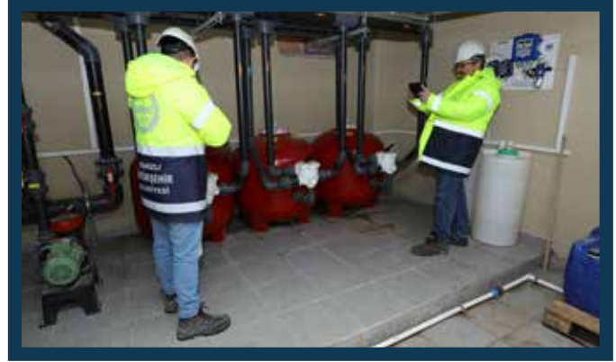
Yapı Kullanım İzin Belgesine İstinaden Yerde Pompa ve Hidrofor Sistemi İnceleme
