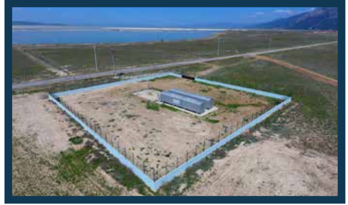
Çardak - Gemiş Paket Atıksu Arıtma Tesisi
