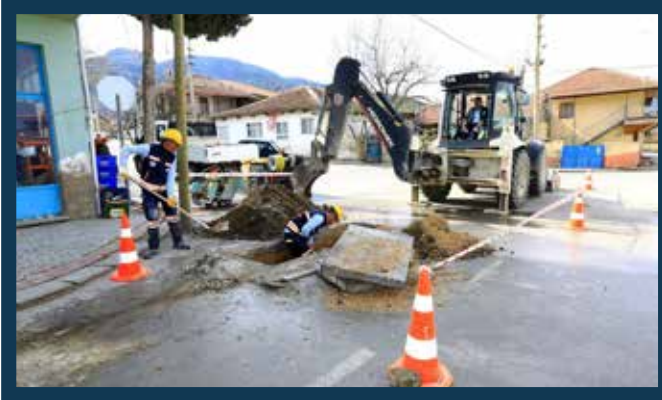
Çardak İlçesi Beylerli Mahallesi Ana Boru Kanalizasyon Hattı Arıza Tamirâtı
