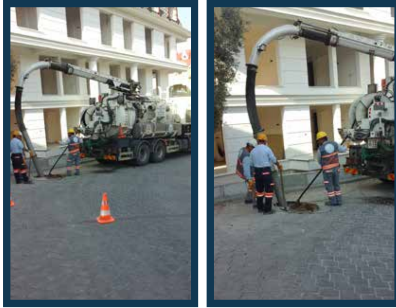
Pamukkale İlçesi Cumhuriyet Mahallesi Kombine Aracı ile Kanalizasyon Hattı Temizliği
