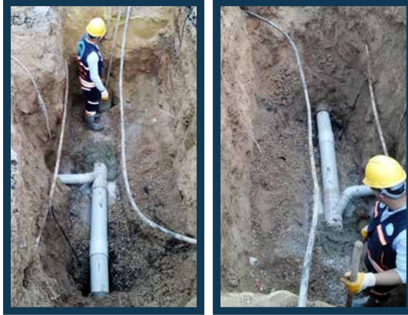
Pamukkale İlçesi Aktepe Mahallesi Binalara Ait Atıksu Bağlantı Hattı İmalatı
