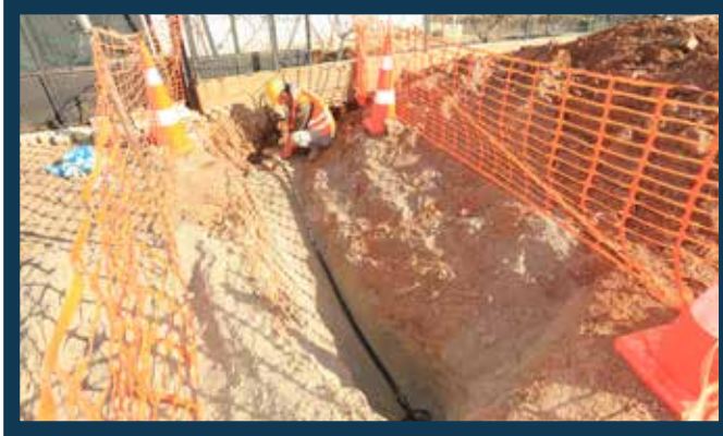
Baklan İçmesuyu Abone Bağlantı Yapımı
