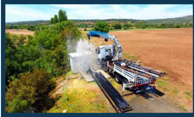
Tavas-Yahşiler Mahallesi Kuyu Temizliği
