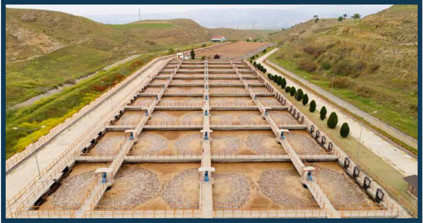
Merkez Atıksu Arıtma Tesisi
