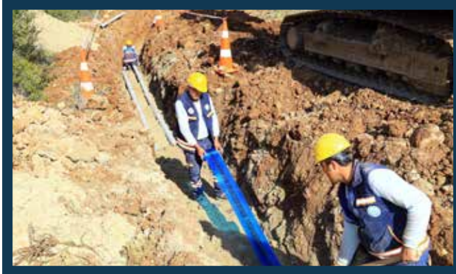
Tavas İlçesi Denizoluğu Mahallesi Terfi Hattı Çalışması
