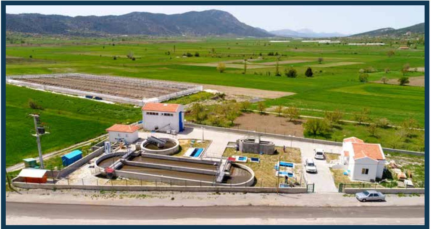
Çameli Atıksu Arıtma Tesisi
