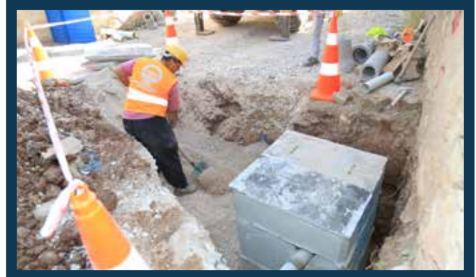
Serinhisar Kanalizasyon Parsel Bacası ve Bağlantı Yapımı
