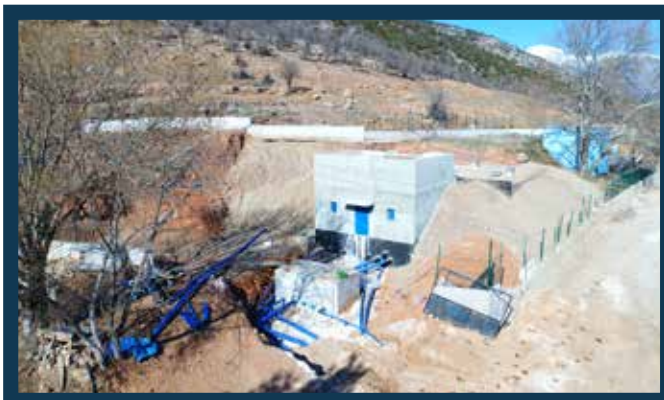
Serinhisar İçmesuyu Deposu (700 m 3 ) Yapımı
