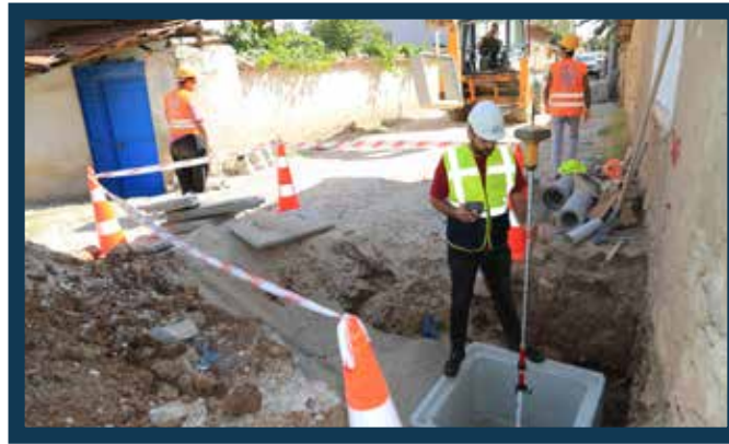
Serinhisar İçme Suyu ve Kanalizasyon, Yağmursuyu Hatları Yapım İşİ
