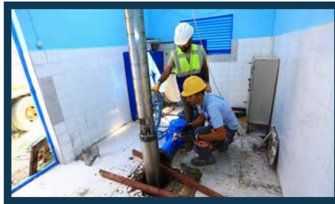
Pompa Bakım Onarım Çalışması
