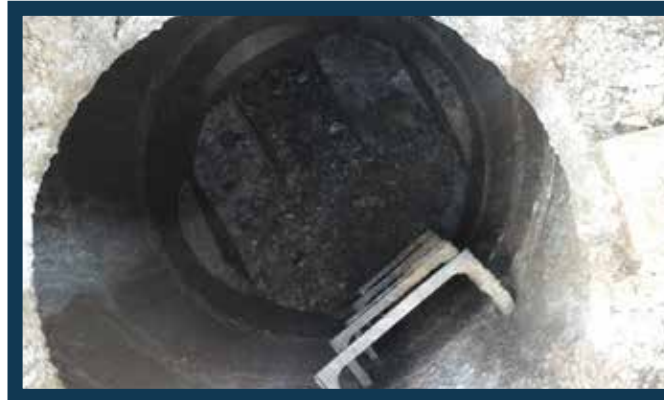
Kazım Kaynak Caddesi Kanalizasyon Hattı ve Muayene Baca Temizliği
