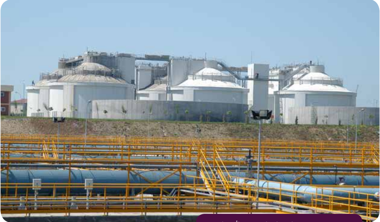
Ataköy İleri Biyolojik Atıksu Arıtma Tesisi
