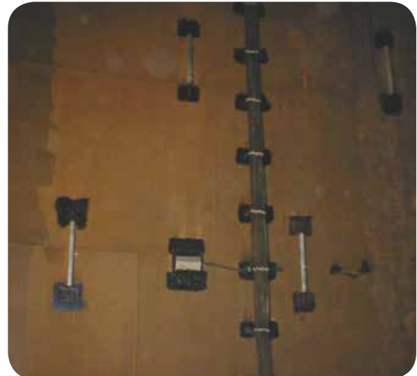
Tuzla Sekonder ve Primer Tankları Katodik Koruma Redresör Üniteleri
