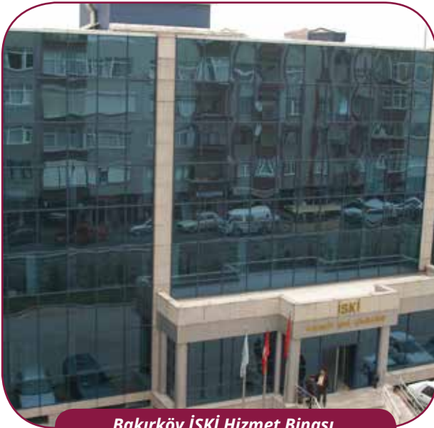
Bakırköy İSKİ Hizmet Binası
