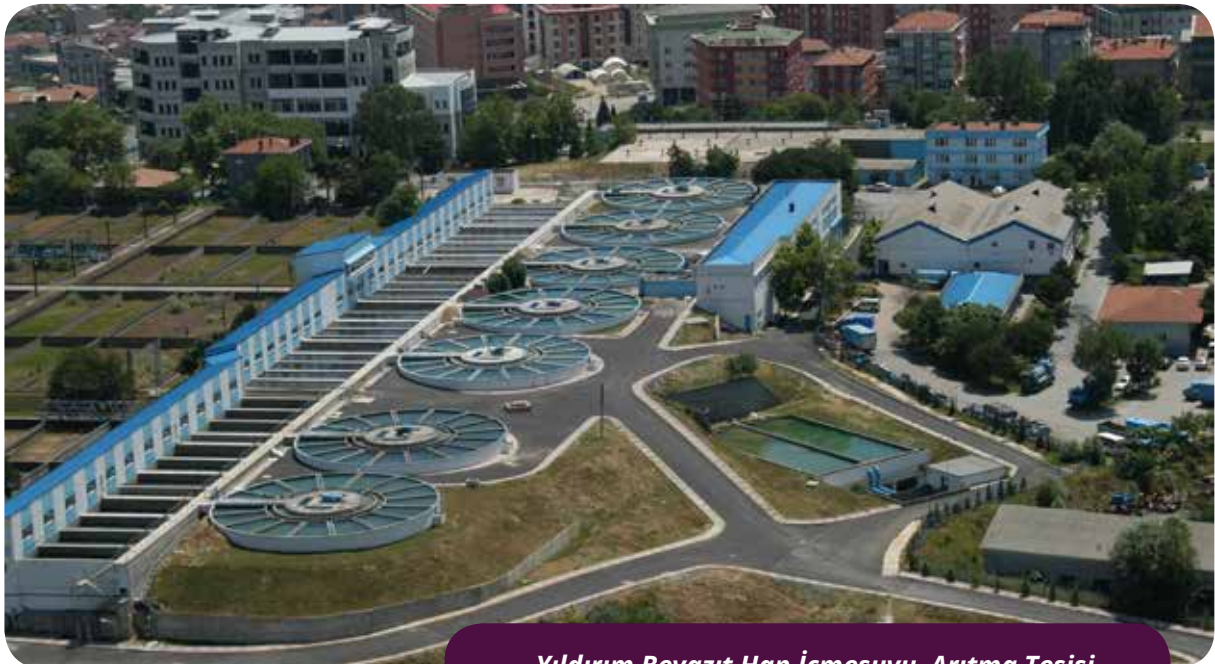
Yıldırım Beyazıt Han İçmesuyu Arıtma Tesisi
