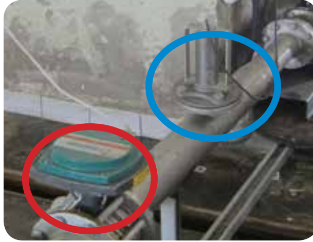
Mikrodalga Teknolojisi ile Yoğunluk Ölçümü
