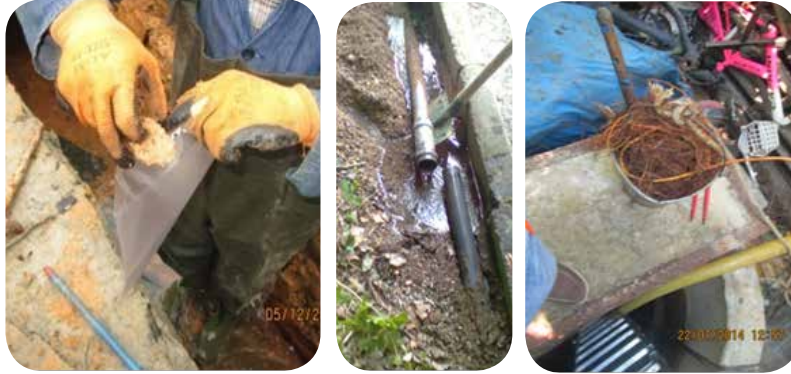
Su Yolu Onarım Çalışmaları
