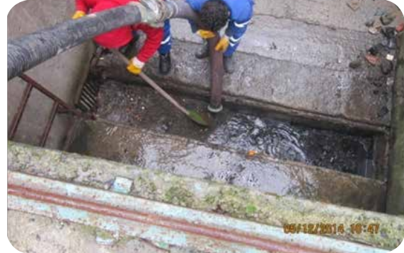
Tarabya Su Alma Yapısı Kanal ve İzgara Temizlik Çalışmaları
