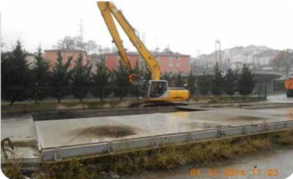
Sadabad Kum Tutucu Yapısı Temizlik Çalışması
