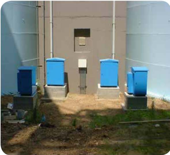
Tuzla Sekonder ve Primer Tankları Katodik Koruma Redresör Üniteleri
