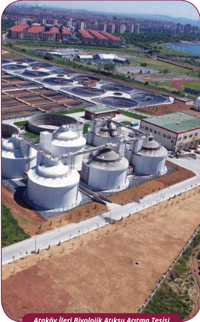
Ataköy İleri Biyolojik Atıksu Arıtma Tesisi
