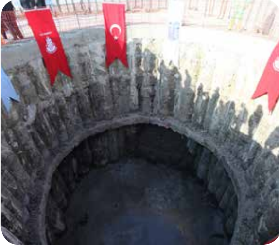
Silivri Boğluca Deresi TBM Çıkış Temel Atma Programı
