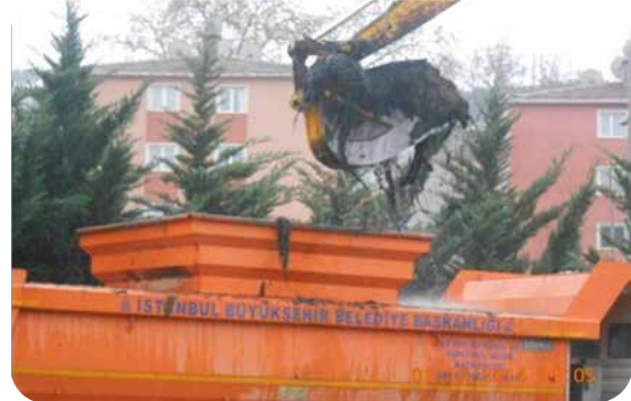
Sadabad Kum Tutucu Yapısı Temizlik Çalışması
