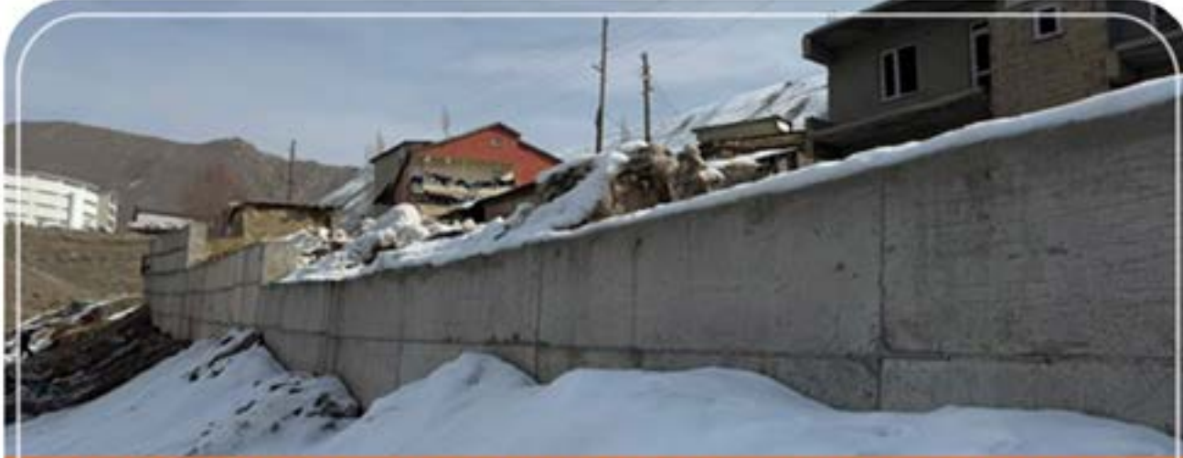
Keklikpınar Mahallesi 1510 nolu sokakta 39.05 metre betonarme istinat duvarı yapılmıştır. Hizmet Bedeli 1.621.292,40 Türk lirasıdır.
