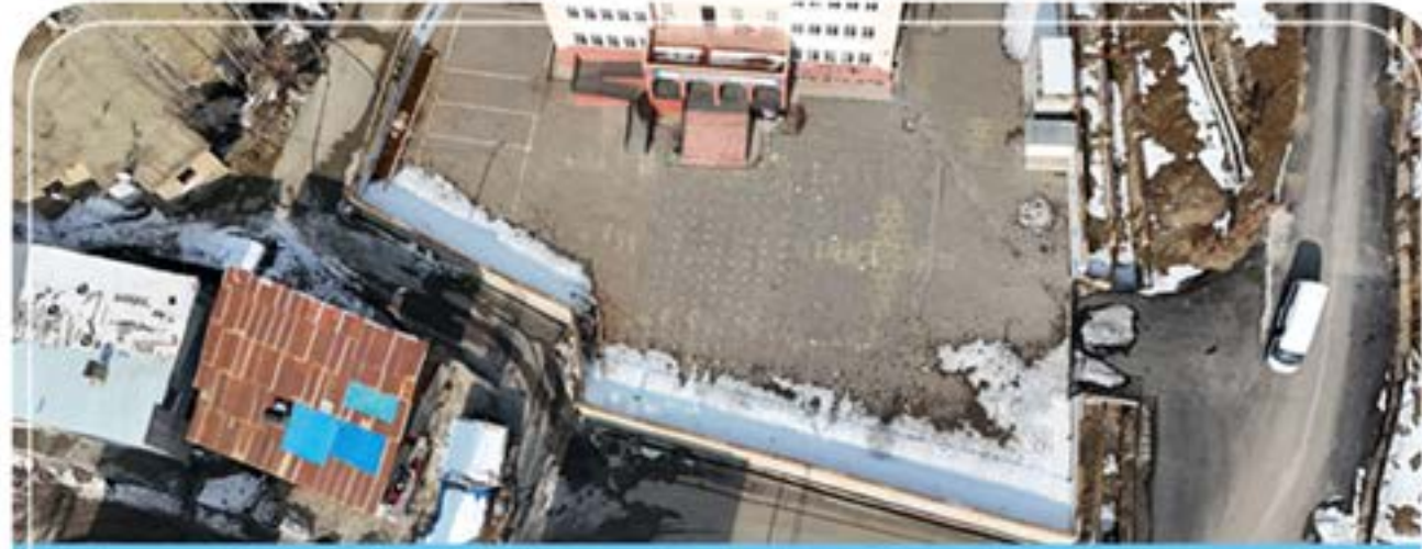
Keklikpınar Mahallesi 150 metre kanal yapılmıştır. Hizmet Bedeli 263.920,50 Türk lirasıdır.
