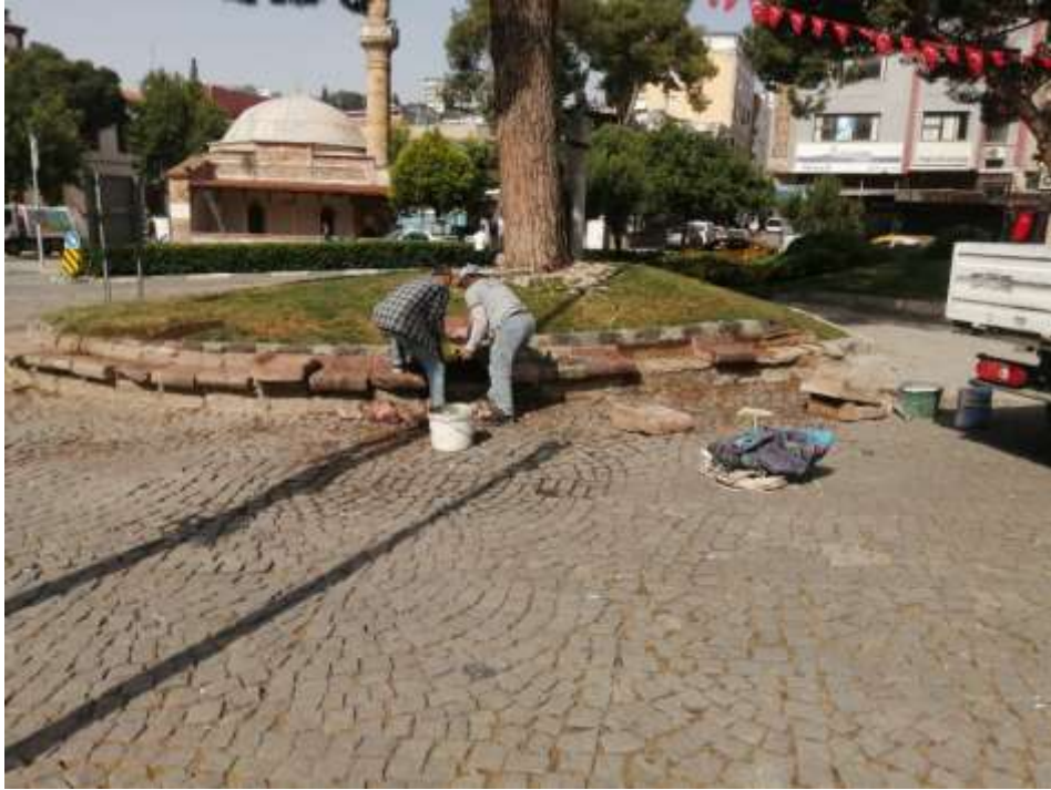
Cumhuriyet Meydanı oturma alanlarının tamir, bakım onarımı yapılması işi.
