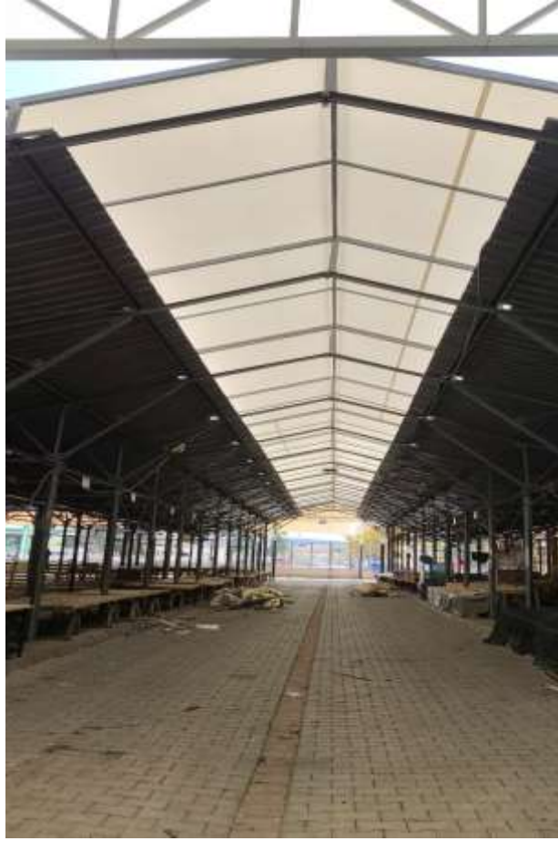
Kapalı pazaryeri Çelik Çatı Membran kaplama işi
