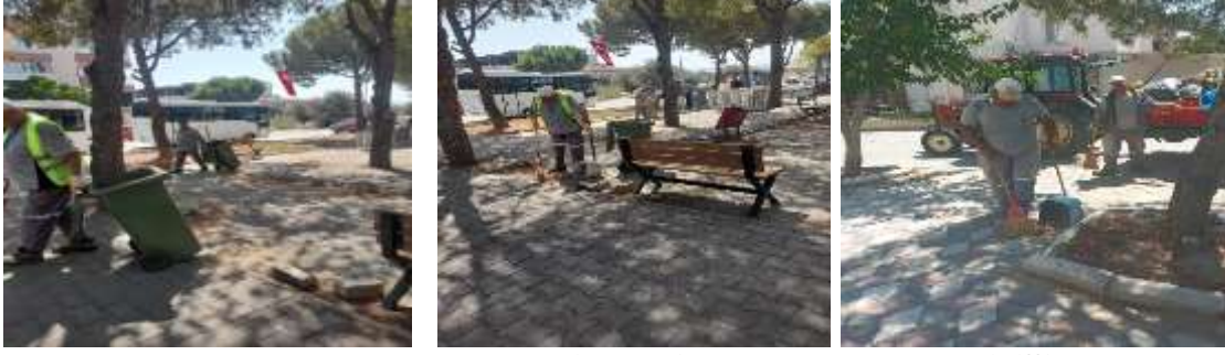
Parkların ve Merdivenlerin Yıkınması ve Temizliđi
