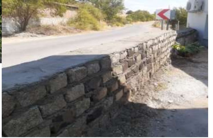
ARMAĞANLAR MAH. CAMİ İSTİNAT DUVARI YAPILMASI İŞİ.
