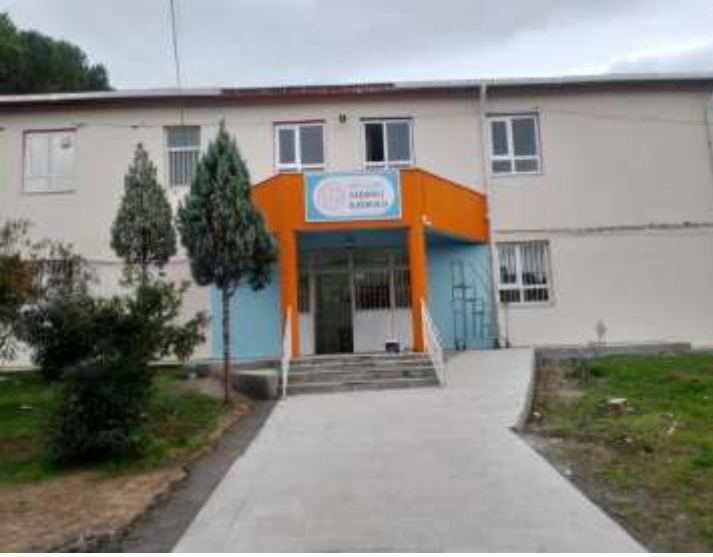
SAĞANCI MAHALLESİ İLKOKULU BOYA BAKIM ONARIM YAPILMASI İŞİ.
