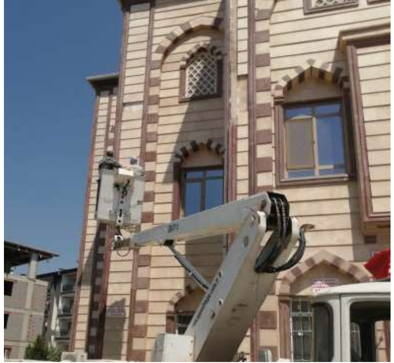
Gaziosmanpaşa Mah. Abdullah Efendi Camii dış mermer kaplamaları tehlike arz ettiğinden tamir, bakım onarımı yapılmıştır.
