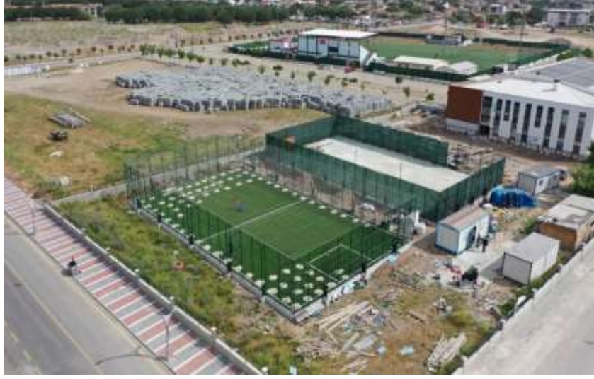
Fevzipaşa Mahallesi Tenis Kortu ve Halı Saha
