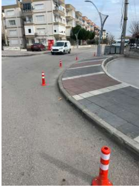
Muhtelif yerlerde plastik delinatör tamir, bakım ve montajları yapılması işi.
