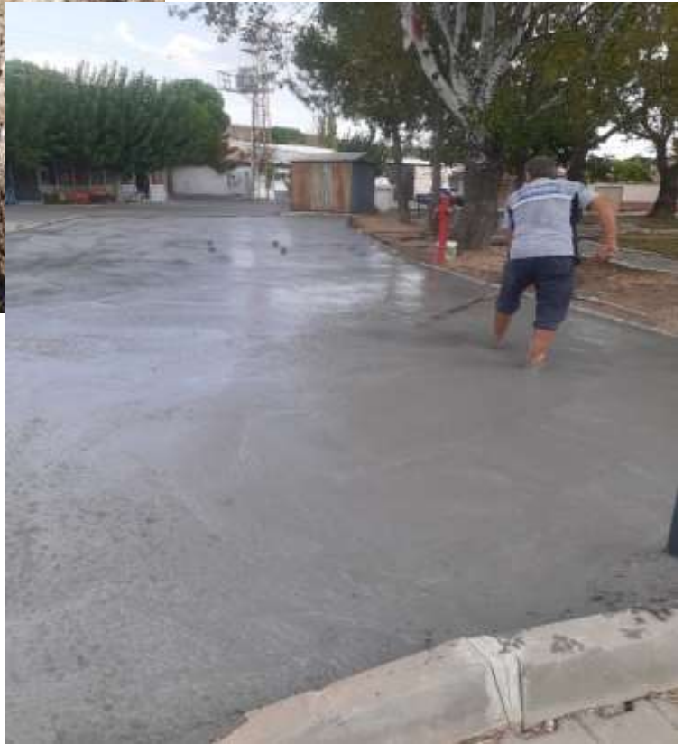
GÖÇBEYLİ MAH. PARKI ZEMİN BETONU DÖKÜLMESİ İŞİ.
