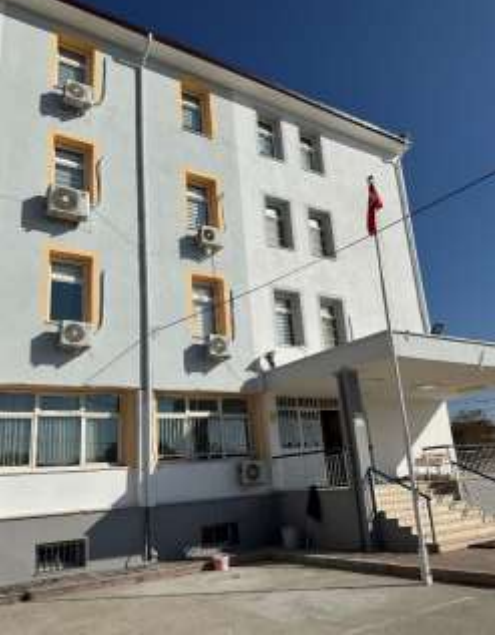
İLÇE MİLLİ EĞİTİM MÜDÜRLÜĞÜ BAKIM ONARIM YAPIM İŞİ
