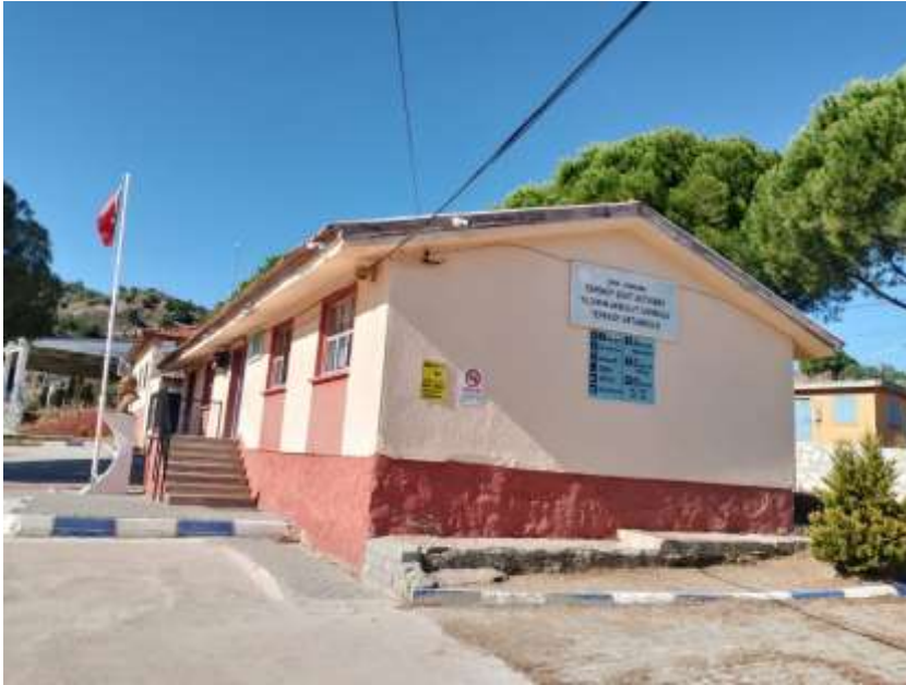
TEPEKÖY MAHALLESİ OKULU BOYA BAKIM ONARIM YAPILMASI İŞİ.
