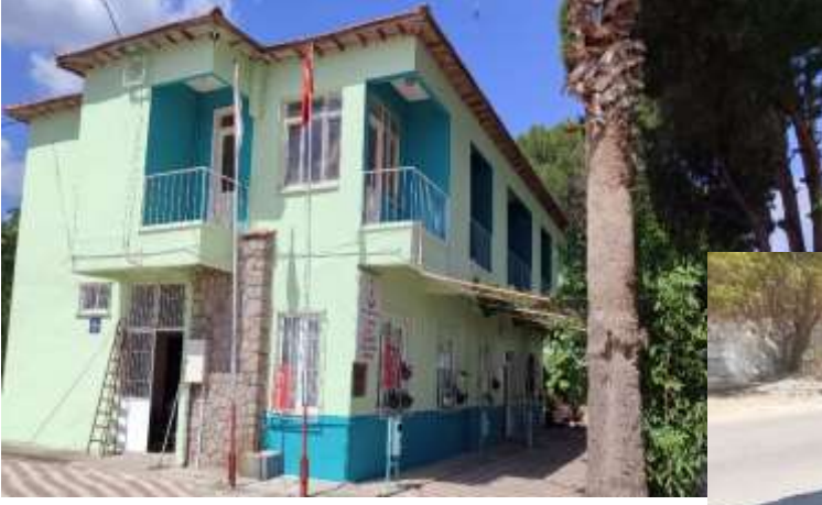
AYASKÖY MAH. SAĞLIK OCAĞI DIŞ CEPHE BOYAMA İŞİ.
