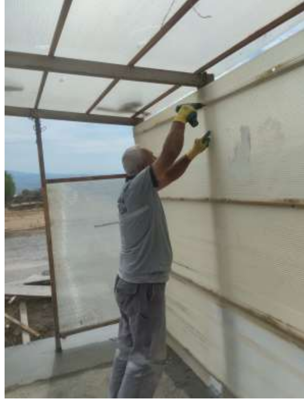
Muhtelif cadde ve sokaklarda otobüs durakları tamir,bakım onarım işi.
