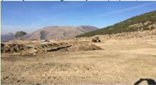
(55Evler Mah. Yağmur suyu hat çalışması)
