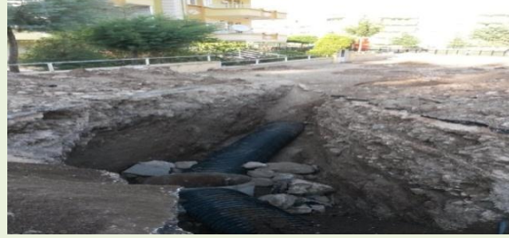
(Kanalizasyon tamirat çalışması)
