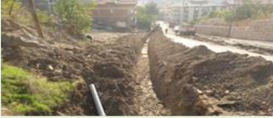
(KirazlıdereMah.İçme suyu hat çalışması )
