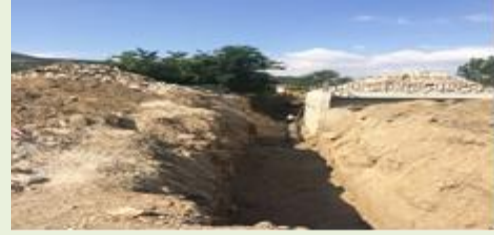
(Hızırpaşa Mah. Kanalizasyon çalışması)
