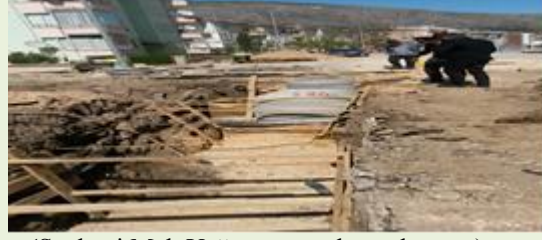
(Şeyhcu Mah. Yağmur suyu hat çalışması)
