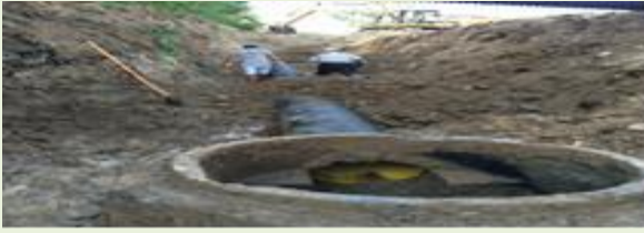
(Göllübağları Mah. Kanalizasyon çalışması)
