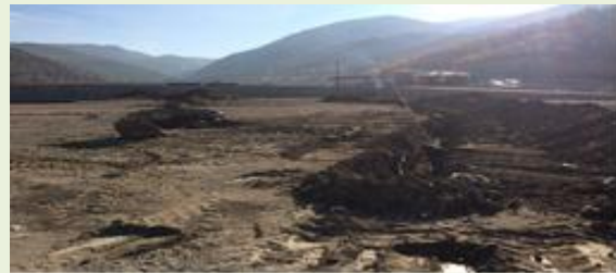
(Şeyhçui Mah. Yağmur suyu hat çalışması)
