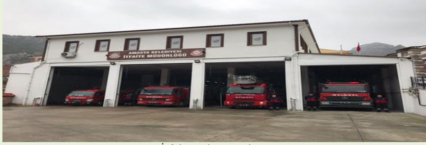
İtfaiye Hizmet Binası
