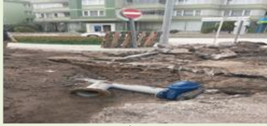
(Hacılar meydanı Mah. İçme suyu hat çalışması)
