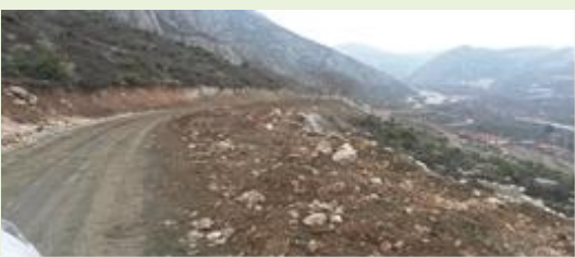
(Sarılar Mah.İçmesuyu hat çalışması)
