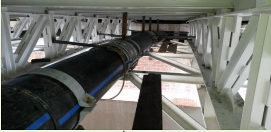
(Depolar arası İçme Suyu hat tamirâtı )
