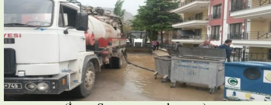
(İçme Suyu arıza çalışması)
