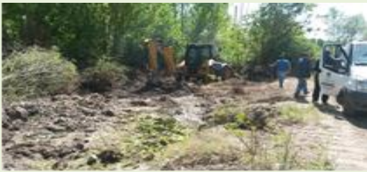
(Helvacı Mah .İçme Suyu hatçalışması)
