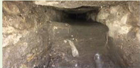
(Hacıilyas Mah. Yağmur suyu hat çalışması)
