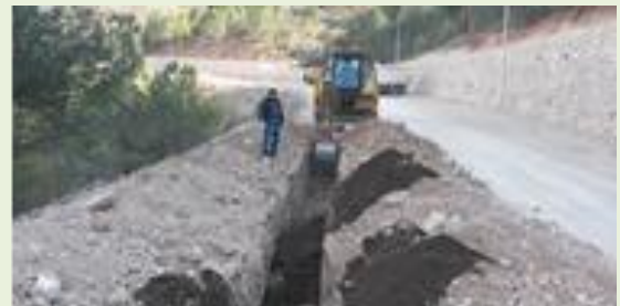
(Şehirüstü Mah.Çakallar Mevki.Hat Çalışması)
