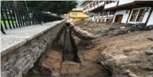
(Hacıilyas Mah.Yağmur suyu hat çalışması)
