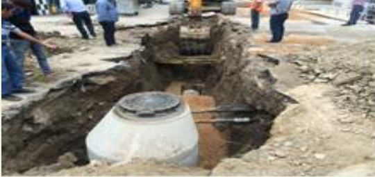
(Hacıarmeydanı Mah. Kanalizasyon çalışması)
