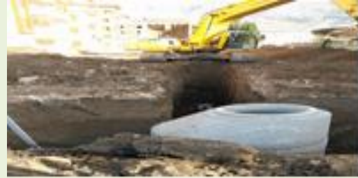
(Hızırpaşa Mah. Kanalizasyon çalışması)
