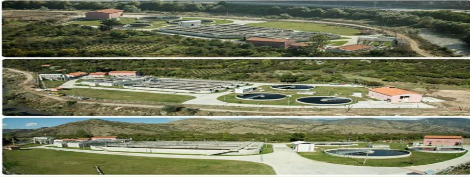
(Amasya Atıksu Arıtma Tesisi)
