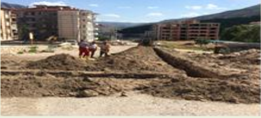
(Şeyhcu Mah.İçme Suyu hat çalışması)
