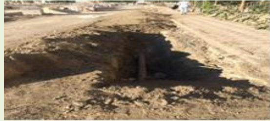
(Ellibeşevler Mah.İçmesuyu hat çalışması)
