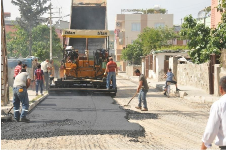
Asfalt yama ve kaplama çalışmaları
