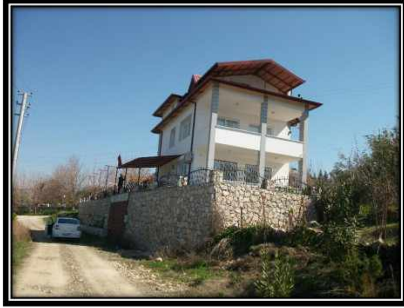
Foto-14: Yapı Tatil Zaptı Düzenlenmiş Bir Kaçak Yapı
