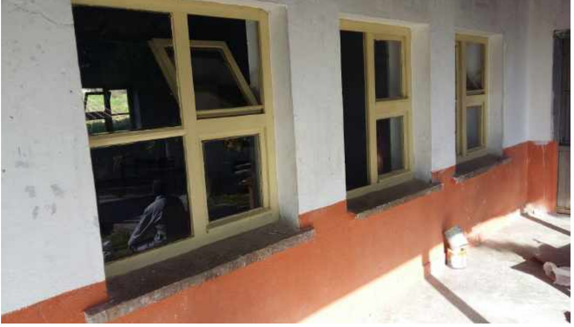
Yakabağ Eski Okul Binasının Boya ve Tadilat İşleri
