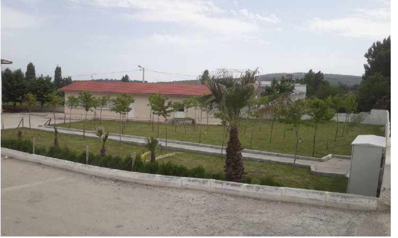
ORTAKÖY İLKOKULU ÇİM EKME ÇALIŞMASI TAMAMLANDI.
