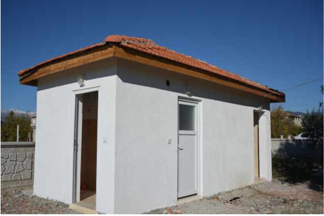
G lpınar Camisinin Tuvaletinin Yapılması, Boya-Badanası.
