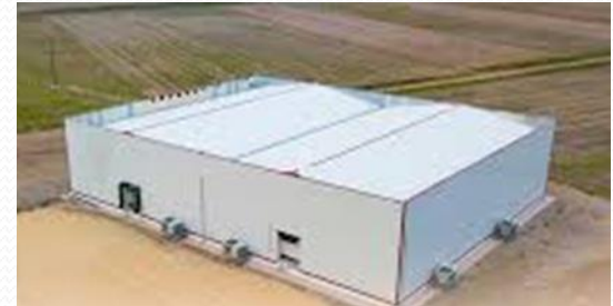
Soğuk Hava Deposu
