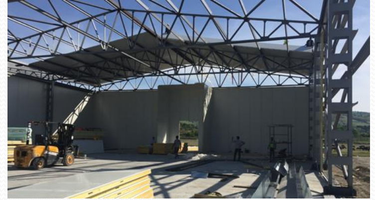
Soğuk Hava Deposu Çelik Çatı Çalışmaları
