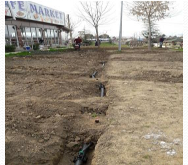
Otomatik Sulama Sistemi Çalışması
