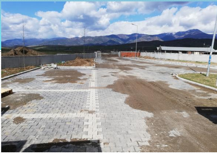
Köpek Barınağı Yeni Hali
