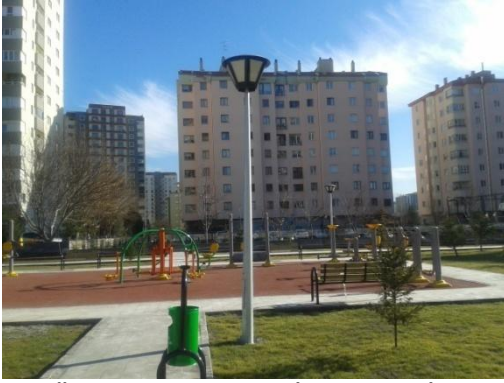
19- G.Ö.B. SELÇUKLU DANIŞMENTGAZİ VE OSMANLI MAHALLELERİ YAYA YOLU OTO PARK VE TAŞ DUVAR YAPILMASI İŞİ
