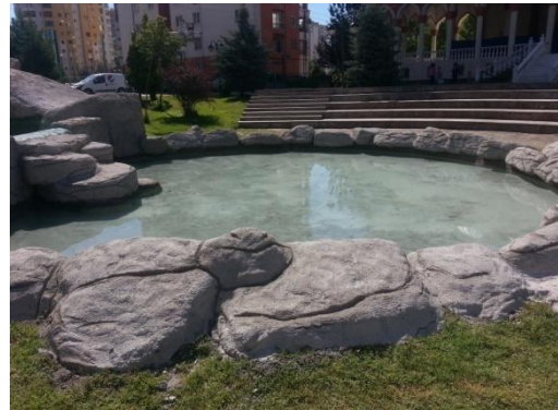
21- NURİHAS, KÜÇÜKALİ ÇORAKÇILAR, AYDINLIKEVLERHÜRRİYET, YENİKÖY, ALTINOLUK KEMERALTI, BATTALGAZİ, ESENYURT TACETTİN VELİ MAH. YAYA YOLU VE ÇEVRE DÜZENLEMESİ YAPILMASI İŞİ YAKLAŞIK MALİYET: 384.166,36 TL SÖZLEŞME BEDELİ: 264.547,40 TL
