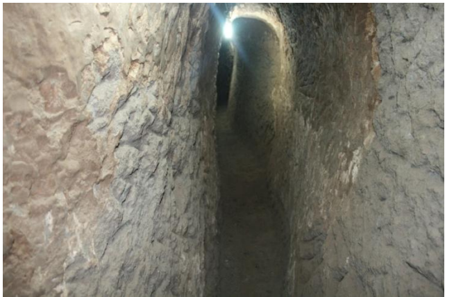
AÇILAN TÜNELLERDEN GÖRÜNÜM
