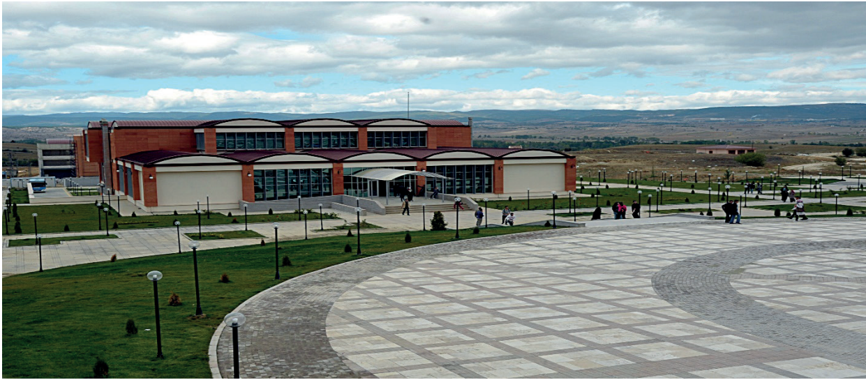
Resim 1- Kastamonu Üniversitesi Merkez Kafeterya Görünüm.
