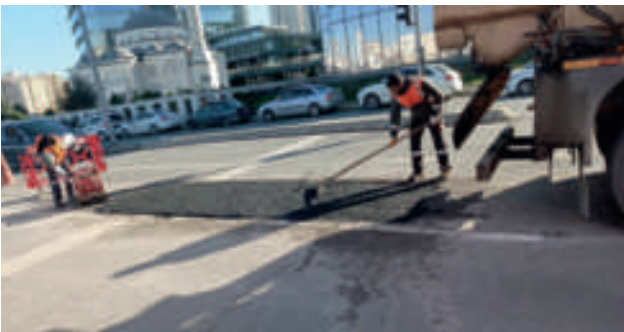
Atatürk Mahallesi Rifat Danışman Sokağı Asfalt Yama Kaplama Çalışması
