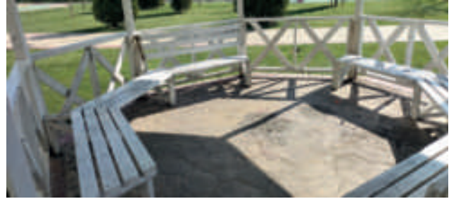
Parklarda Bakım Onarım Çalışması (Şehit Jandarma Er Fatih ÇAYBAŞI Parkı Ahşap Kemerliye Yenileme Çalışması)
