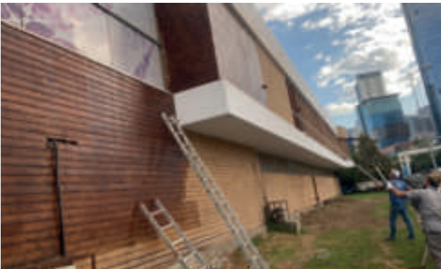
Erdal Eren Kültür Merkezi Dış Cephe Ahşap Boya İmalatı
