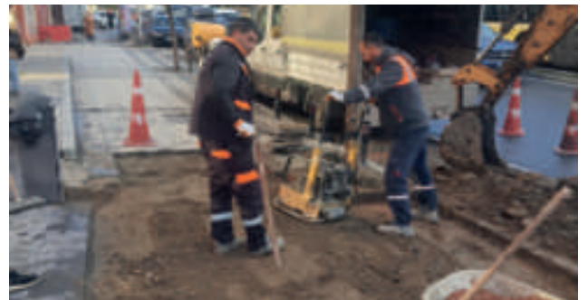
Esatpaşa Mahallesi Adnan Menderes Caddesi Kaldırım Tamirâtı
