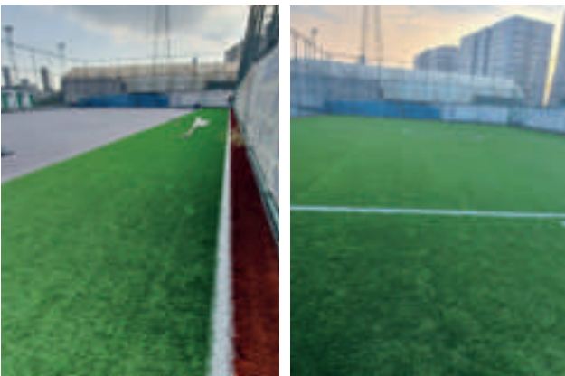
Barbaros Mahallesi Lale Sokak Üzeri Futbol Sahası-Suni Çim Hali İle Zemin Yenilendi.
