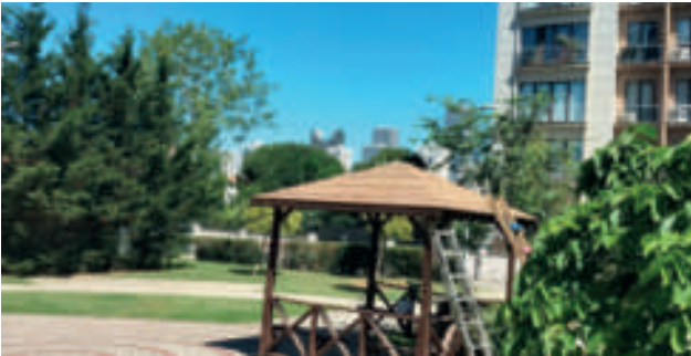
Parklarda Bakım Onarım Çalışması
