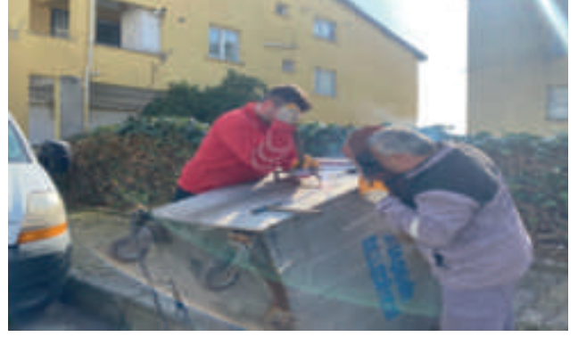
Konteyner Bakım Onarımı
