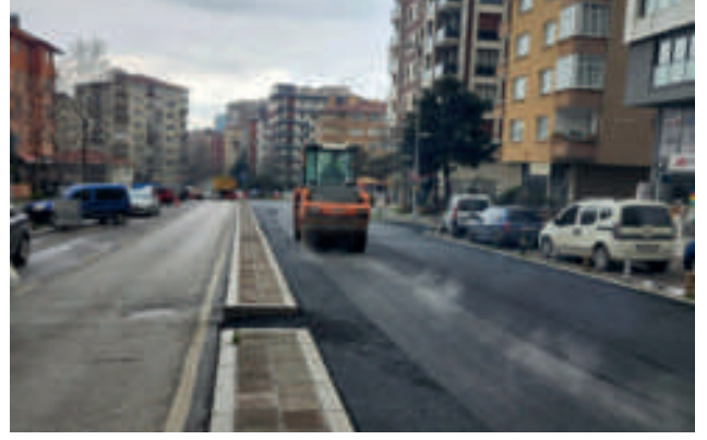
Asfalt Kaplama Çalışması
