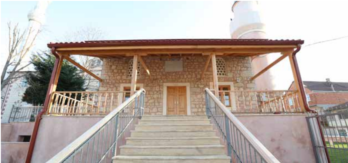
HARAÇÇI CAMİİ RESTORASYONU
