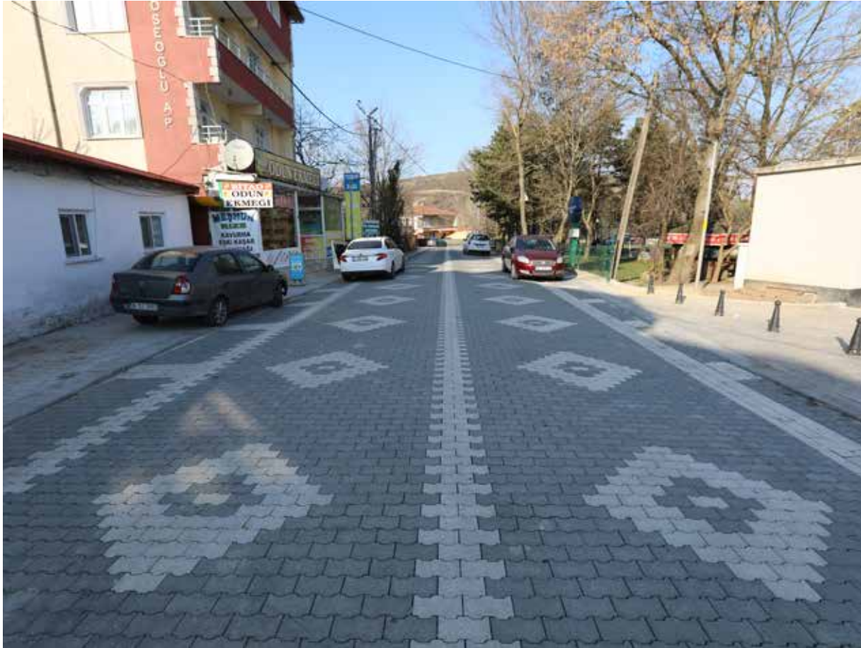
PARKE TAŞI DÖŞENMESİ
