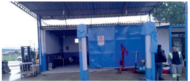
Garaj Amirliği, Bakım - Onarım birimi bünyesindeki atölyeler yenilenerek hizmetin modern ortamlarda daha hızlı ve verimli yürütülmesi sağlanmıştır.
