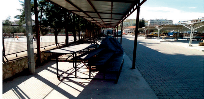
İlçemiz Çarşamba günleri kurulan Semt Pazarı yenileme çalışmaları doğrultusunda Pazar yerinin zemin kısmına beton ve parke taşı döşenerek okul kısmında bulunan Pazar alanlarına pergole yapılmıştır.
