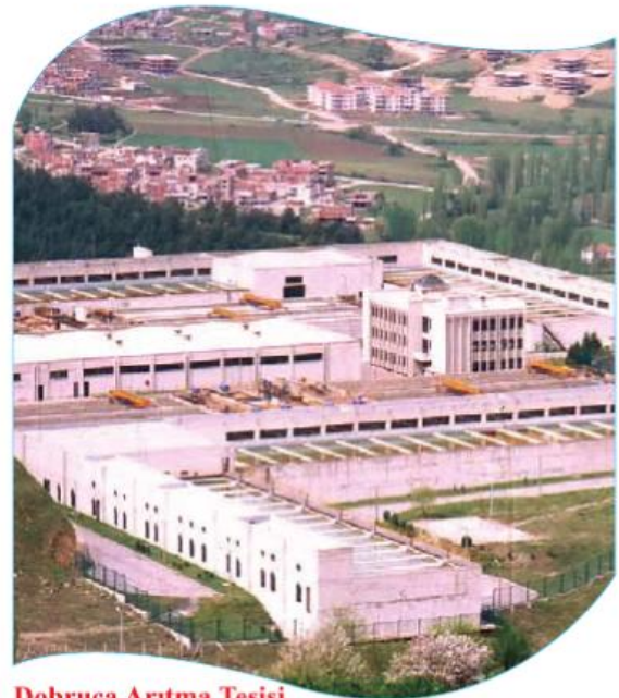
Dobruca Arıtma Tesisleri
