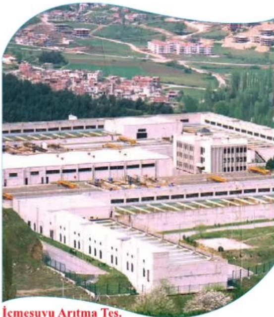
İçmesuyu Arıtma Tes.
