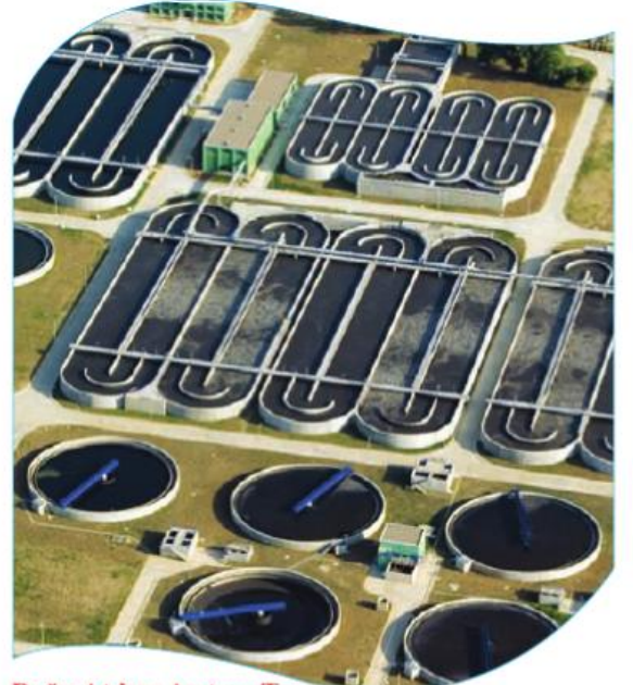
Doğu Atıksu Arıtma Tes.
