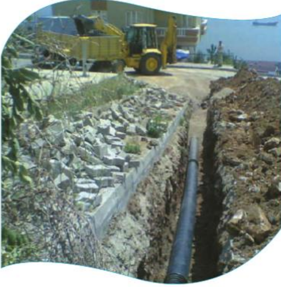
Gemlik Şube Müdürlüğü Altyapı Bakım Onarım İnşaat (2009) Yapım İşi
