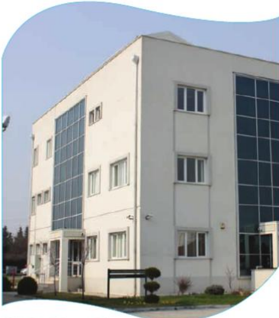
SCADA Hizmet Binası
