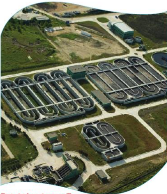
Batı Atıksu Arıtma Tes.
