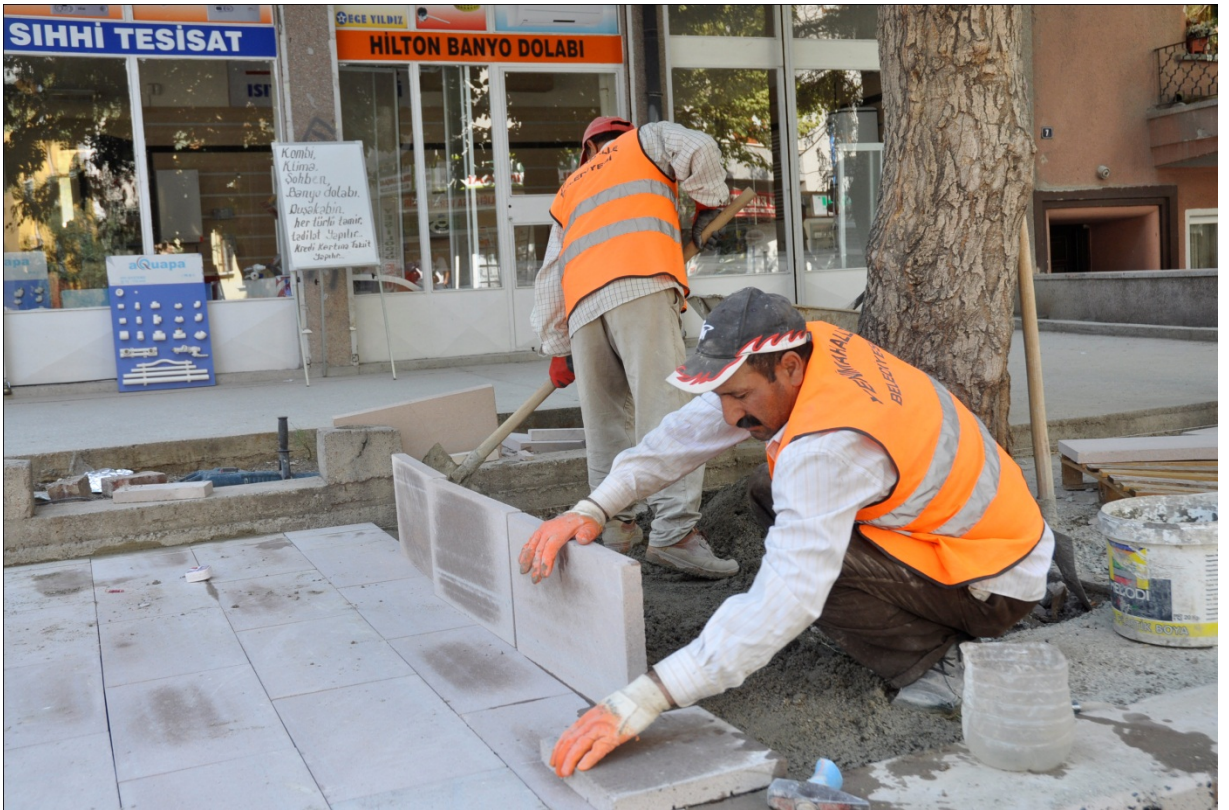
Yaya Yolu-Kaldırım Çalışmaları
