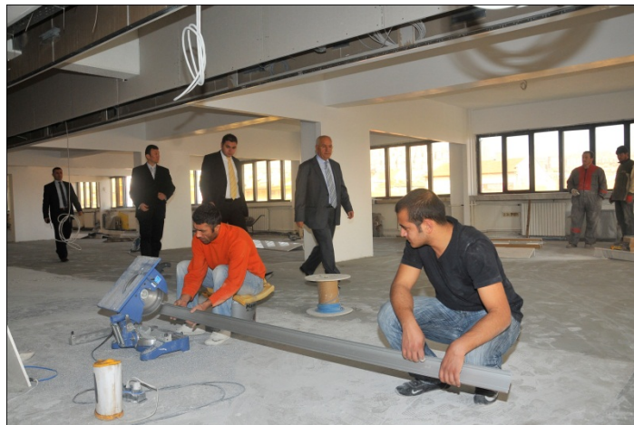
Hizmet Binası 3.Kat Tadilatı
