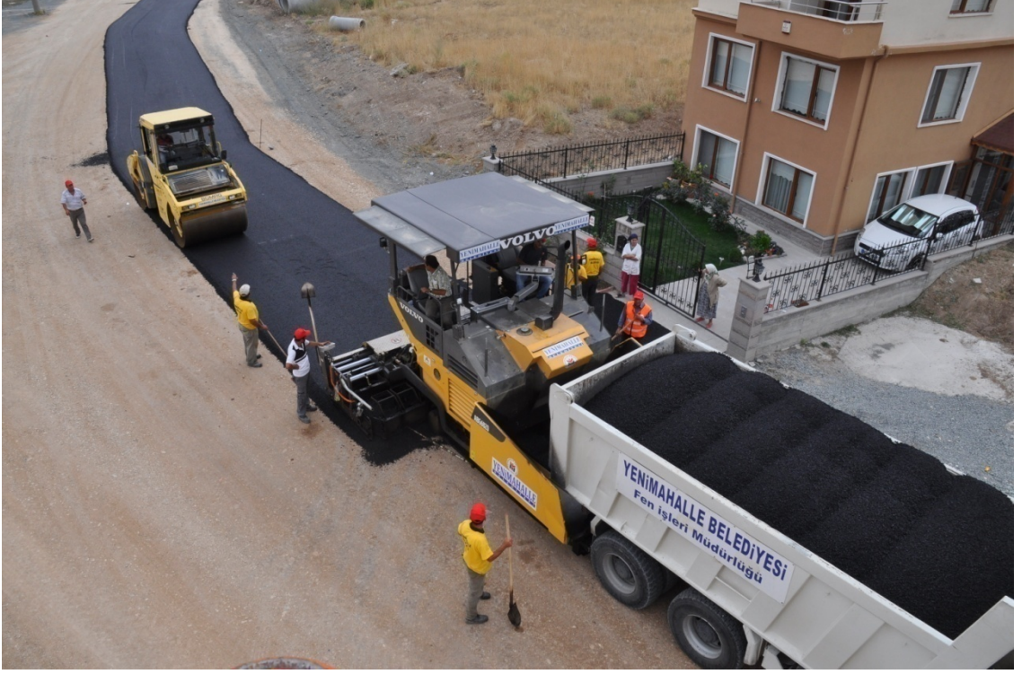
Asfalt Serim Çalışması
