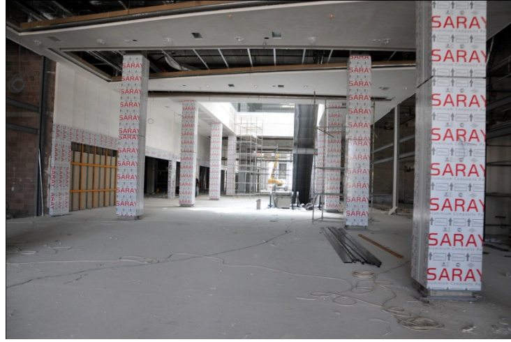
Hizmet Binası Girişı Tadilatı
