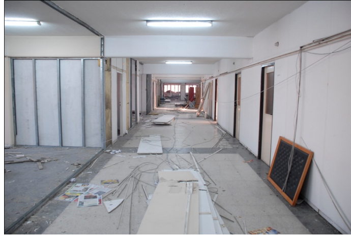
Hizmet Binası 3.Kat Tadilatı
