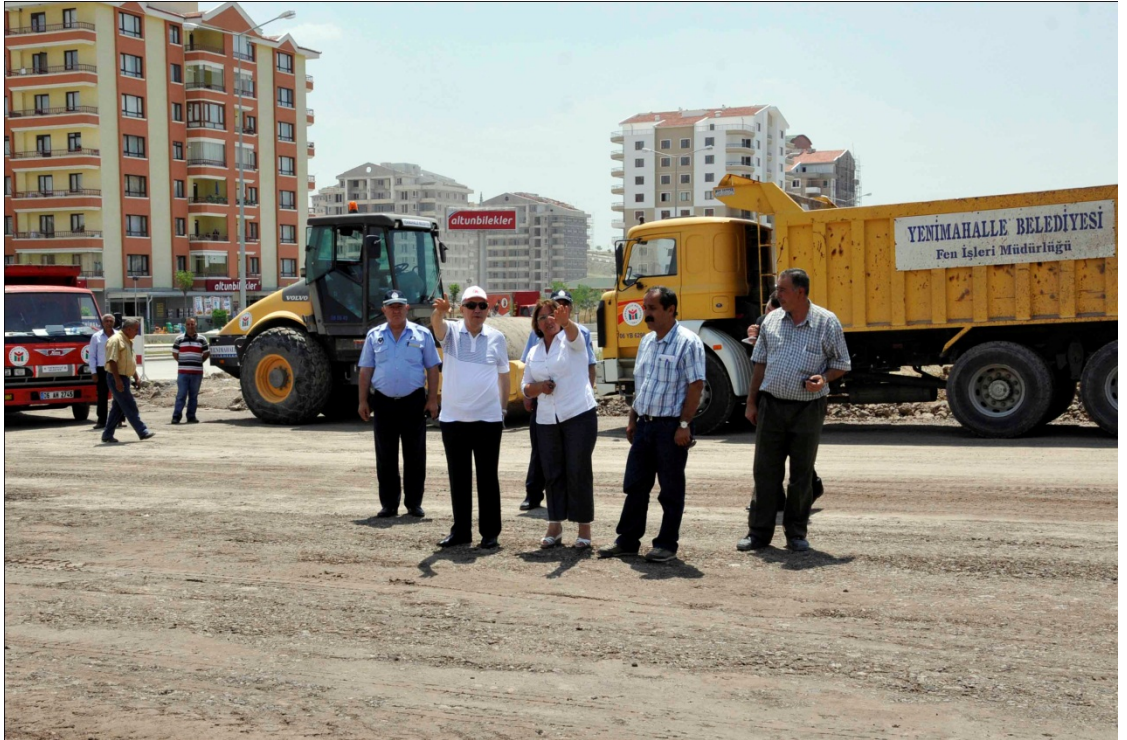
Yol Yapımı Çalışmaları
