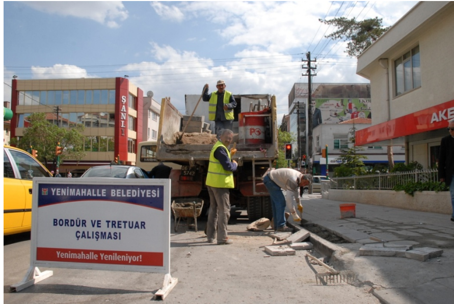
Yenimahallenin Bordür ve Tretuarları Yeniden Yapıldı
