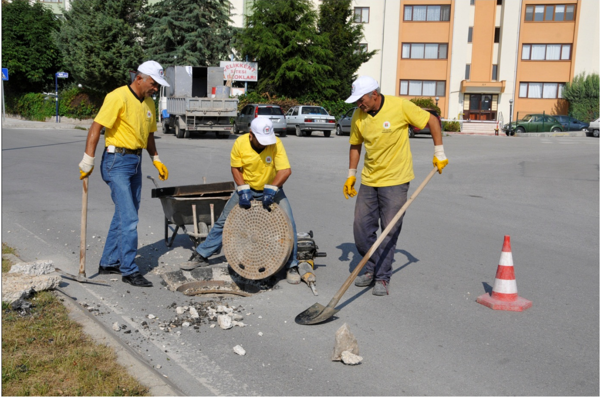
Kanal Yapımı Ve Tadilatı Çalışmaları
