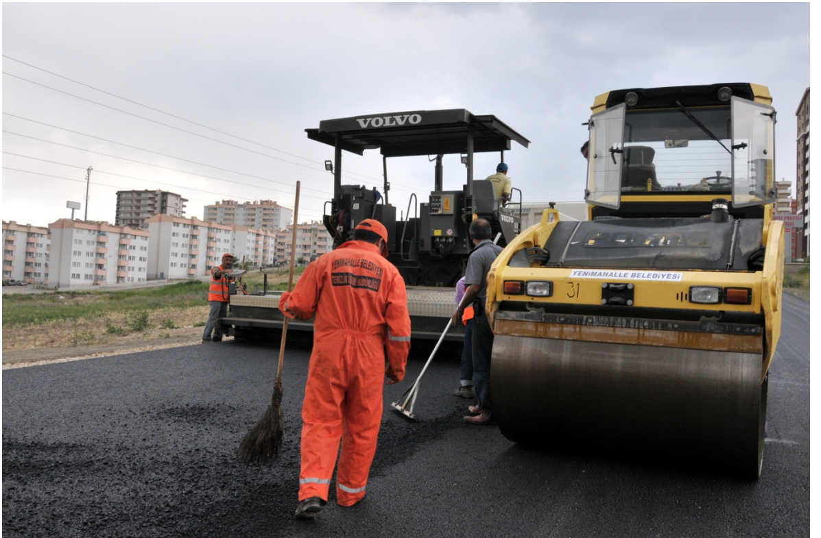
Asfalt Serimi Çalışmaları Çalışmaları
