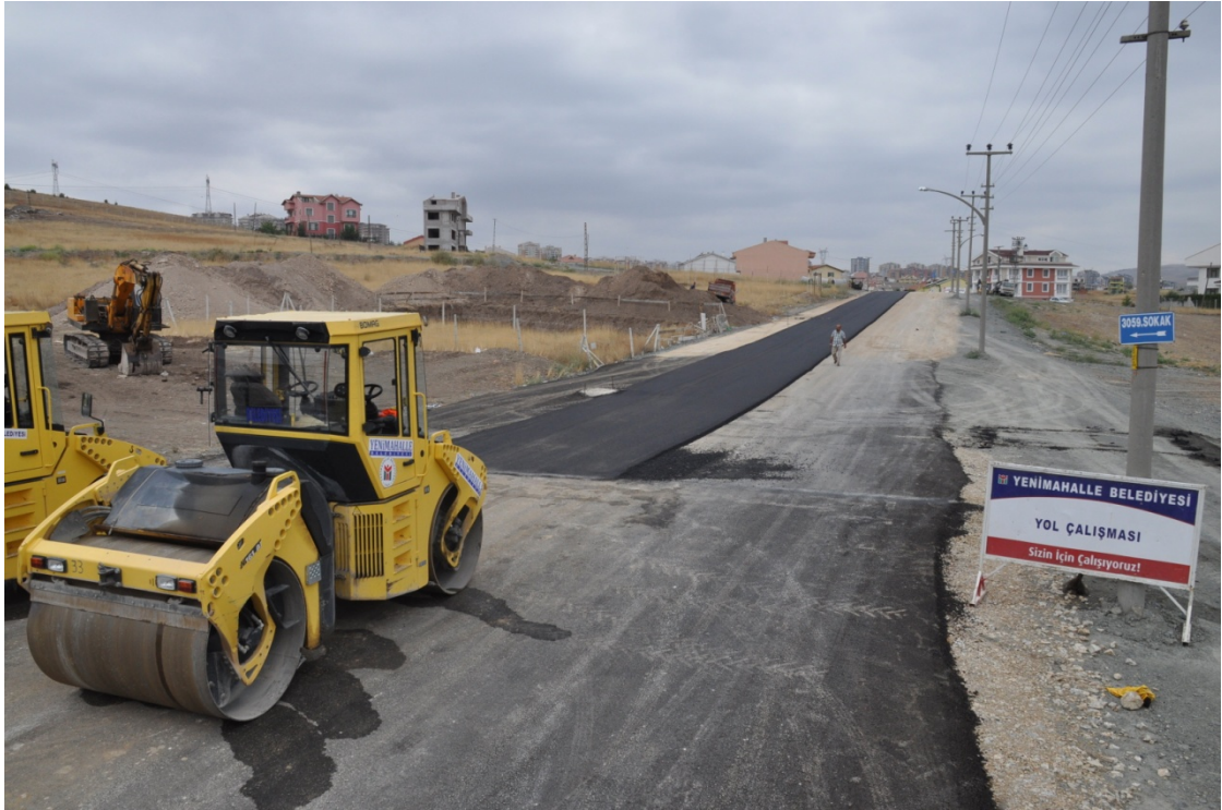
Asfalt Serim Çalışması
