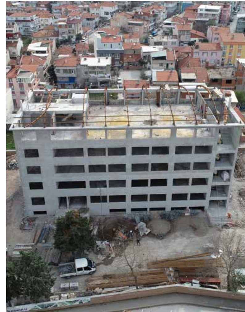
Sakarya 24 Derslikli İlköğretim Okulu
