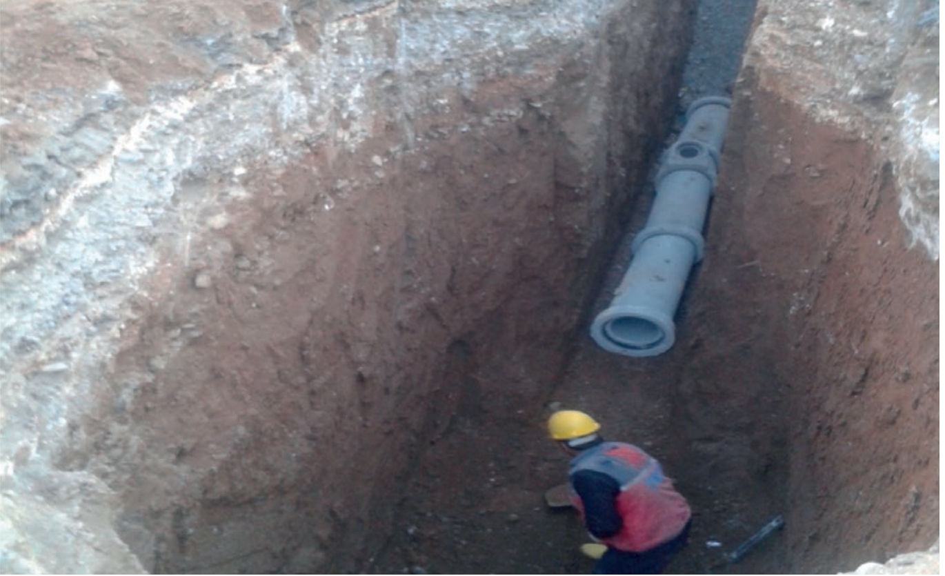
Nizip İlçesi Suboyu Mahallesi 5000 metre kanalizasyon hattı döşemesi yapılmış olup, çalışmalar devam etmektedir.
