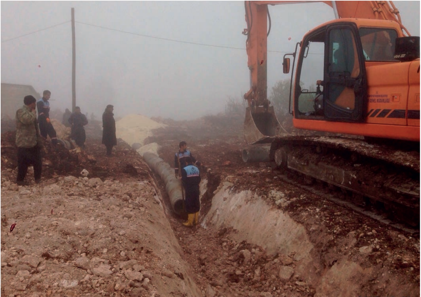
Yavuzeli İlçesi Keşrobası Mahallesi kanalizasyon şebekesi döşenmesi
