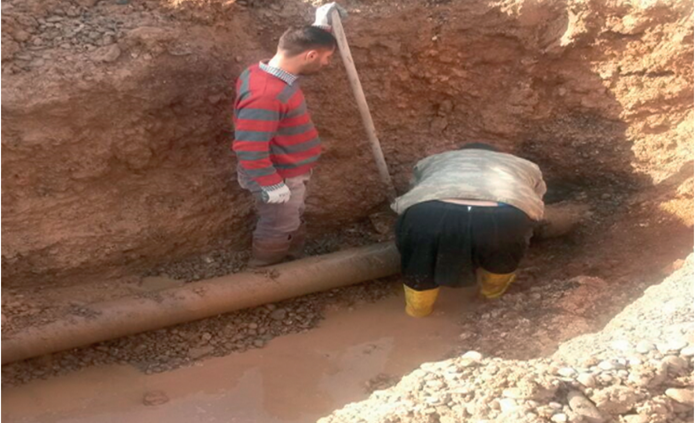
Çarşı Mahallesi 200 lük koruge boru döşenmesi
