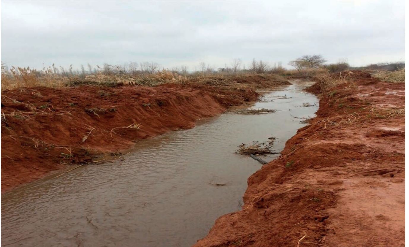
Oğuzeli İlçesi Sazgın Mahallesi Dere Temizliği
