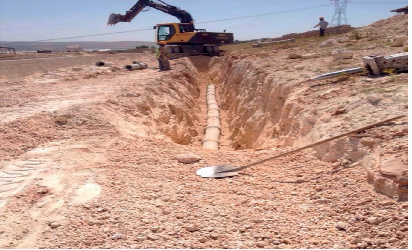
Şehitkamil İlçesi Atabek Mahallesi Kanalizasyon Hattı Çalışması
