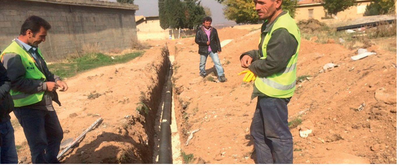
Çavuşbaşı Mahallesi Kanalizasyon Şebeke Yenileme Çalışmaları
