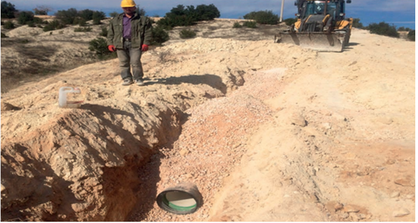
Nizip İlçesine yeni açılan kuyu bağlantısı için Ø300 mm 2877 metre Ductil boru döşenmiştir.
