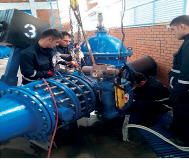
4. 41.500 metre ana isale hat yolu komple bakıma alınmış yol üzerinde oluşan deformeler giderilmiştir.
