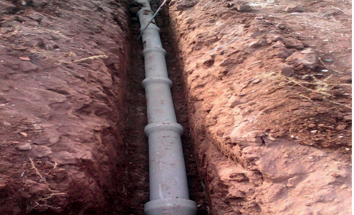
Araban İlçe Merkezine 1257 metre Ø200 beton boru ve 696 metre Ø300 beton boru döşenmiştir.
