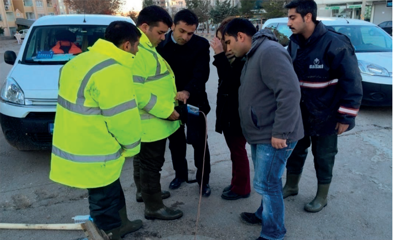
GAZİ MUHTAR PAŞA BULVARIN DA YAPILAN ALT YAPI TESPİT ÇALIŞMASINDAN SONRA BORU DEĞİŞİM SİRASIN DA Q800 BORUNUN YER TESPİTİNİN KONTROLÜ
