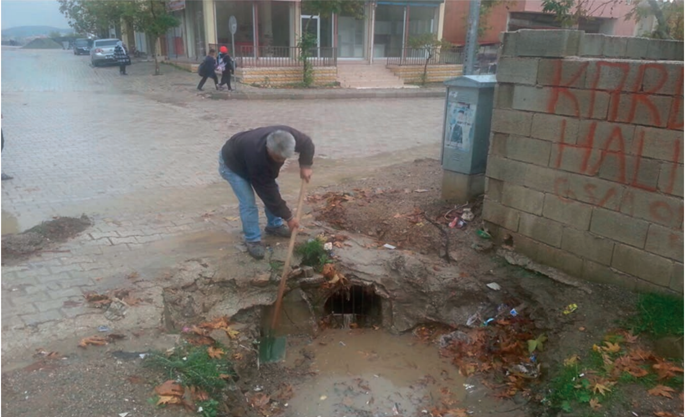
Yamaçoba mahallesi 200 lük çelik boru onarımı
