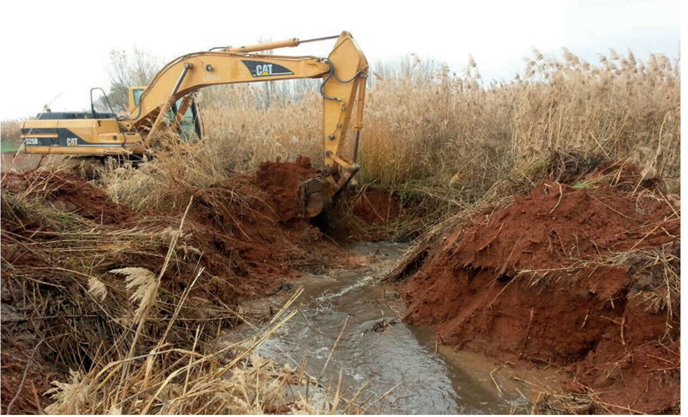
Oğuzeli İlçesi Sazgın Mahallesi Dere Temizliği
