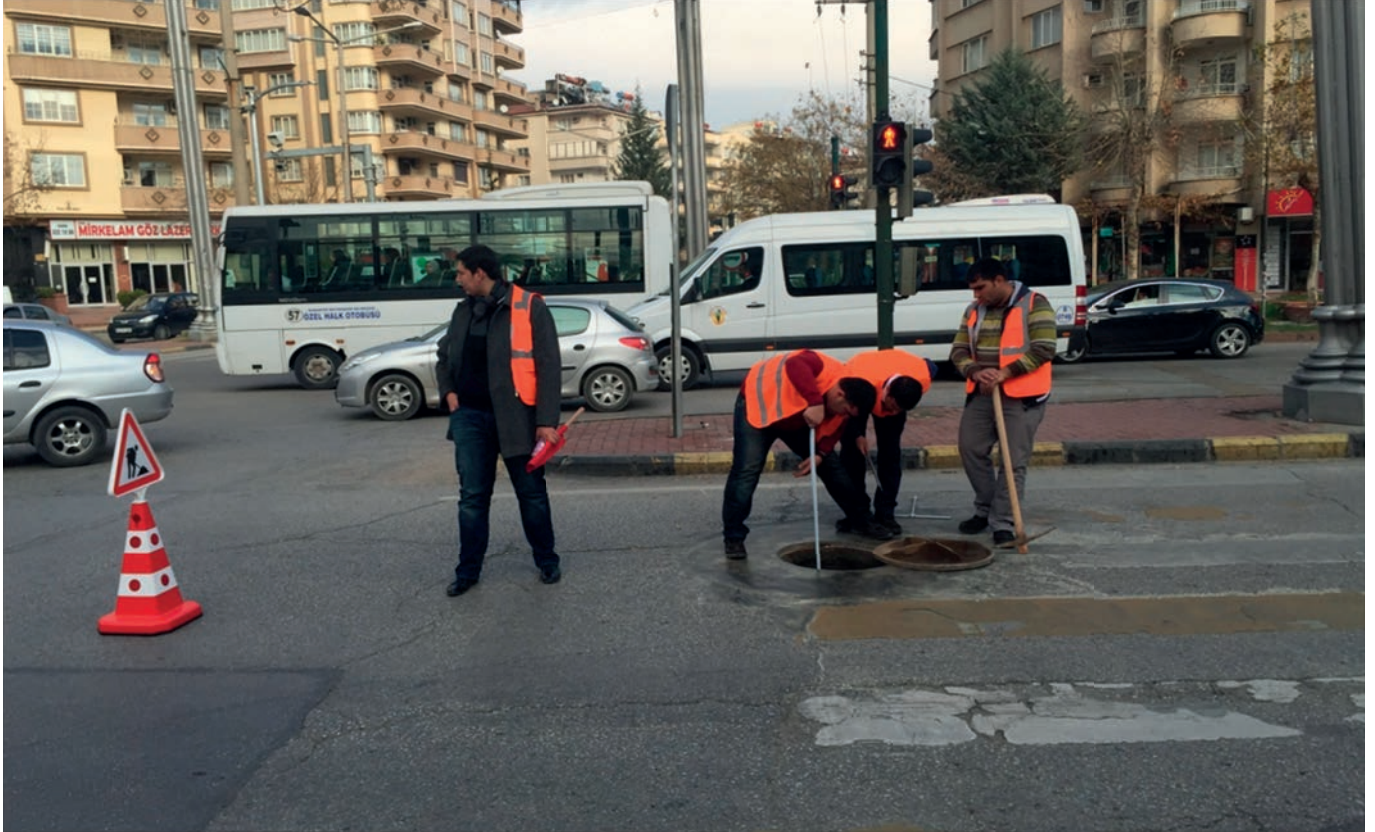
Q1000 kolektör hattının geçiş güzergahları üzerinde ki kavşak çalışması
