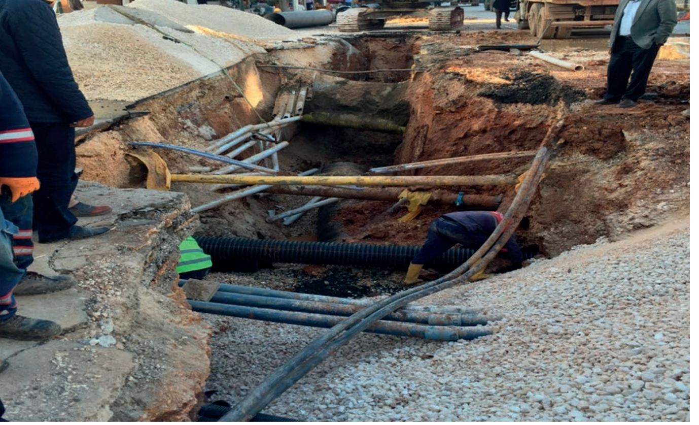
GAZİ MUHTAR PAŞA BULVARIN DA YAPILAN ALT YAPI TESPİT ÇALIŞMASINDAN SONRA BORU DEĞİŞİM SİRASIN DA Q800 BORUNUN YER TESPİTİNİN KONTROLÜ
