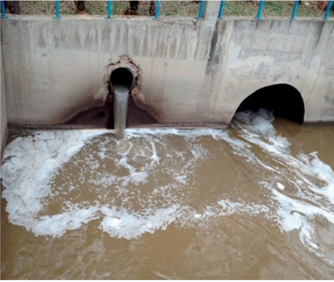
Merkez Atık su Arıtma Tesisi Giriş Yapısı
