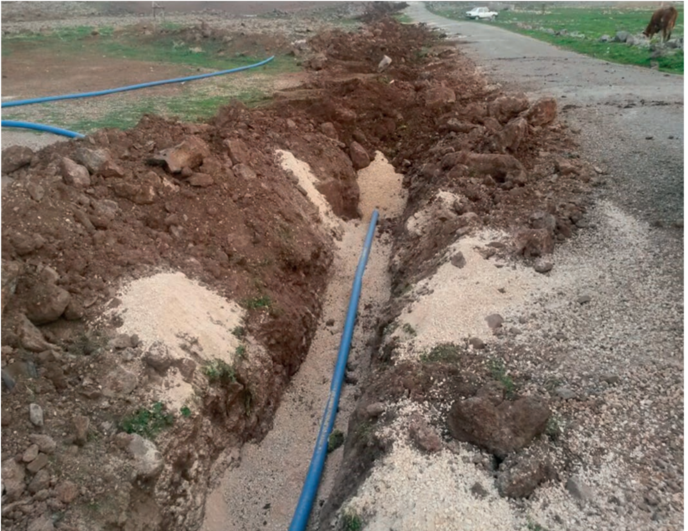
Şehitkamil İlçesi Seymenli Mahallesi Aşağı İmolar mezarası 1150 metre PE boru döşemesi
