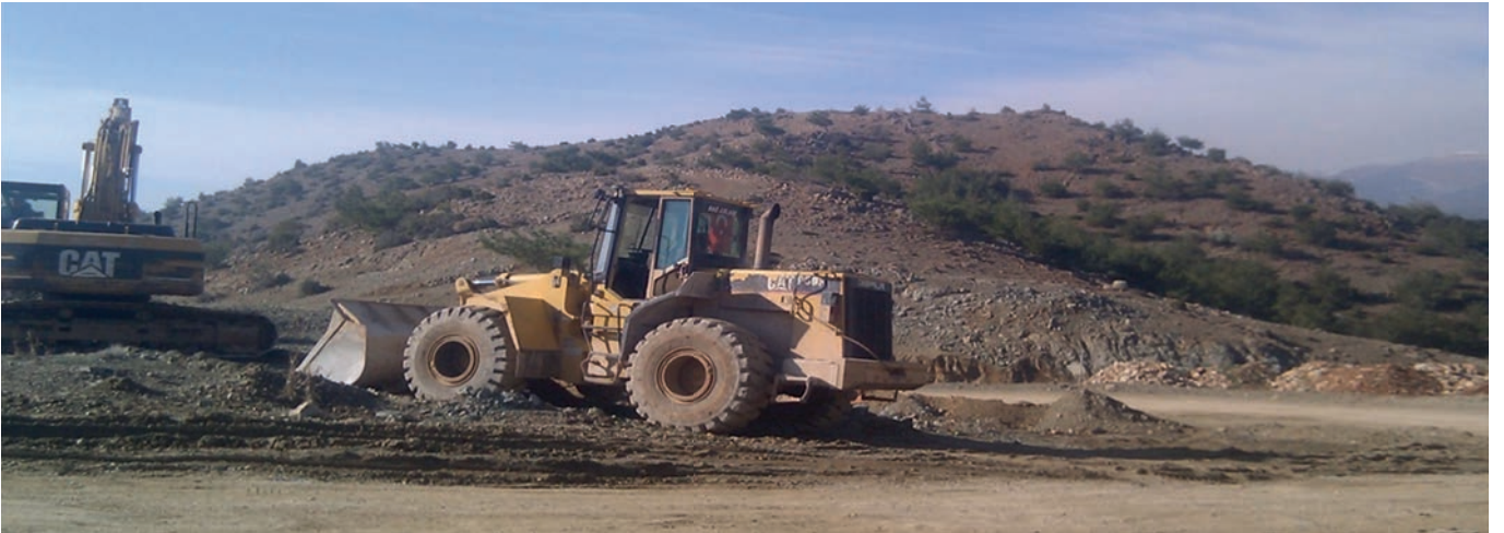
Yazıbağ mah. yeni sondaj kuyusu için yol yapımı
