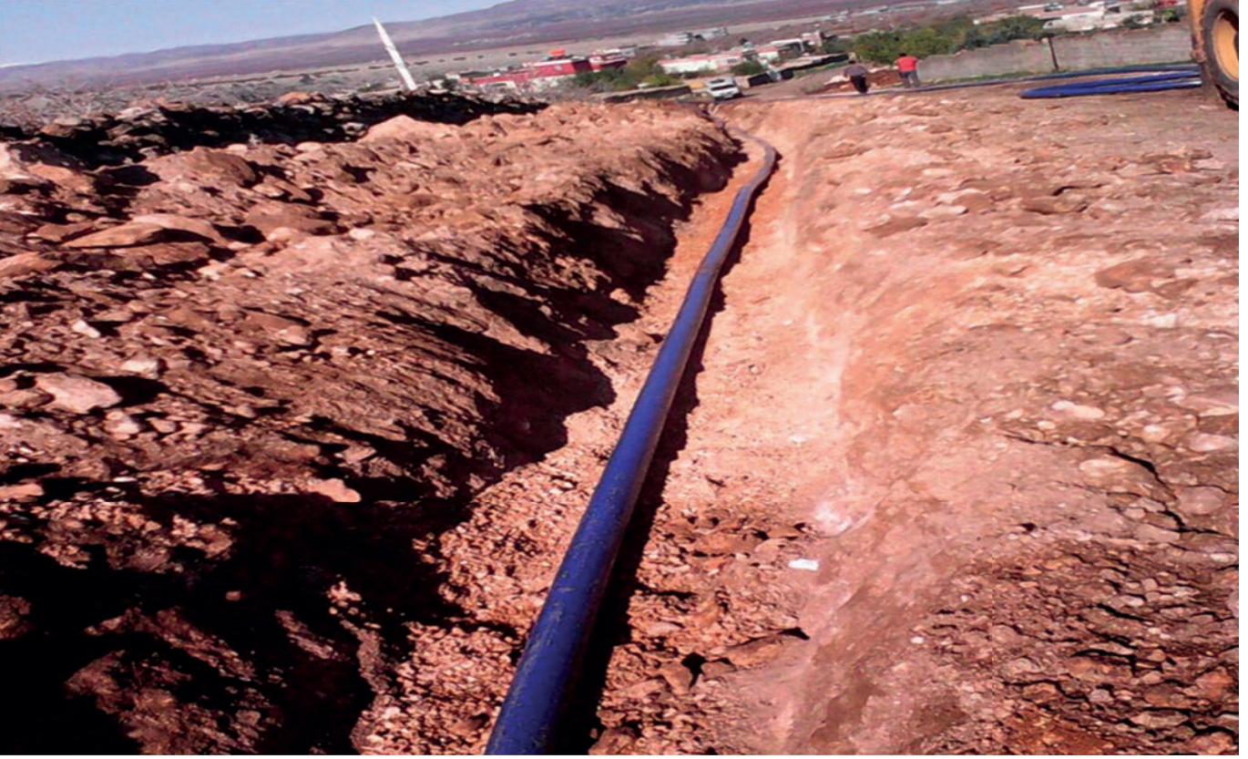
Araban İlçesi Saritepe Mahallesi yeni kuyu terfi hattı bağlantısı
