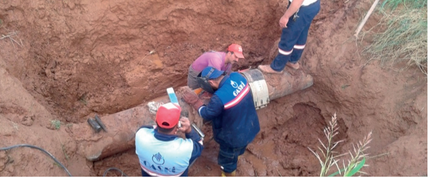
Gündoğan Mahallesi İçmesuyu Arıza Çalışması
