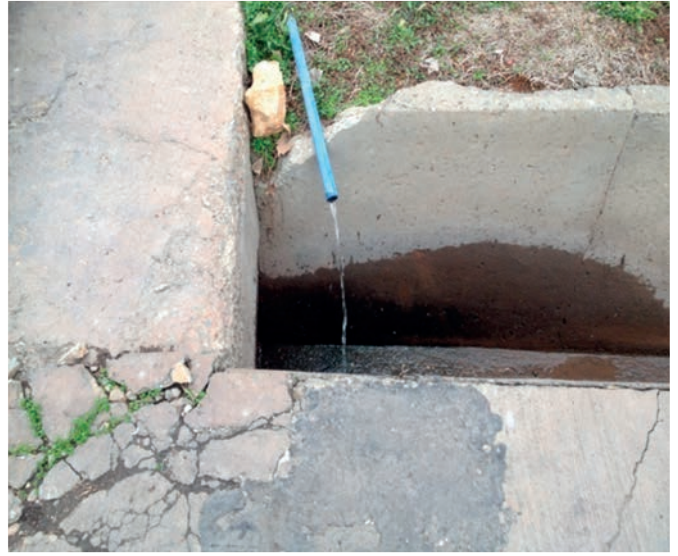
Merkez Atık Su Arıtma Tesisi Çıkış suyu
