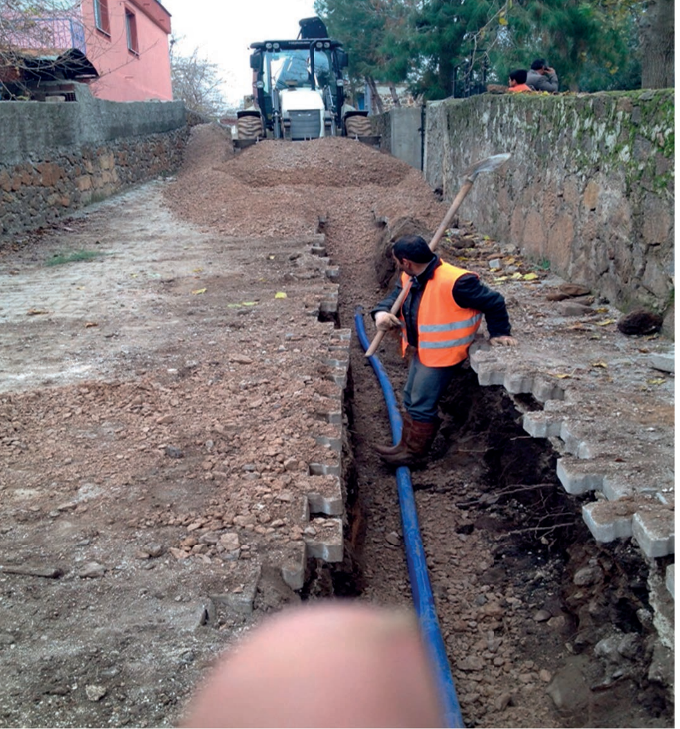
YukarıBilenler Mahallesiinde 5000 metre PE Boru döşenmesi
