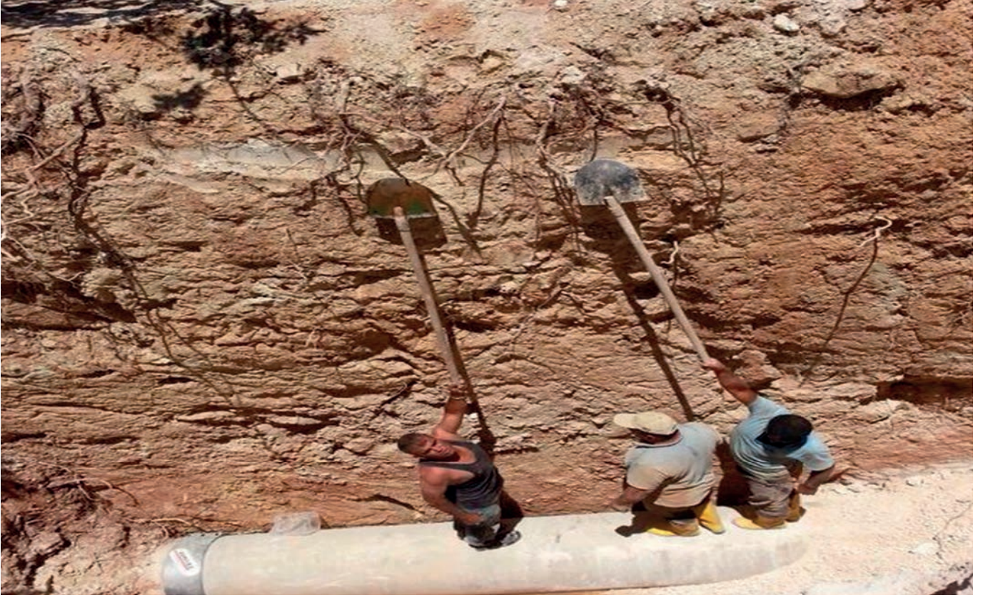
Nizip İlçesi Ø600 lük Terfi Hattı Çalışması
