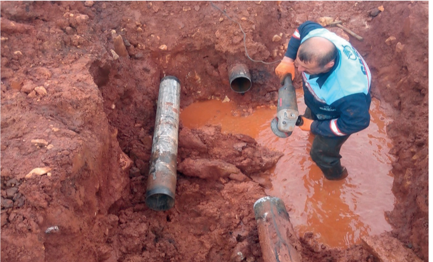
Yamaçoba mahallesi 200 lük çelik boru onarımı
