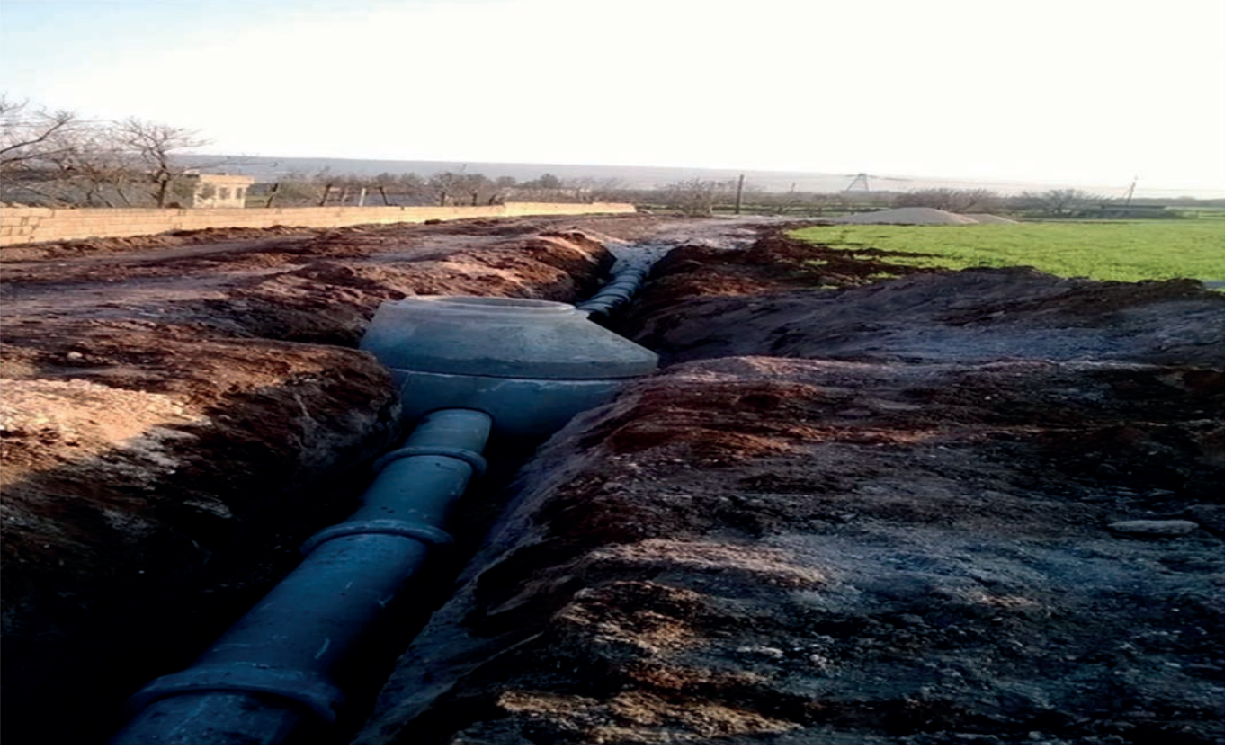
Yavuzeli ilçe merkezine kanalizasyon şebekesi döşenmesi
