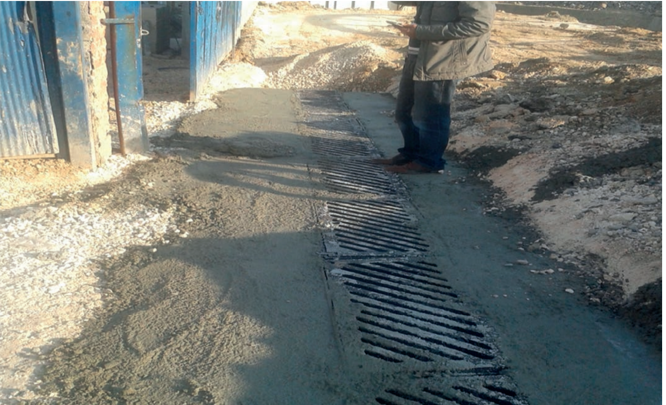
Nizip İlçesi şehir merkezinde 431 metre yağmursuyu hattı döşenmiş olup, yağmursuyu ızgaraları yaptırılmıştır.
