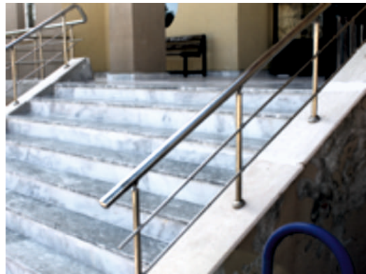
Hozat binasında dış merdivenler mermer kaplama ile yenilenerek wc fayansları onarıldı
