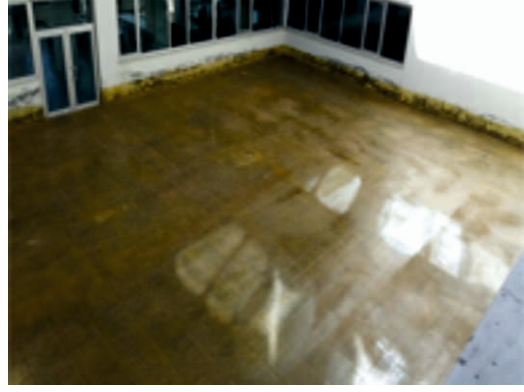
Pertek MYO binası teraslarına su izolasyonu yapıldı
