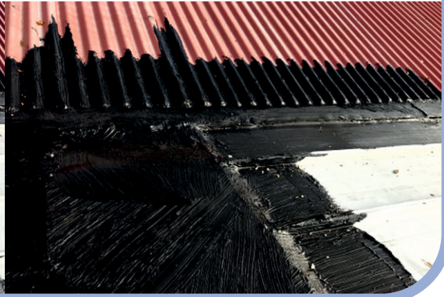
Rektörlük konutu balkon çatısı su yalıtımı yapıldı
