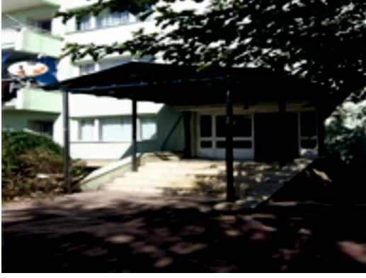
Atatürk mahallesi A-B Blok lojman girişlerine sundurma yapıldı
