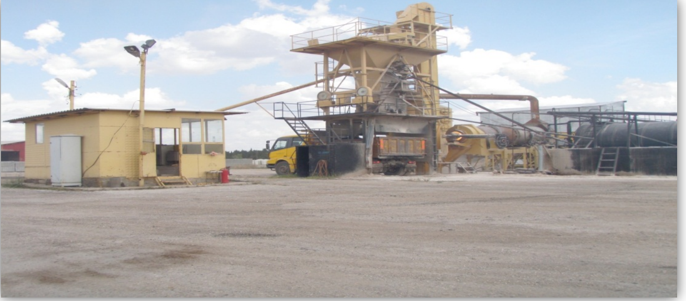
HAVSA ASFALT ŞANTİYESİ
