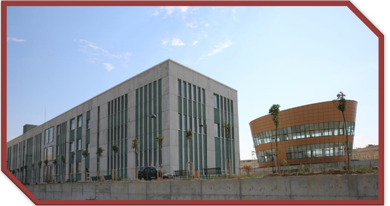
Şekil 25. Uluyazı Yerleşkesi Mühendislik Fakültesinden Bir Kesit.
