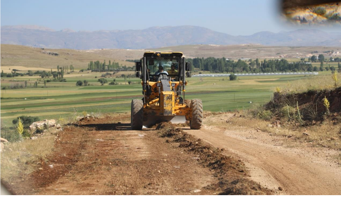
Yeni Açılan Stabilize Yol Çalışması
