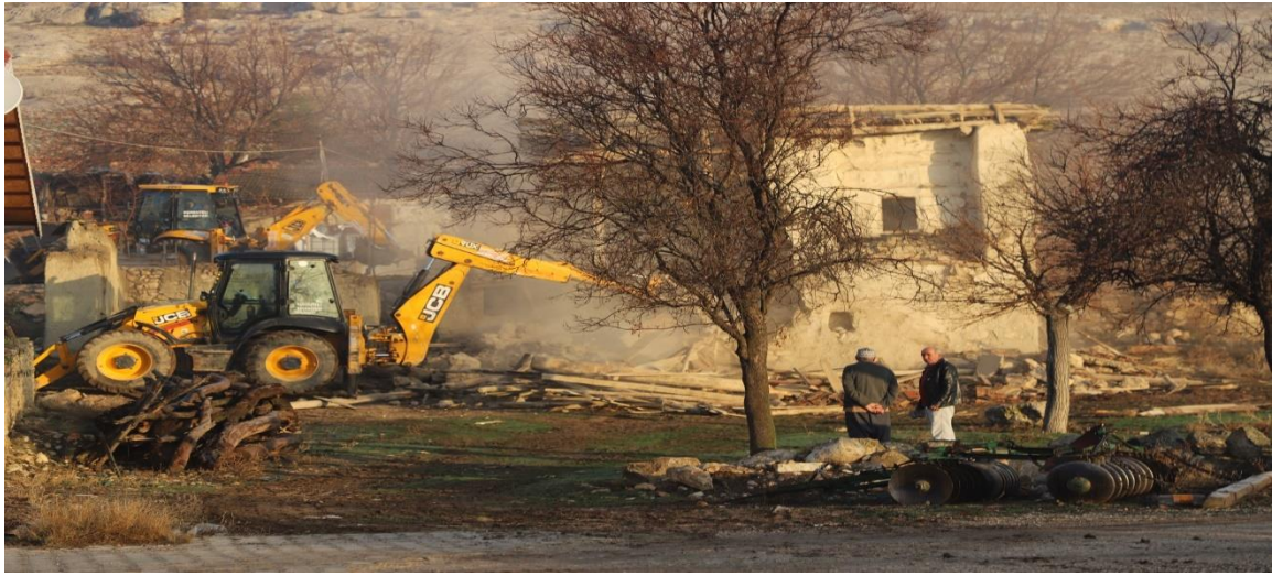
Metruk Bina Yıkım Çalışmaları
