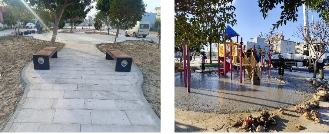
Görsel 13 1 Mayıs Park Yapımı
