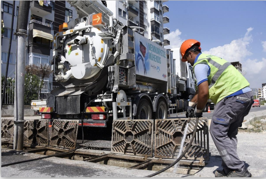
Yağmur Suyu Izgara Temizlik Çalışmaları
