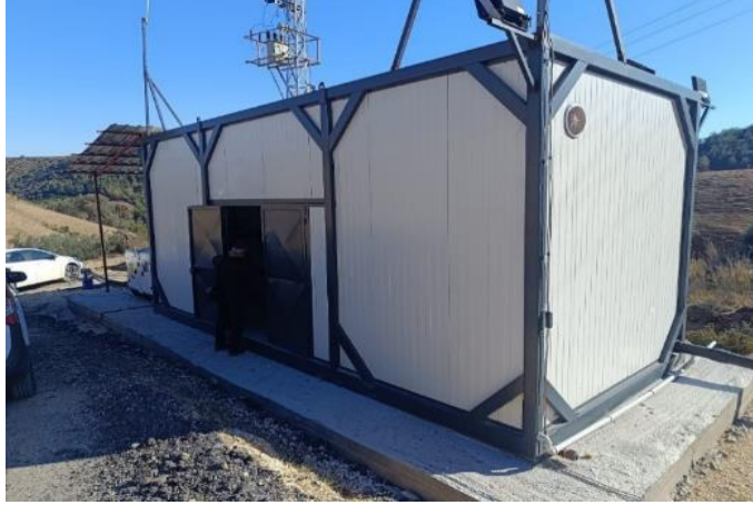
Tarsus Kumdere Paket İçme Suyu Arıtma Tesisi
