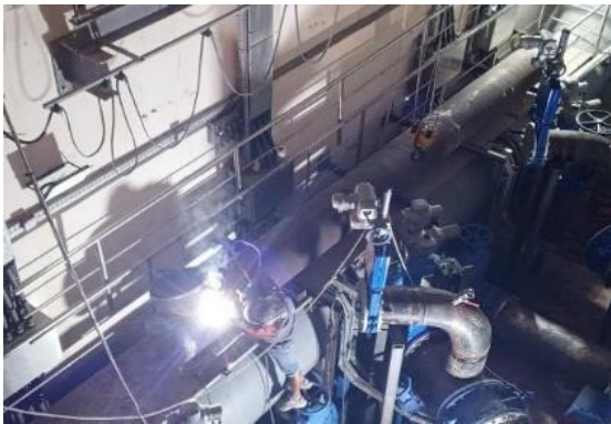
Viranşehir Atıksu Terfi İstasyonunda bulunan 2 ve 3 nolu pompalara Deşarj Terfi İstasyonuna bağlanan yeni hat revizyonu çalışması
