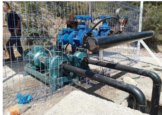
Ayvagediği Sinap Atıksu Terfi İstasyonu yapım çalışması
