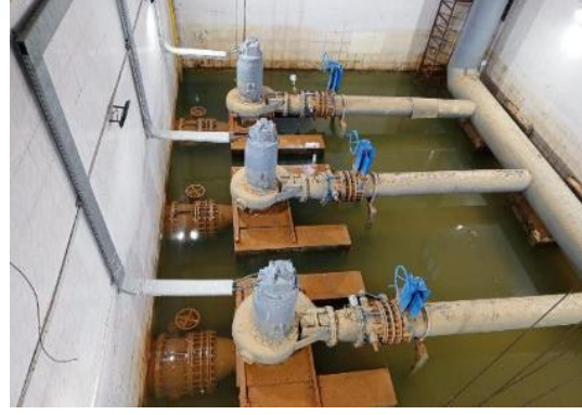
Viranşehir Deşarj Atıksu Terfi İstasyonunda bulunan çürük geçiş hatlarının revizyonu yapılarak su kaçaqları önlendi. Vana grupları yenilendi.
