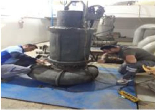
Batı Pompa İstasyonu Hurda pompalarının Flygt Atıksu dalgıç pompalarına revizyonu
