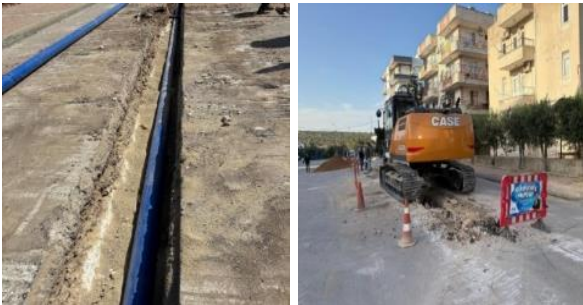
Silifke İlçesi Muhtelif Mahallelerde İçme Suyu ve Kanalizasyon Hattı Yapım İşi
