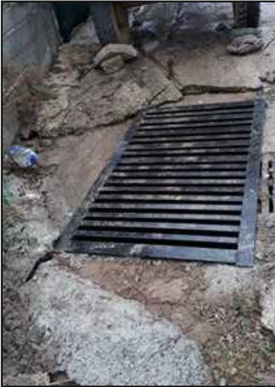
Resim 4 : 311 Nolu Sokak Mazgal Yapımı
