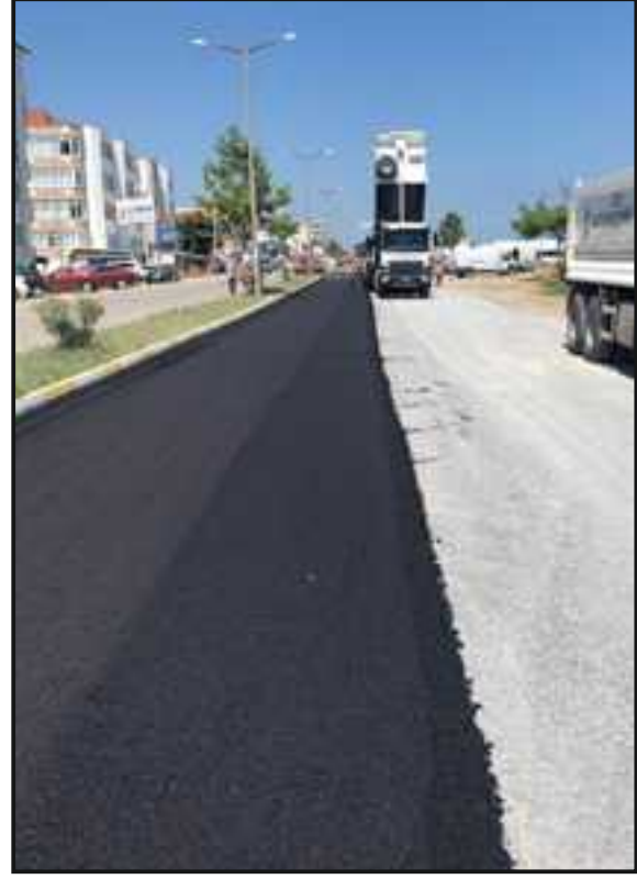
Resim 5 : Doğu Karadeniz Caddesi Sıcak Asfalt
