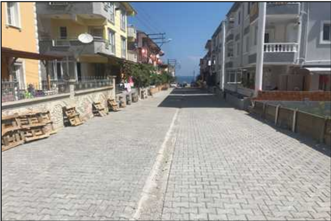
Resim 3: 342 Nolu Sokak Kilitli Parke Çalışması
