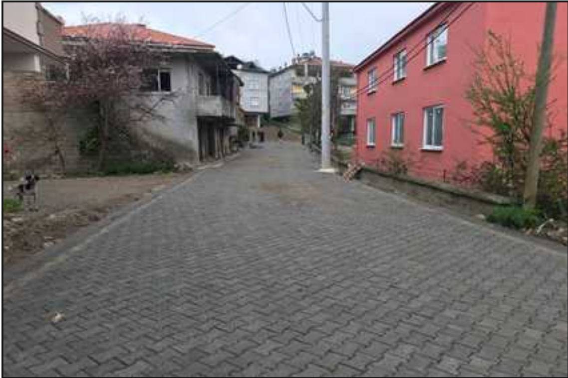
Resim 15 : Hürriyet Mahallesi Kilitli Parke Çalışması
