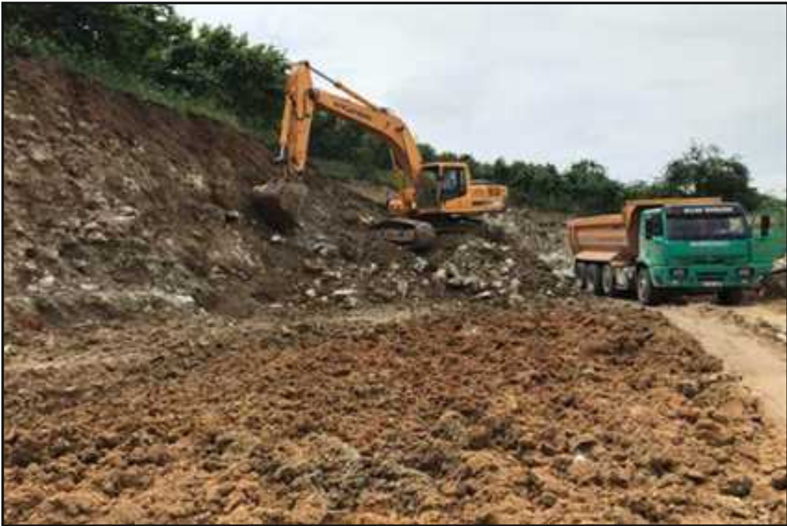
Resim 3 : Bahar Caddesi Taş Duvar Yapımı Öncesi Aplikasyonu
