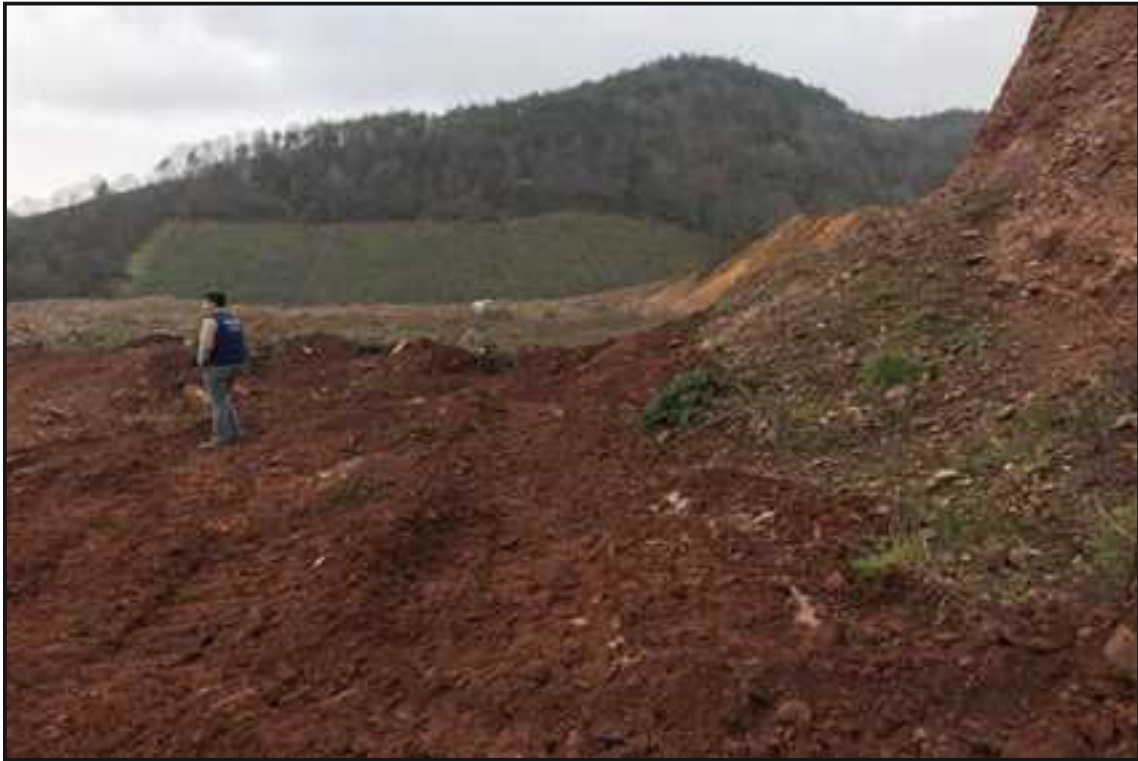
Resim 1 : Karapınar Mahallesi'nde bulunan Ocağın Kademelerinin Alımının Yapılması
