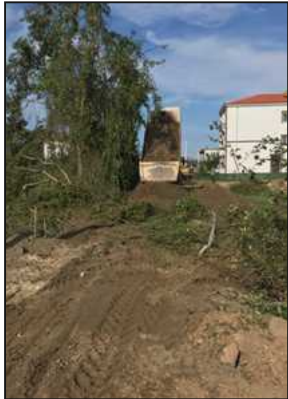
Resim 5 : 326/1 Nolu Sokak Ham Yol Çalışması
