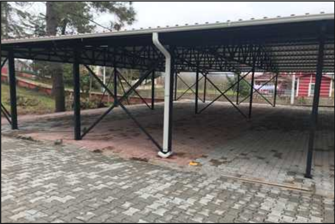
Resim 13 : Kurudere Mahallesi Mezarlık Kilitli Parke Çalışması
