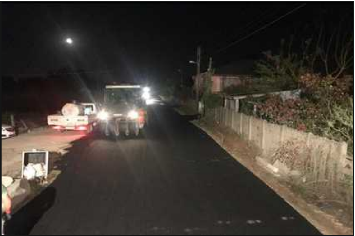
Resim 8 : Gazi Caddesi Sıcak Asfalt Çalışması
