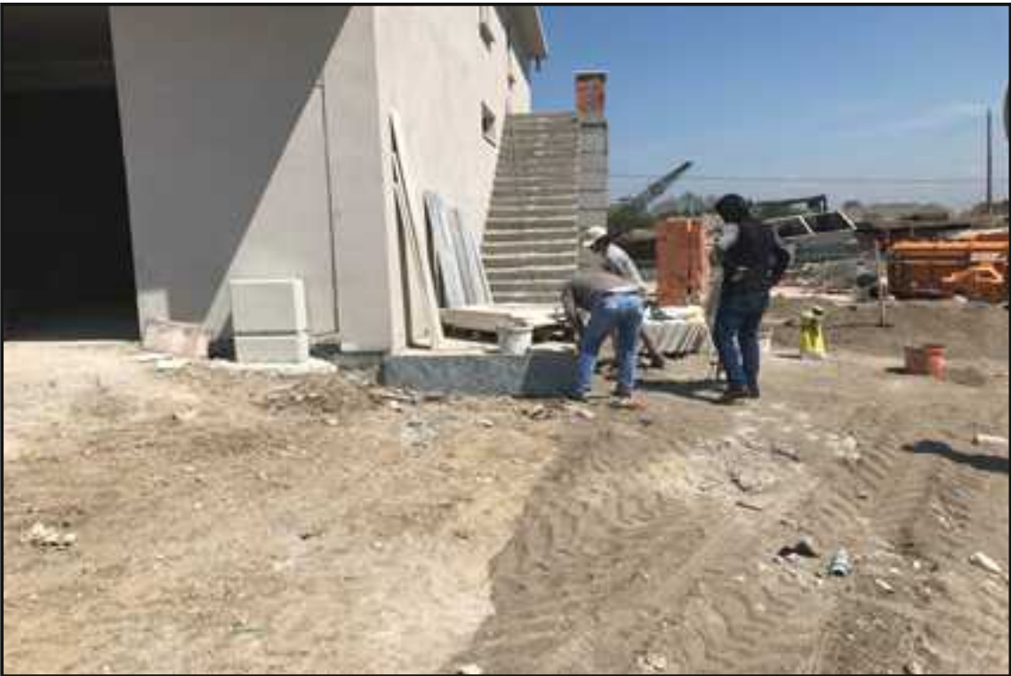
Resim 2 : Şantiye İçi Depo Binası Merdiven Yapımı
