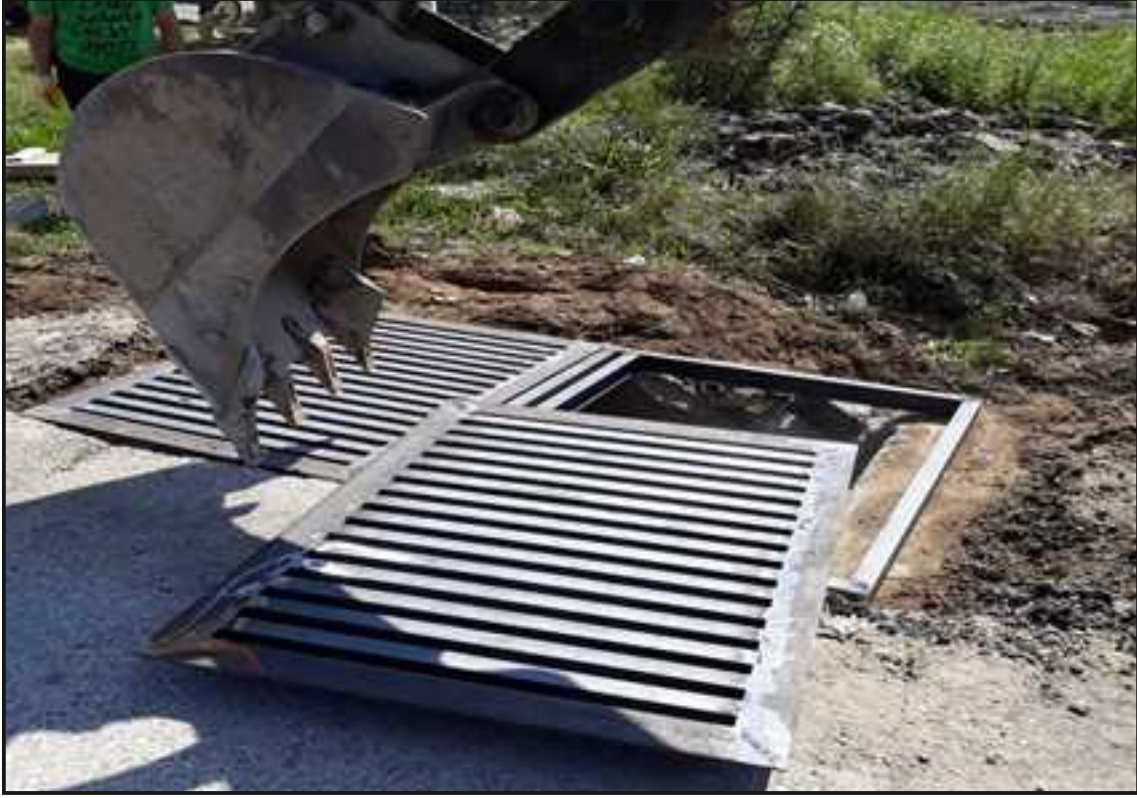
Resim 11 : Mazgal Bakım Onarımı
