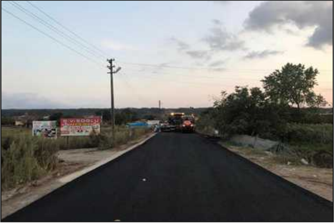
Resim 7 : Gazi Caddesi Sıcak Asfalt Çalışması
