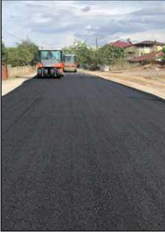
Resim 4 : Gazi Caddesi Sıcak Asfalt Çalışması
