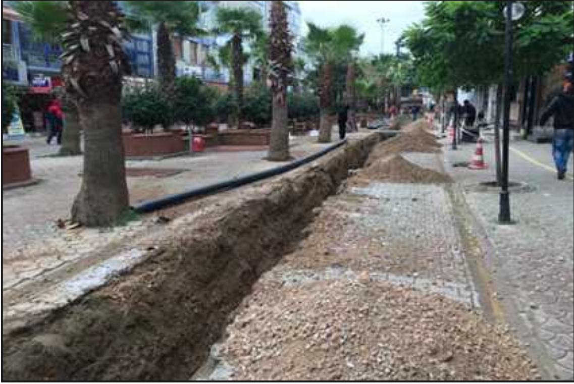
Resim 2 : Atatürk Bulvarı Yağmursuyu Çalışması
