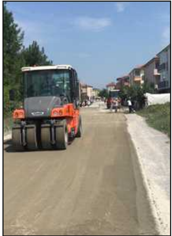
Resim 5 : 810 Nolu Sokak Kuru Yol Beton
