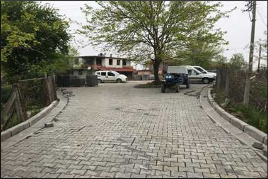
Resim 9 : Yuvalidere Mahallesi Kilitli Parke Çalışması
