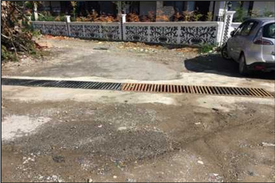
Resim 7 : 609 Nolu Sokak Mazgal Yapımı
