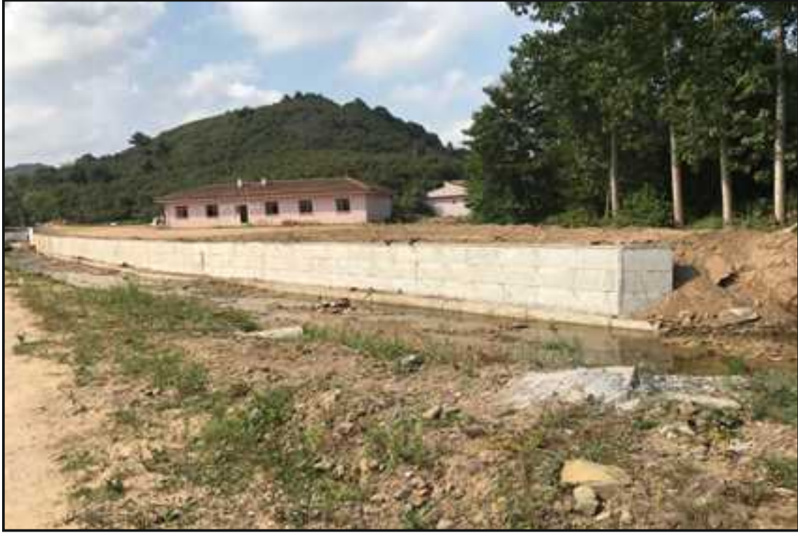
Resim 7 : Yuvalıdere Mahallesi Kilitli Parke Çalışması
