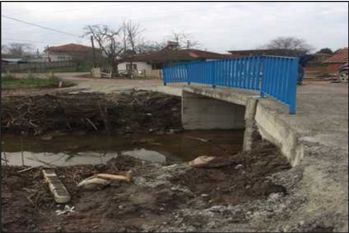
Resim 6 : Küçük Karasu Mahallesi Köprü Yapımı
