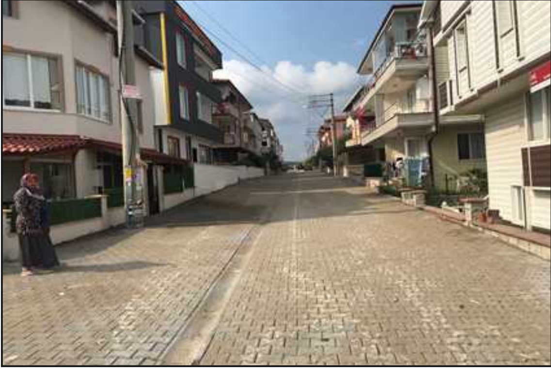
Resim 2 : 341 Nolu Sokak Kilitli Parke Çalışması
