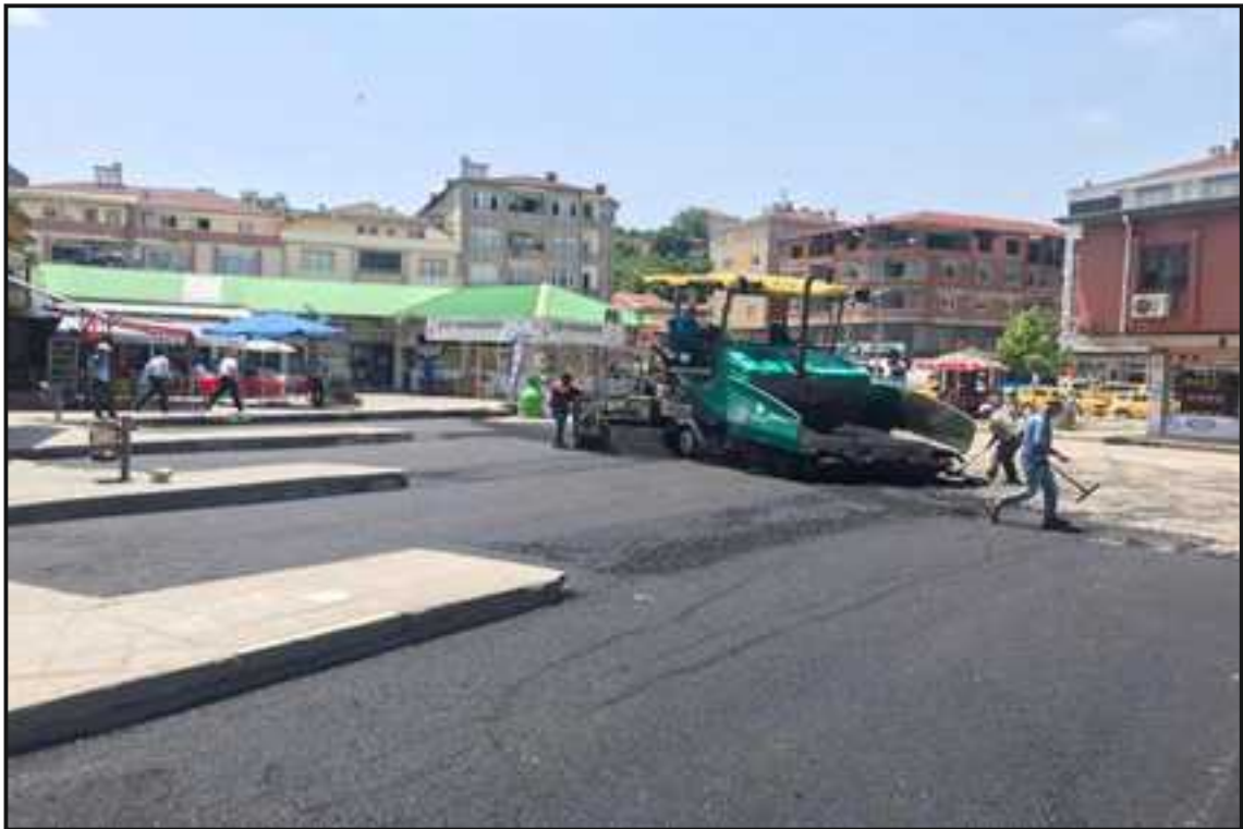
Resim 3 : Karasu İlçe Terminali Sıcak Asfalt Çalışması
