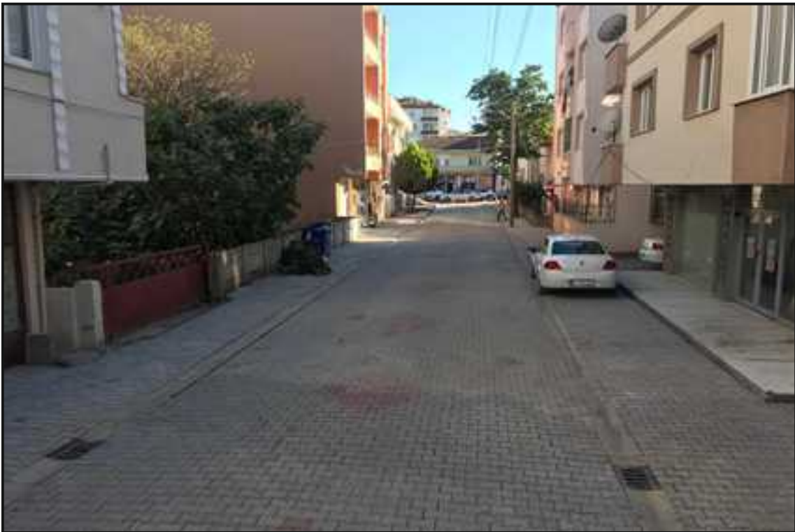
Resim 5 : 615 Nolu Sokak Kilitli Parke Çalışması
