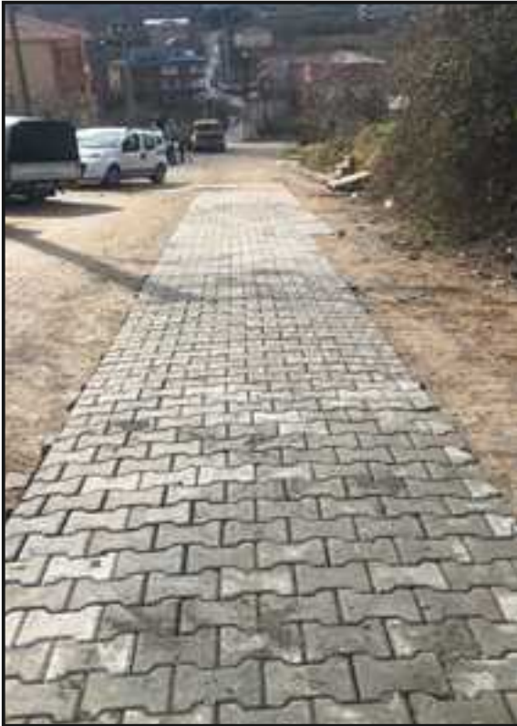
Resim 21: 1006 Nolu Sokak Kilitli Parke Tamirat Çalışması
