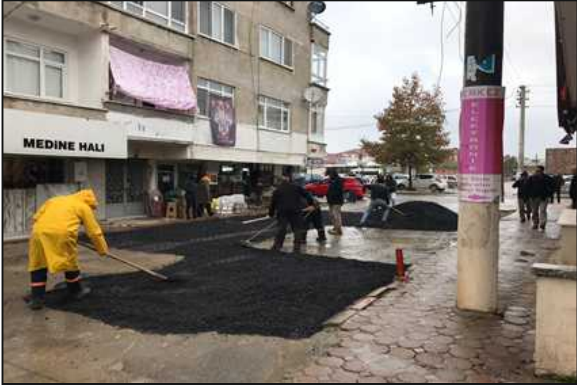
Resim 3 : 617/1 Nolu Sokak Asfalt Yama Çalışması
