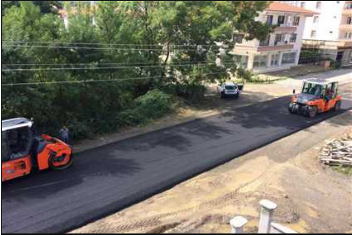
Resim 6 : 600 Nolu Sokak Sıcak Asfalt Çalışması
