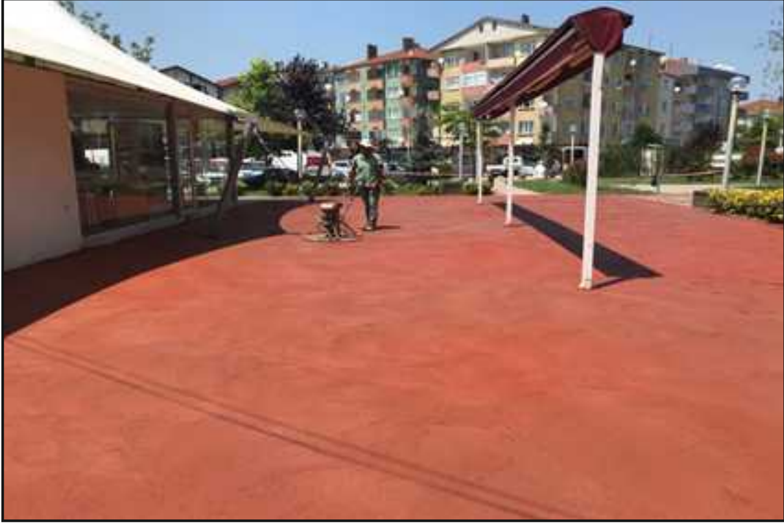
Resim 1 : Kentpark Helikopter Beton
