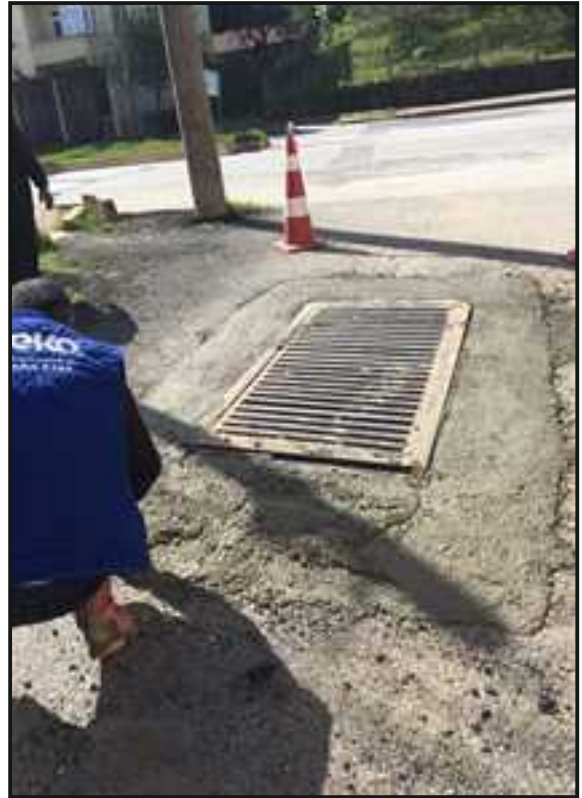
Resim 5 : 808 Nolu Sokak Mazgal Onarımı
