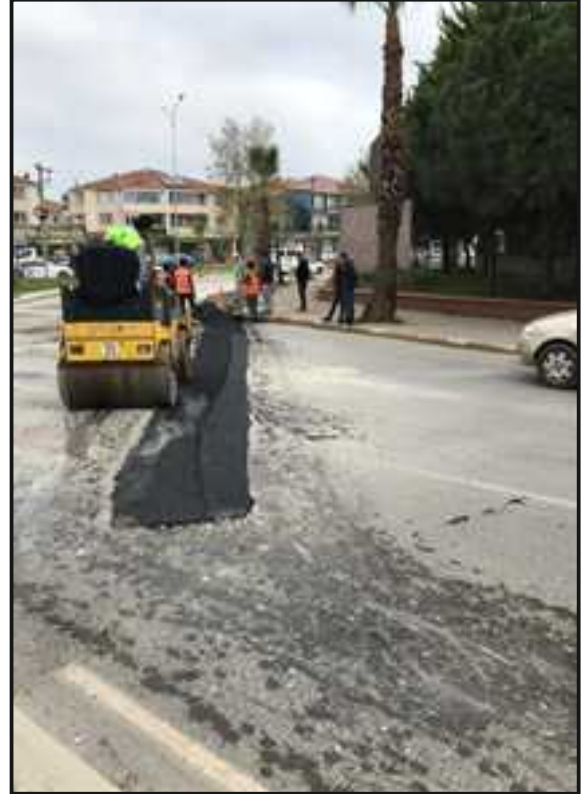
Resim 2 : Plaj Caddesi Asfalt Yama Çalışması
