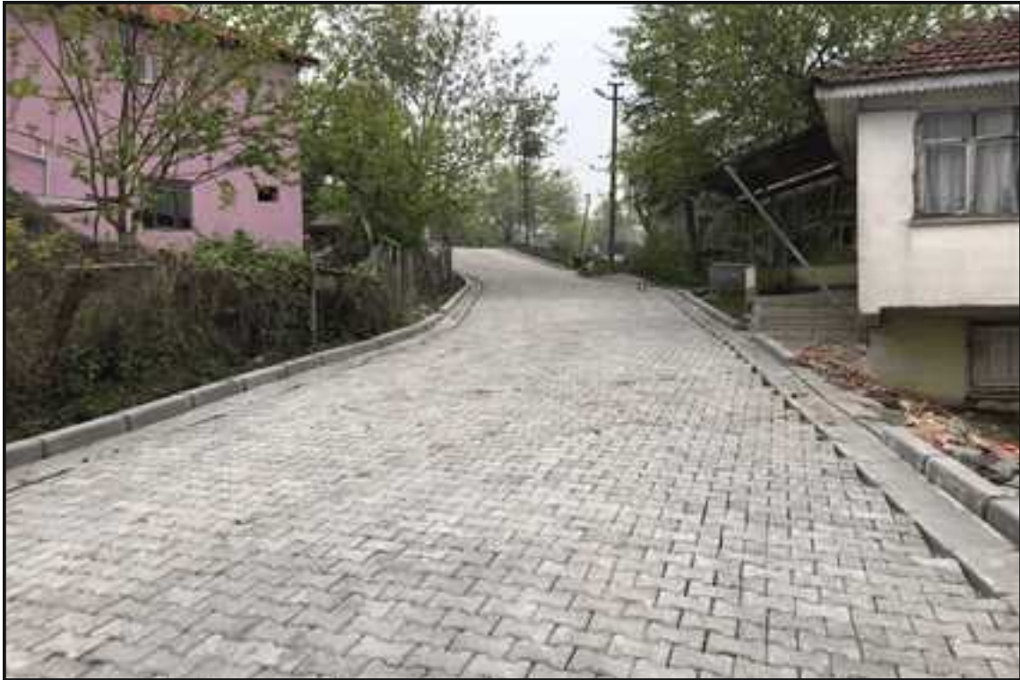
Resim 11 : Yuvalıdere Mahallesi Kilitli Parke Çalışması
