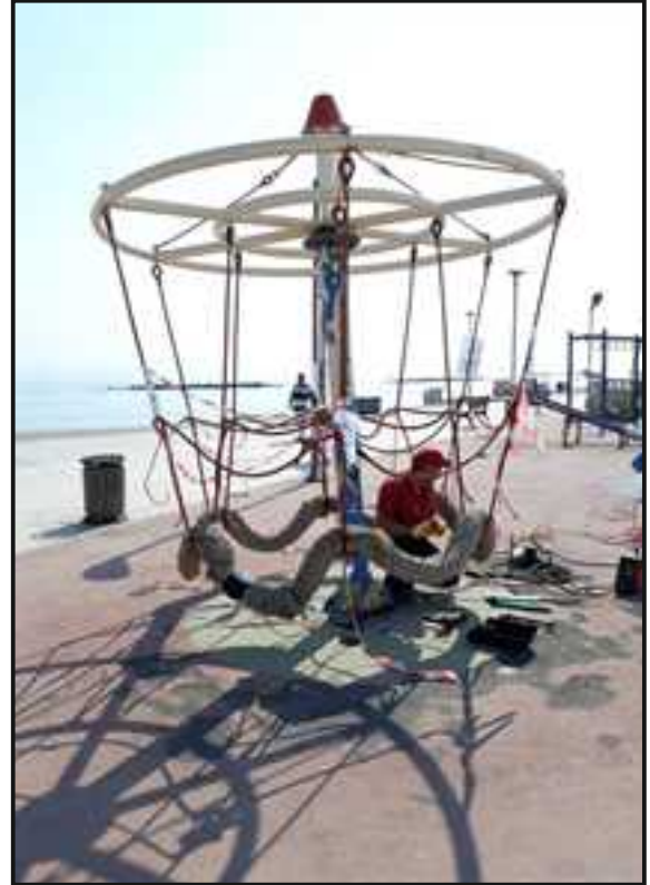
Resim 34 : Sahil Park Yapımı
