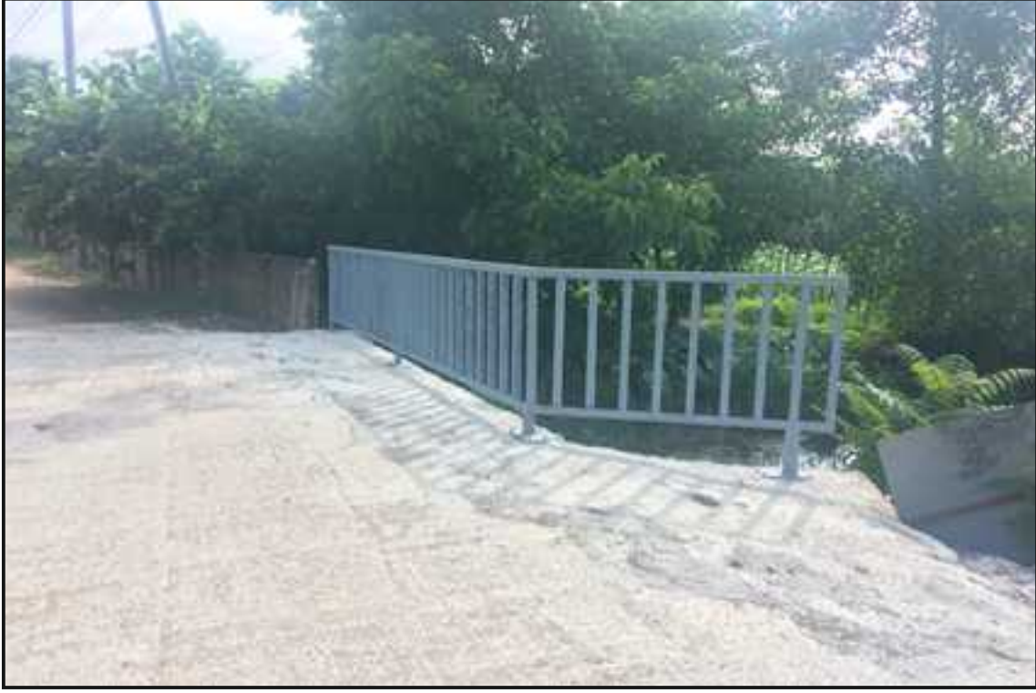
Resim 8 : Küçük Karasu Mahallesi Köprü Korkuluğu Yapımı
