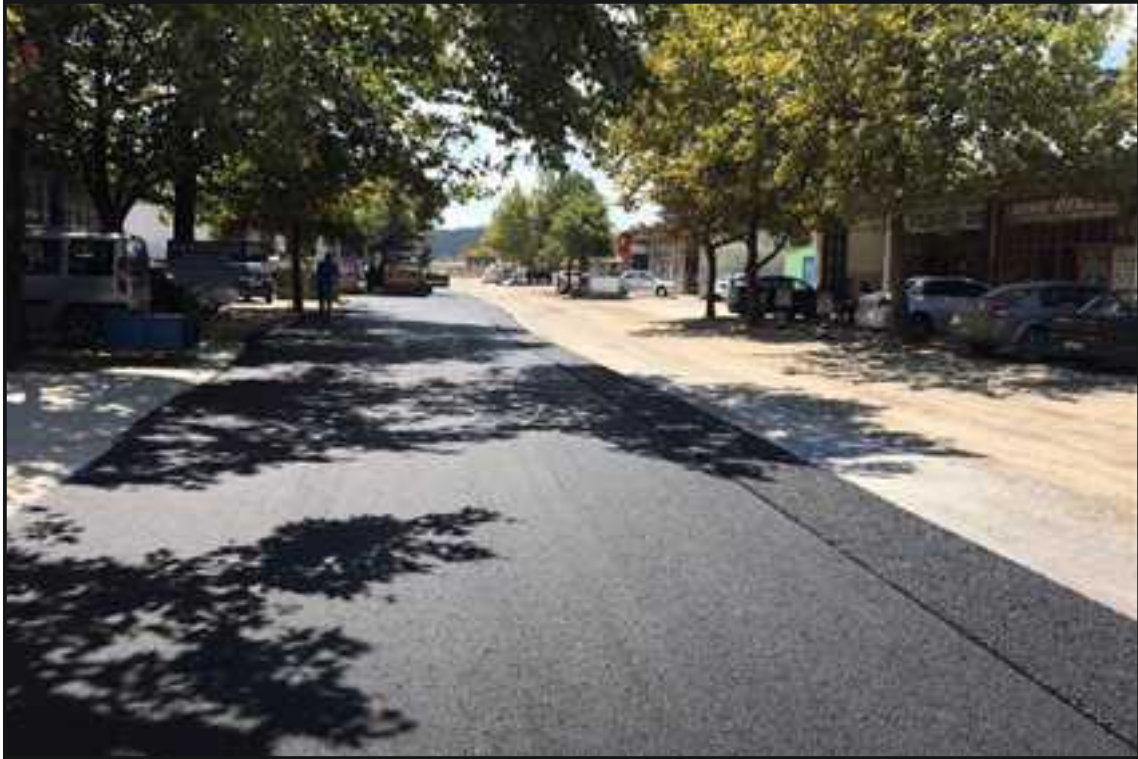
Resim 1 : Sanayi Caddesi Sıcak Asfalt Çalışması
