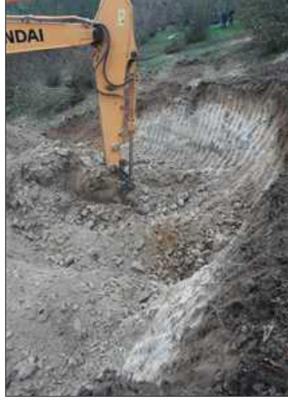
Resim 9: Araştırma Çukuru Çalışması
