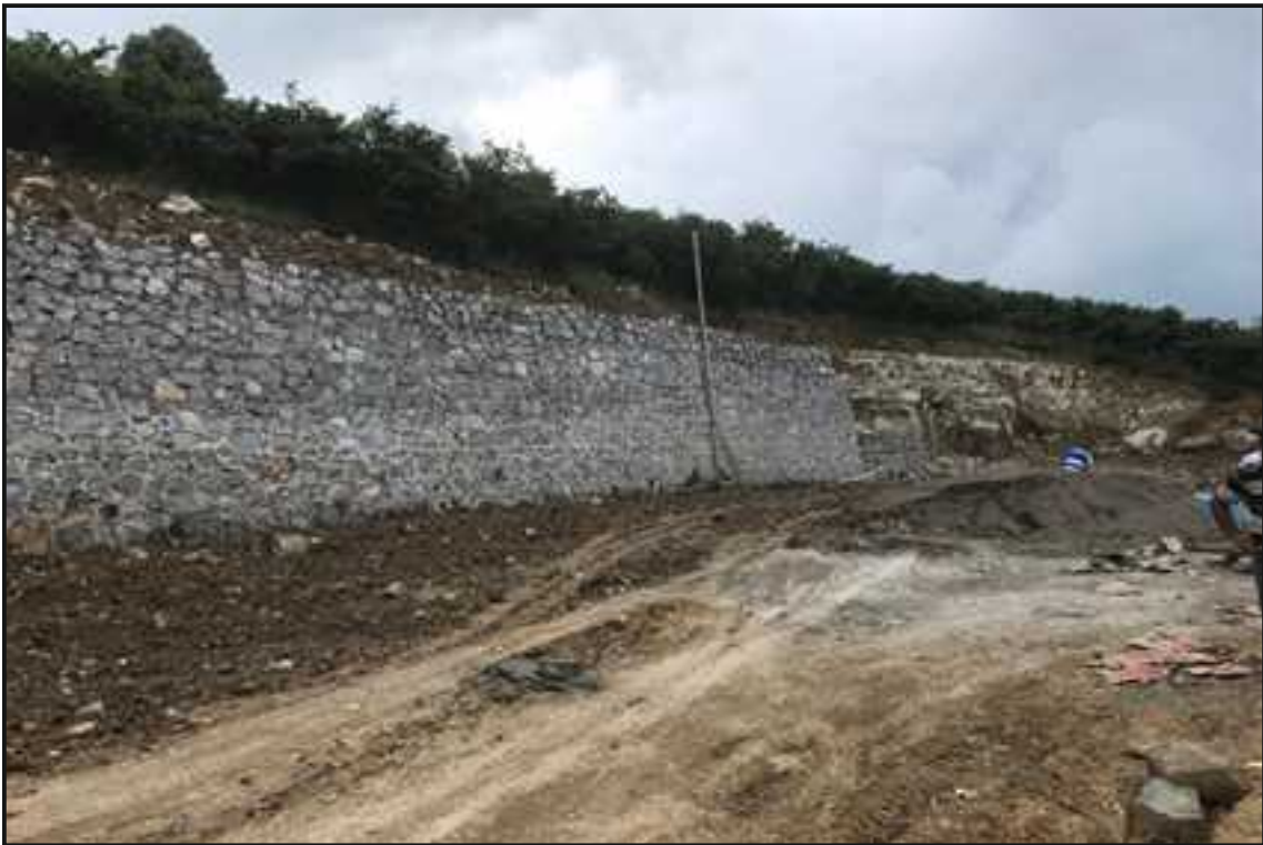
Resim 6 : Kurudere Mahallesi Yol Betonu
