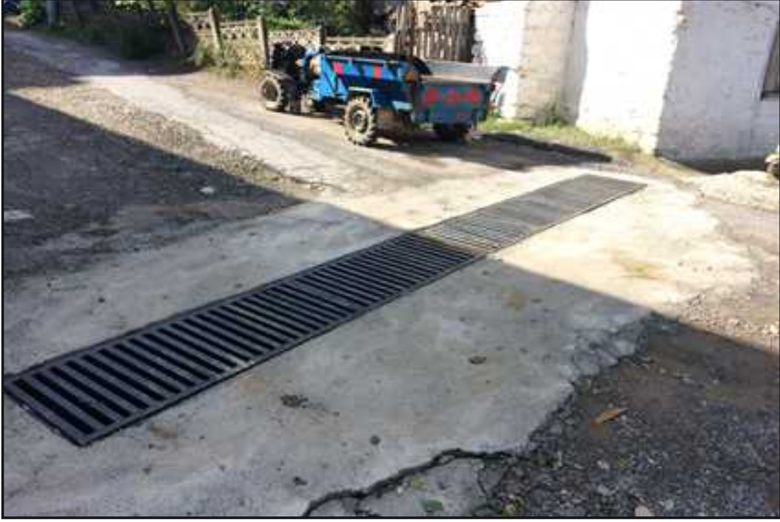
Resim 6 : 608 Nolu Sokak Mazgal Yapımı
