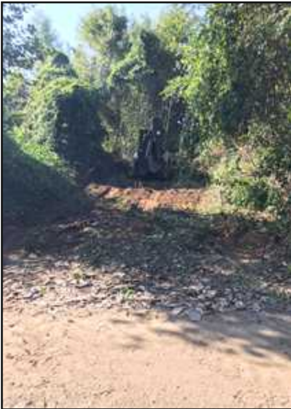
Resim 4 : 328 Nolu Sokak Ham Yol Çalışması
