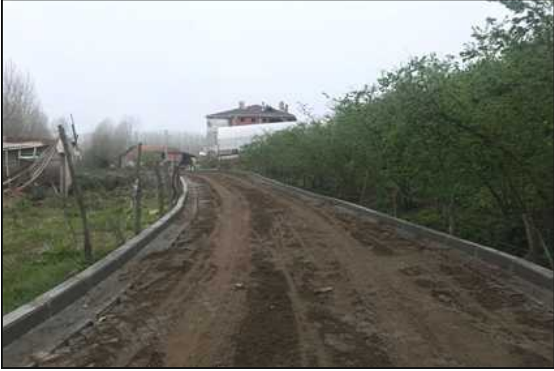
Resim 16 : Hürriyet Mahallesi Kilitli Parke Çalışması
