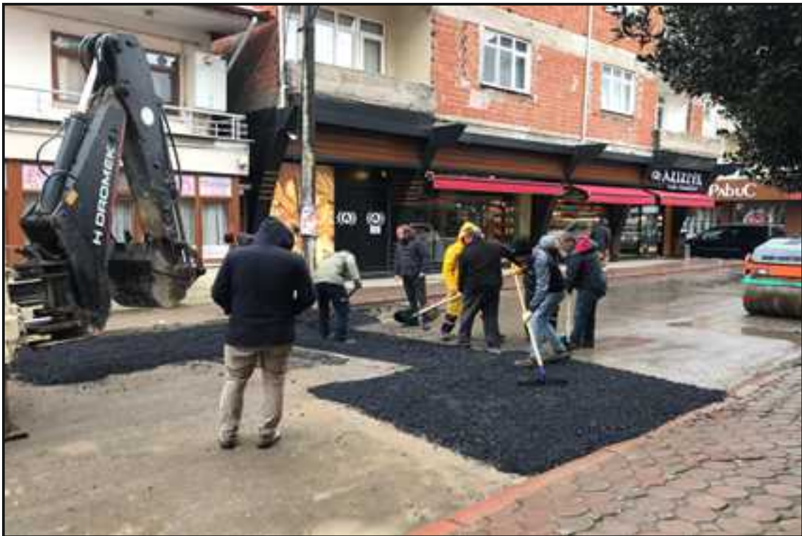
Resim 4 : 617/1 Nolu Sokak Asfalt Yama Çalışması
