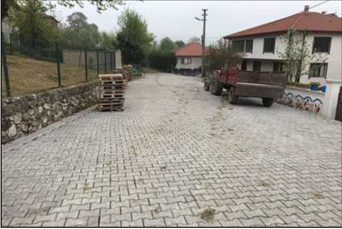
Resim 12: Yuvalıdere Mahallesi Kilitli Parke Çalışması
