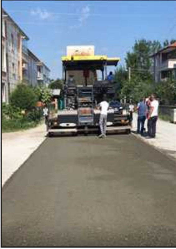
Resim 2 : 809 Nolu Sokak Kuru Yol Beton
