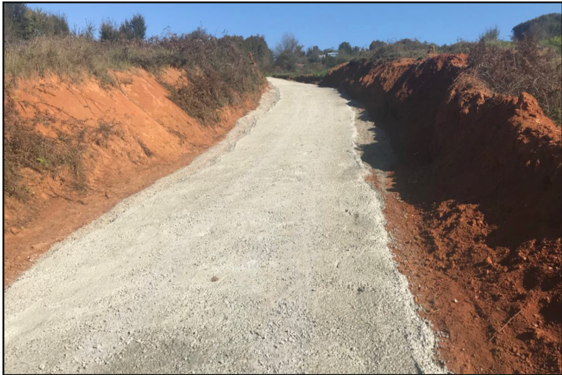
Resim 1 : Kurudere Mahallesi Yol Betonu
