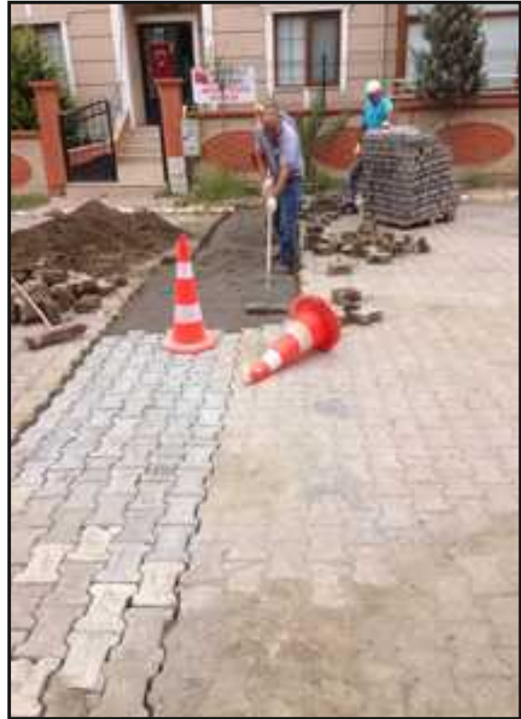
Resim 21: 1006 Nolu Sokak Kilitli Parke Tamirat Çalışması
