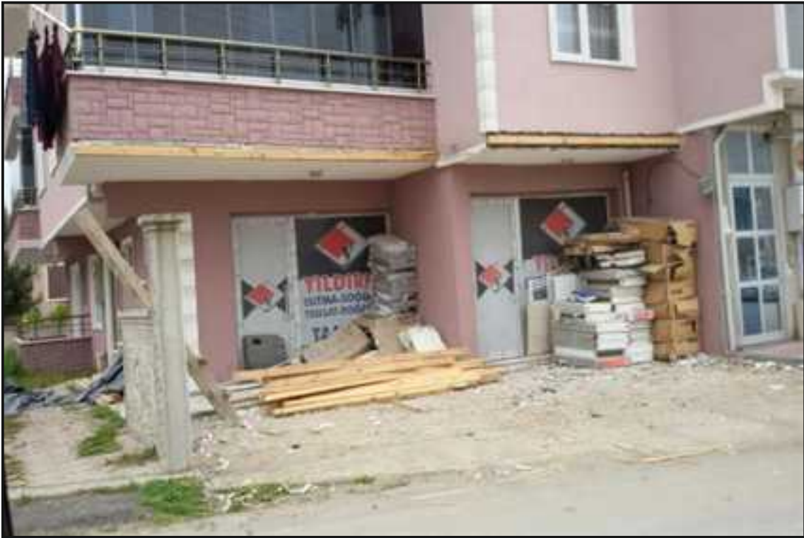
Resim 3 : İmara Aykırı Sundurmanın Yıkımı
