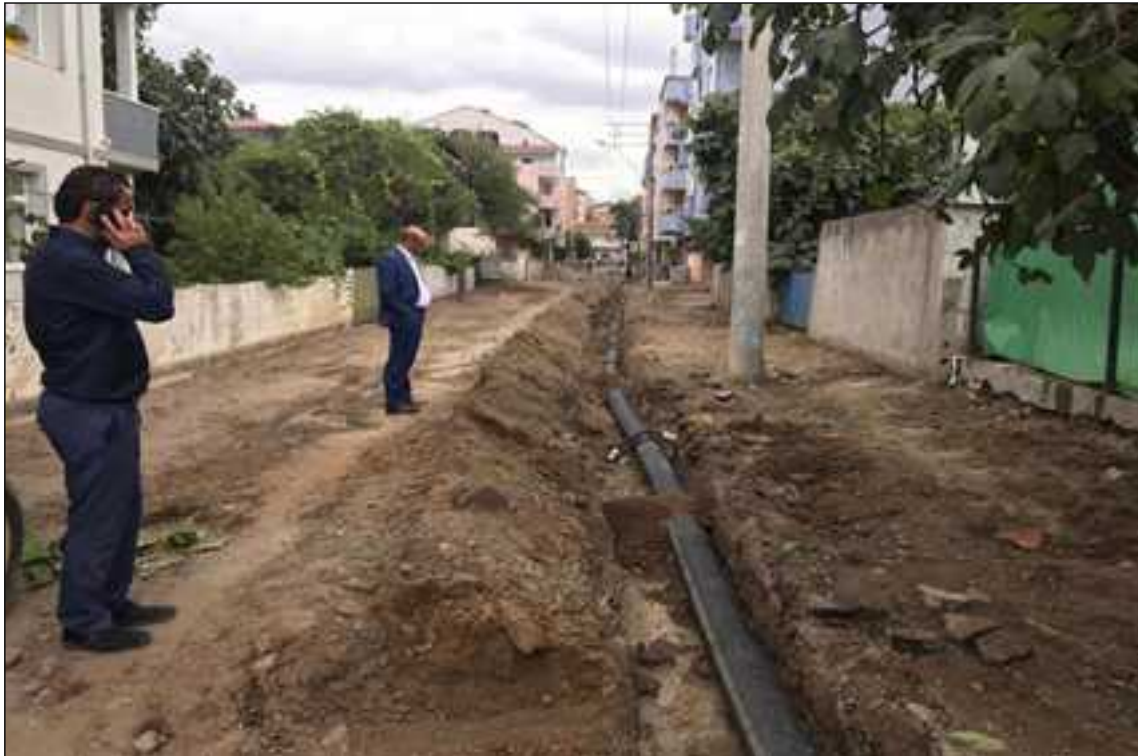
Resim 1 : 616 Nolu Sokak Yağmursuyu Çalışması
