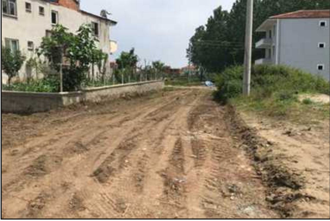
Resim 2 : 378 Nolu Sokak İmar Yolu Aplikasyonu ve Açılması
