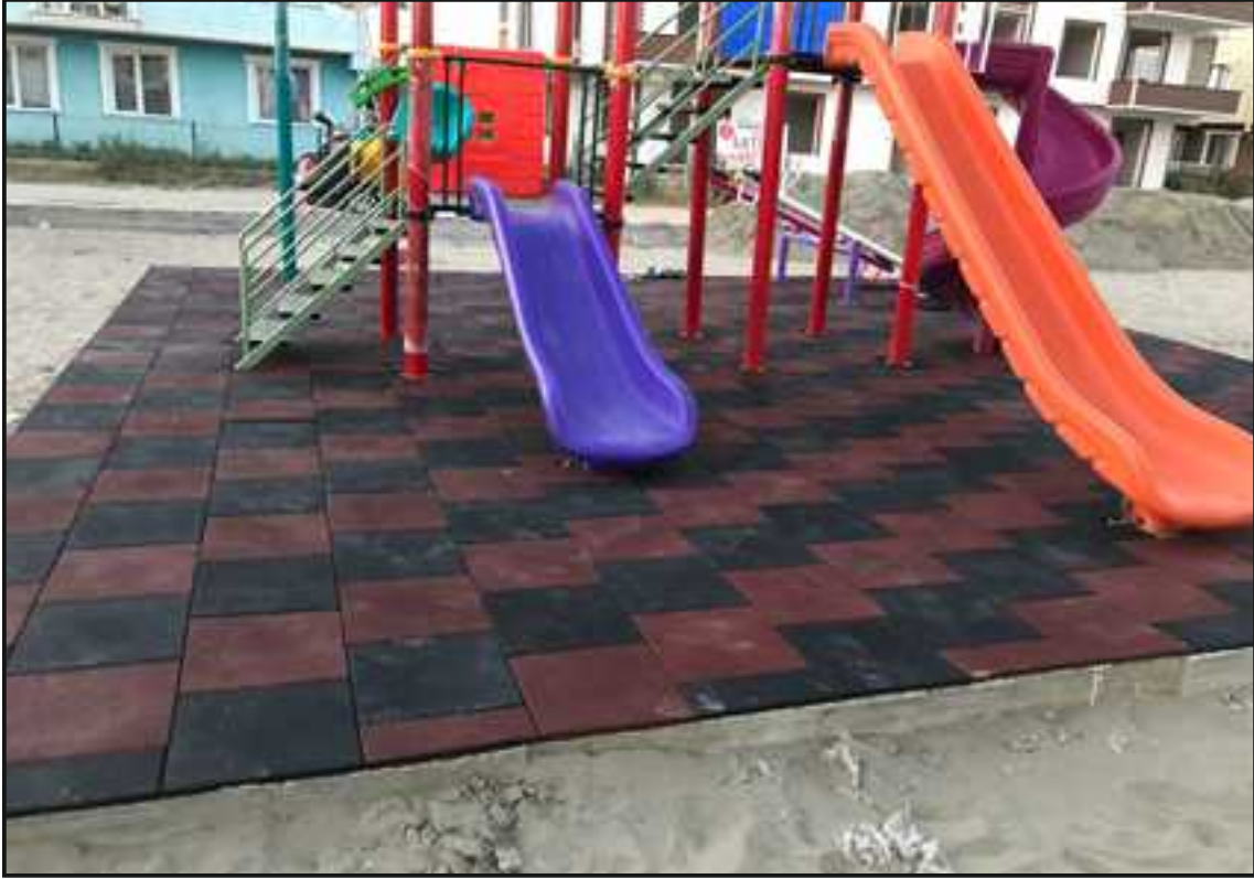
Resim 19: Aşağı Aziziye Mahallesi İstanbul Cad. Zemin Park Onarımı
