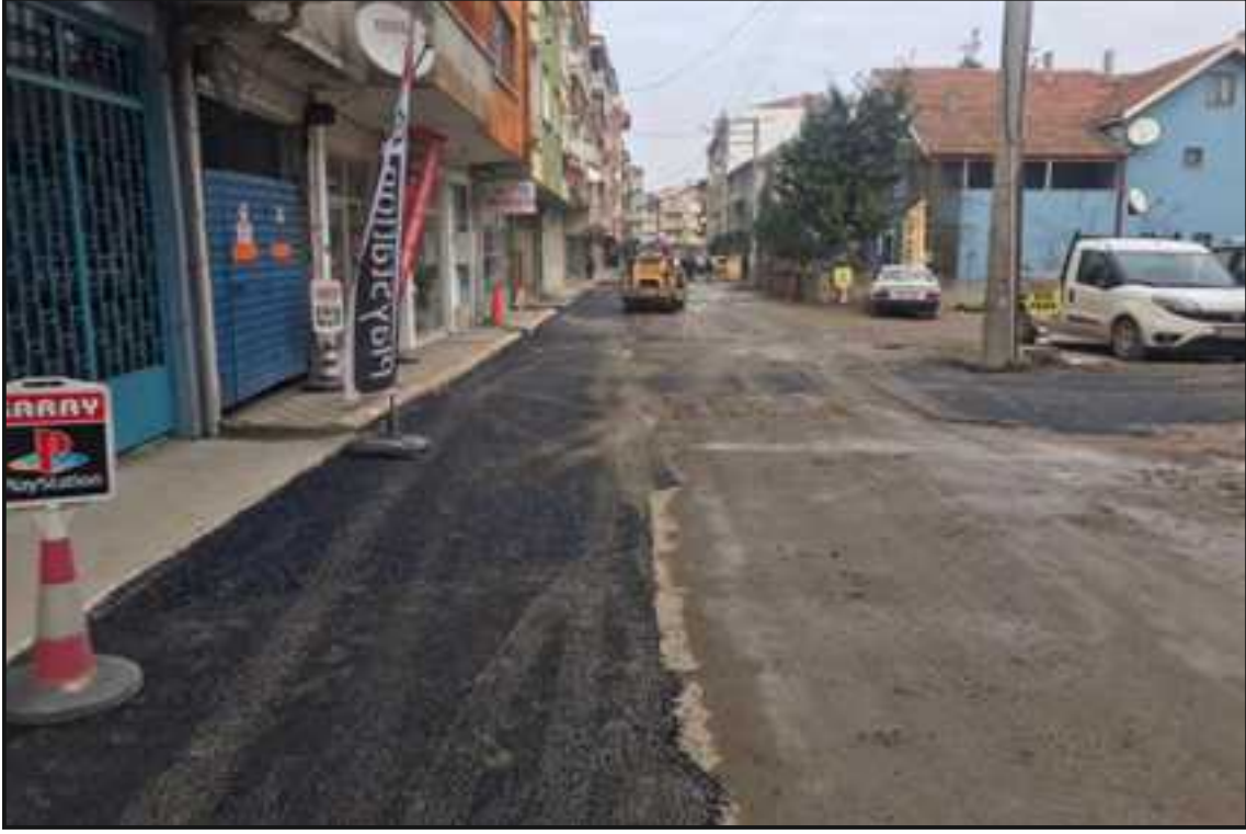
Resim 5: 616 Nolu Sokak Asfalt Yama Çalışması
