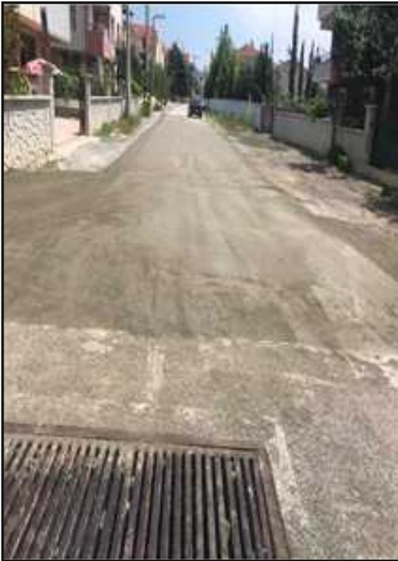
Resim 4 : 809 Nolu Sokak Kuru Yol Beton
