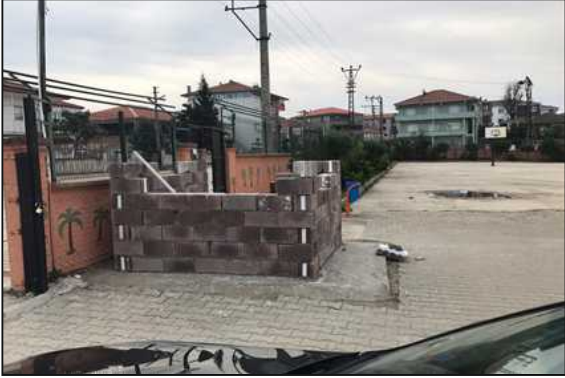
RESİM 3 : Mehmet Akif Ersoy Okulu Bekçi Kulübesi Yapımı
