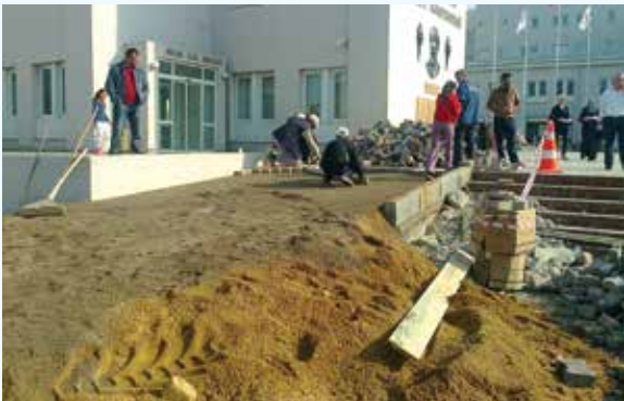
Hastane giriş rampası yapılması
