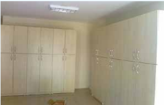
Hizmet binası dolap yapımı
