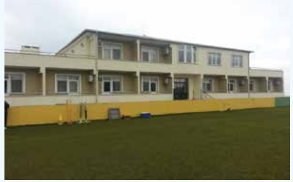
Antrenman Sahası Yapım Çalışması
