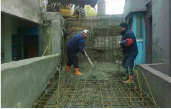
Betonarme merdiven çalışması.
