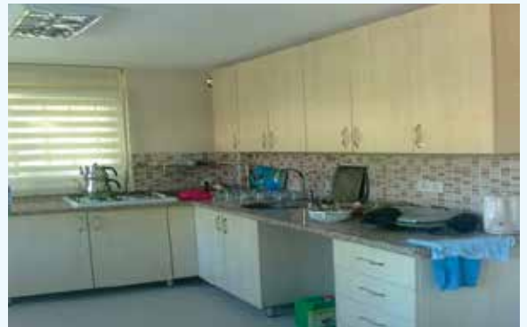
Hizmet Binası mutfak dolabı yapılması
