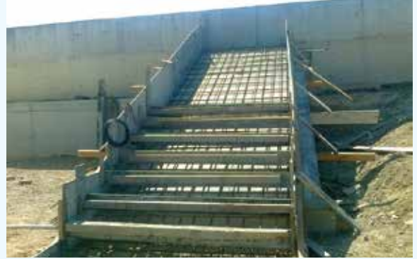
Antrenman Sahası Merdiven yapım çalışması
