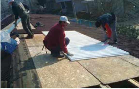
Yeni zabıta binası çatı onarım işi
