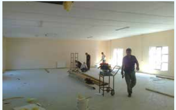
Sağlık Ocağı tamirat bakım çalışması
