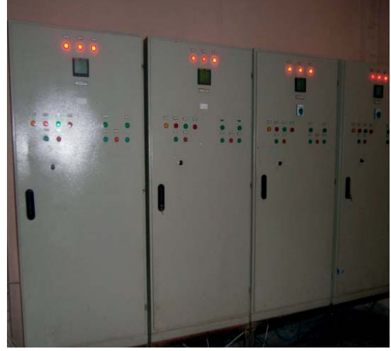
9-DY-17 Terfi İstasyonundaki elektrik panoları yeni kurulacak olan pompalara uygun hale getirilmiştir.
