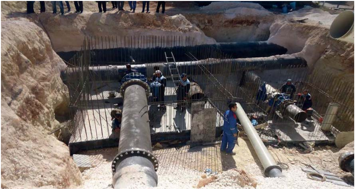
Raylı Sistem Güzergah Deplasmanı / Güvenevler Mah. Hoca Ahmet Yesevi Cad. Vana Bağlantı Çalışmaları
