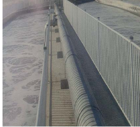
Kızılhisar İleri Biyolojik Atık su Arıtma Tesisindeki Mixer ve havalandırma havuzları
