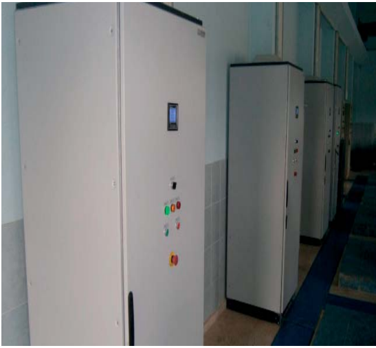
9-DY-17 Terfi İstasyonundaki elektrik panoları yeni kurulacak olan pompalara uygun hale getirilmiştir.
