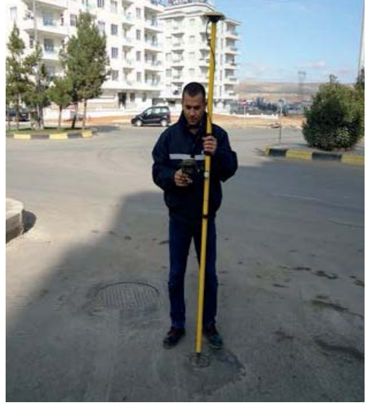
Yeditepe Mah. SCADA Ölçüm Noktası Koordinat Alımı
