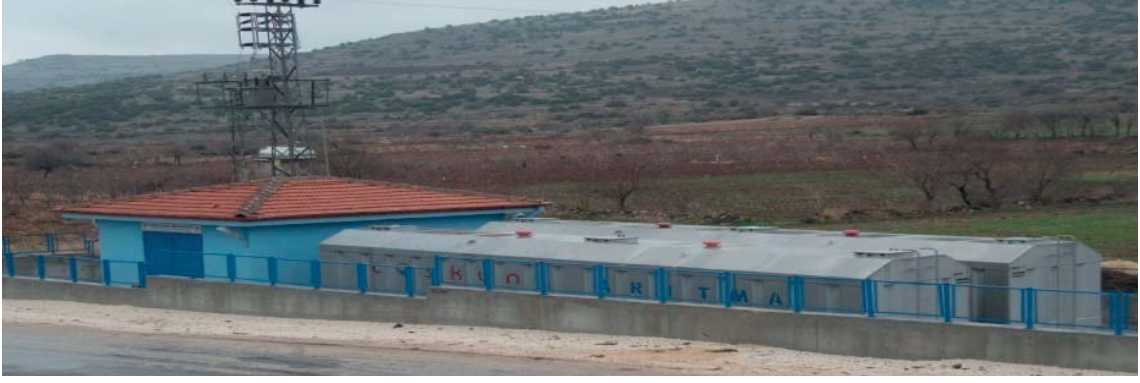
Arıl Paket Atık Su Arıtma
