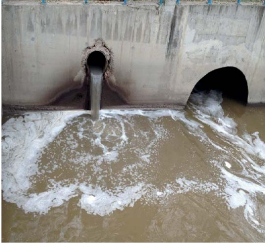
Merkez Atık Su Arıtma Tesisi Giriş Yapısı
