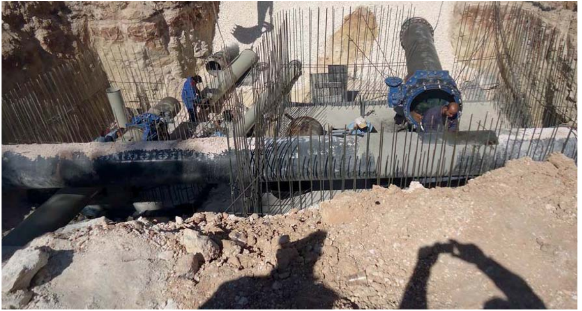
D17 Depo Çıkış Vanaları Bağlantı Çalışmaları
