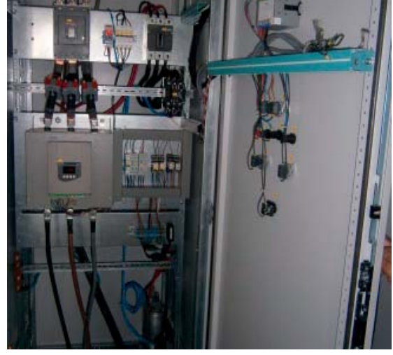
9-DY-17 Terfi İstasyonundaki elektrik panoları yeni kurulacak olan pompalara uygun hale getirilmiştir.
