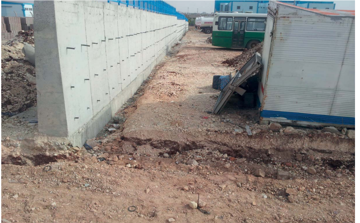
İstinat Duvarı İnşaatından Görüntüler
