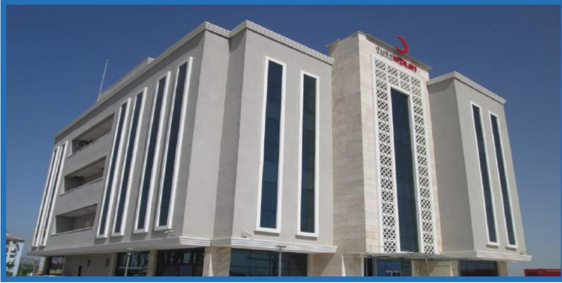
Karahasanlı Mahallesinde Türk Kızılay Hizmet Binası iskân kontrolü
