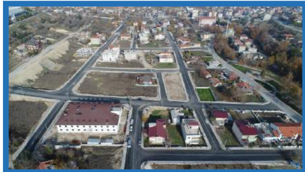
Gümüşçay Mahallesi üstyapı çalışması sonrası
