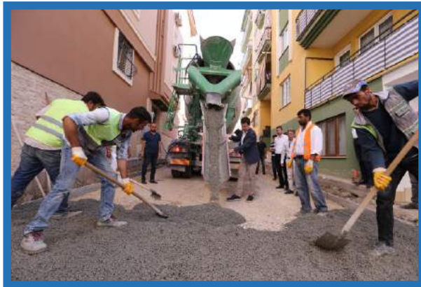
Karaman Mahallesi Kilit Taş Parke Altına Beton Dökülürken
