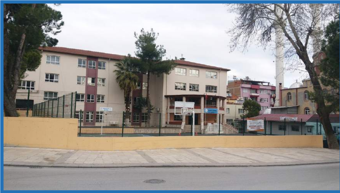
Namık Kemal İlkokuluna 75 m uzunluğunda betonarme bahçe duvarı yapıldı
