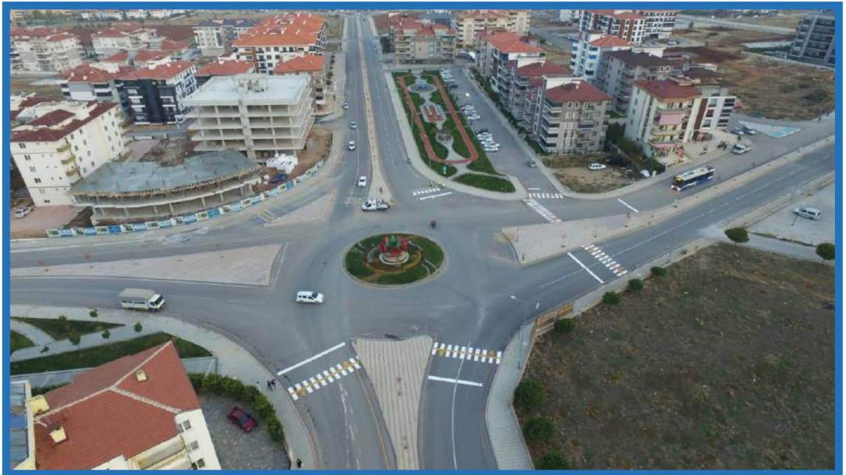
Yenişafak Mahallesi sıcak asfalt yol çalışması
