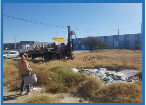
Akçeşme Mahallesi sondaj çalışması
