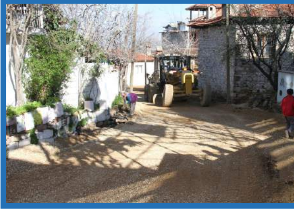
Şirinköy Mahallesi asfalt öncesi plentmiks malzemesi seriliyor
