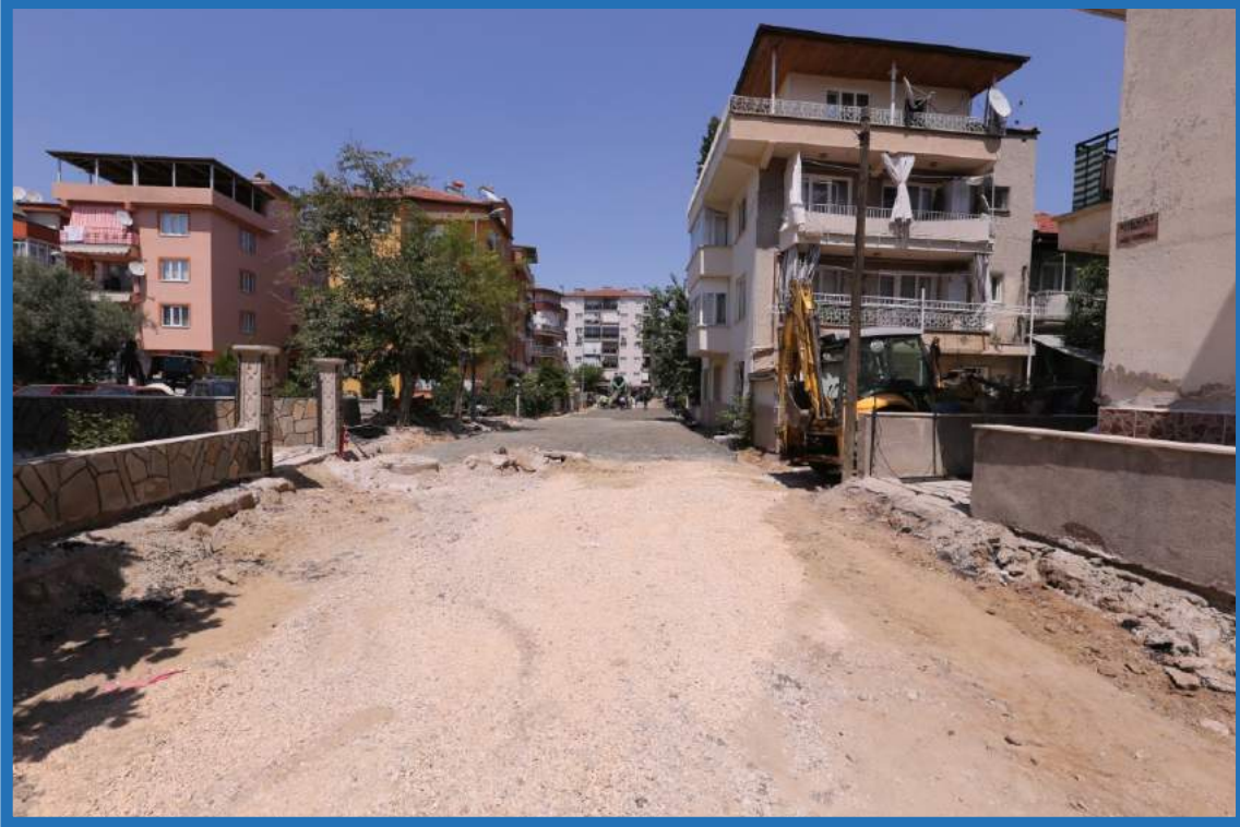
Muratdede Mahallesi yol kazı çalışması
