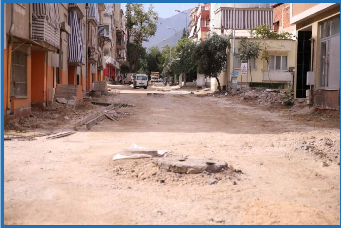
Akkonak Mahallesi yol kazı çalışması
