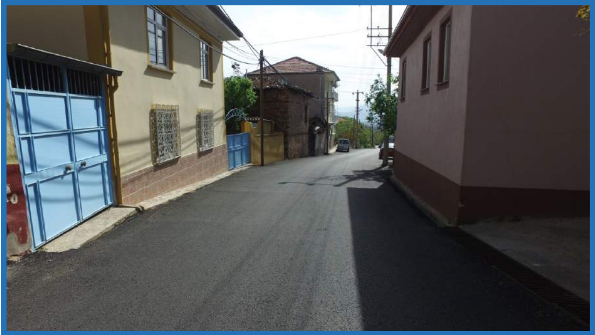
Şirinköy Mahallesi asfalt çalışması
