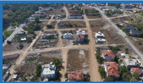
Gümüşçay Mahallesi üstyapı çalışması öncesi
