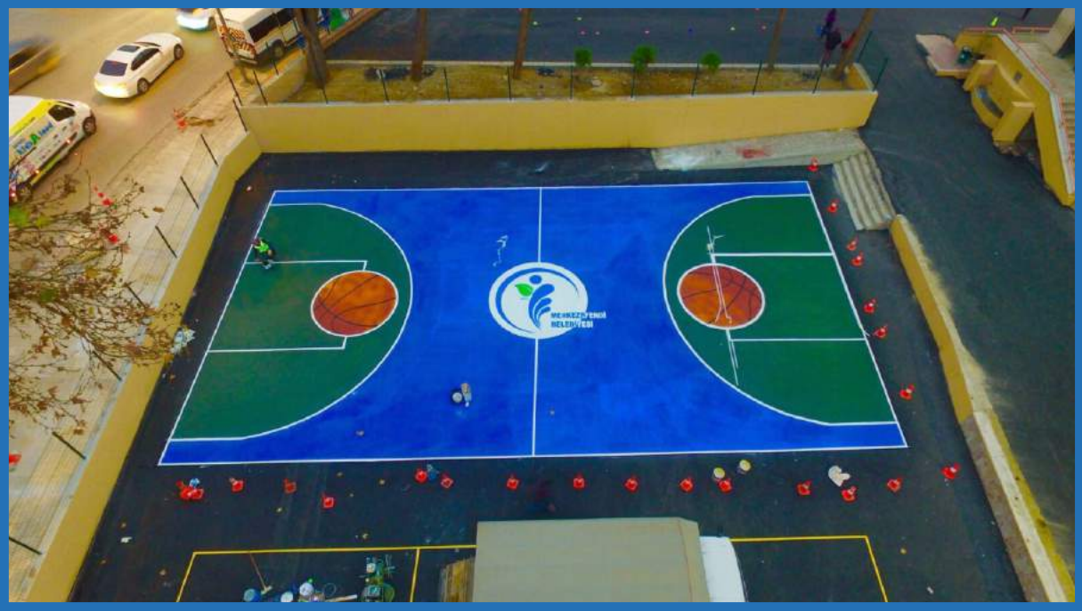
Namık Kemal İlkokul bahçesine yaptığımız asfalt zemin kaplaması üzerine basketbol sahası çizgi ve boyaması yapıldı
