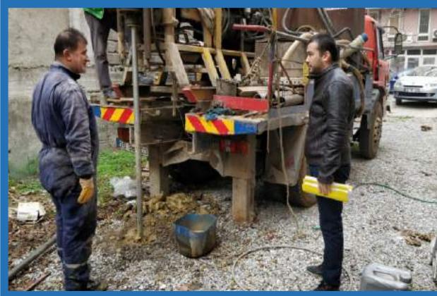
Sırapapılar Mahallesi sondaj çalışması
