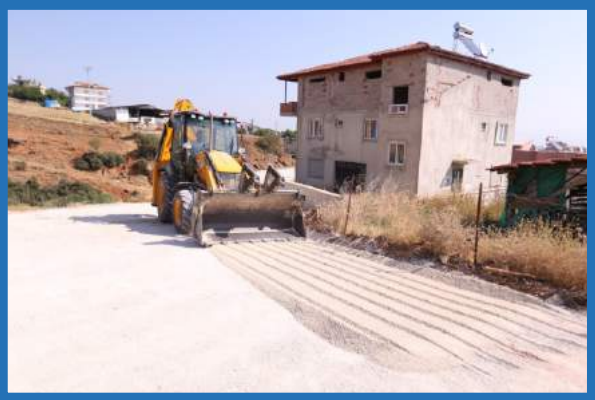
Yeşilyayla Mahallesi kilit taş yol çalışmaları
