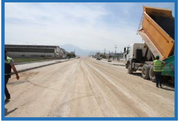
Hacıyüplü Mahallesi yol yapım çalışması
