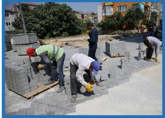
İlbade Mahallesi üstyapı çalışması
