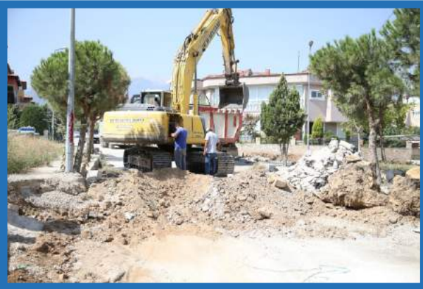
Karaman Mahallesi 1854 Sokak Kazı Çalışması
