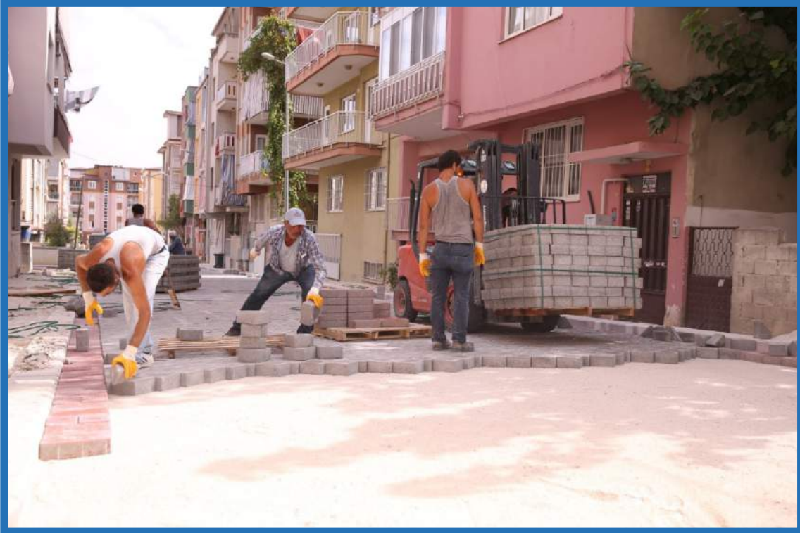
Muratdede Mahallesi üstyapı çalışması
