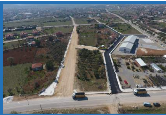
Hacıyüplü Mahallesi yol çalışmaları
