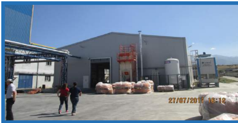
Bozburun Mahallesinde fabrika iskan kontrolü
