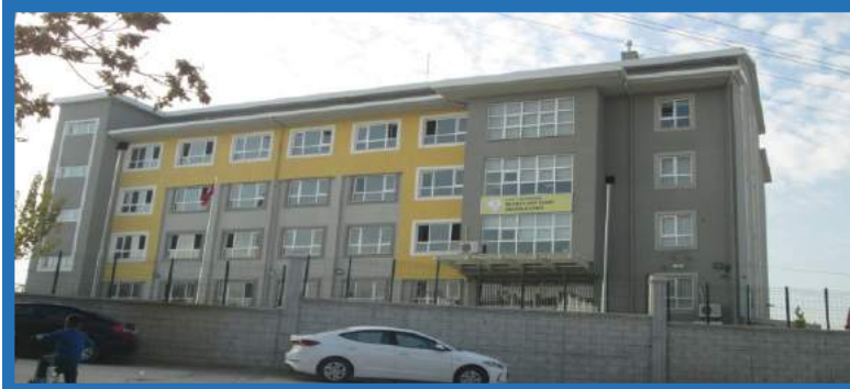
Mehmet Akif Ersoy Anadolu Lisesi iskân kontrolü
