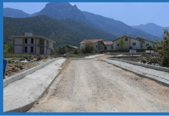
Gerzele Mahallesi yol yapım çalışması
