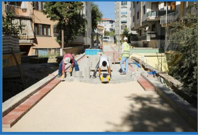
Karaman Mahallesi üstyapı çalışması
