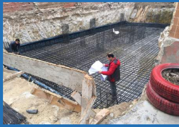
Akkonak Mahallesinde Temel Vizesi Kontrolü
