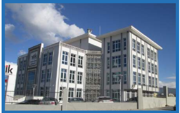
Türkiye İstatistik Kurumu Hizmet Binası iskan kontrolü
