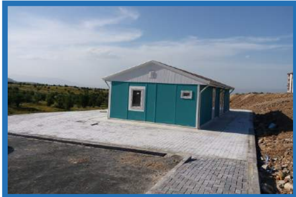
Karahasanlı Açık Pazaryeri Prefabrik Mescit Binası Yapıldı
