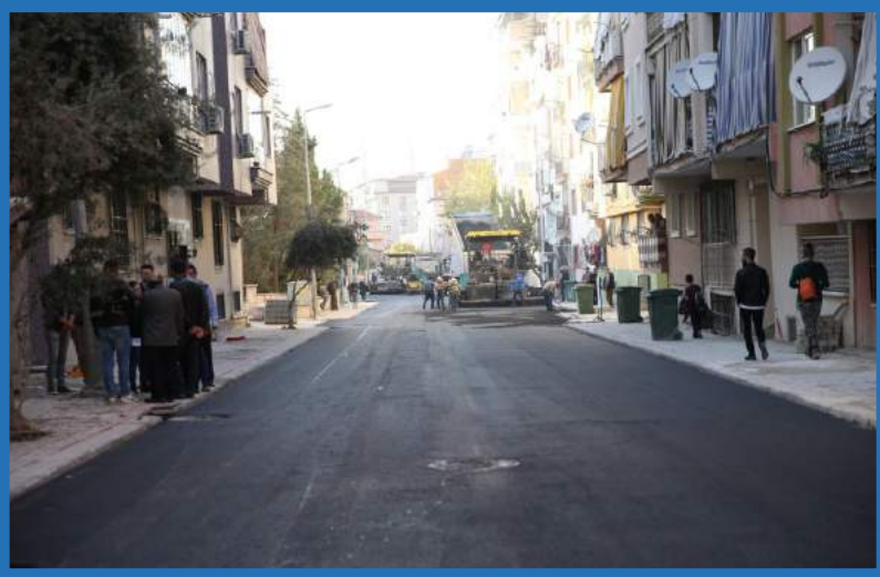
Karaman Mahallesi Asfalt Çalışması
