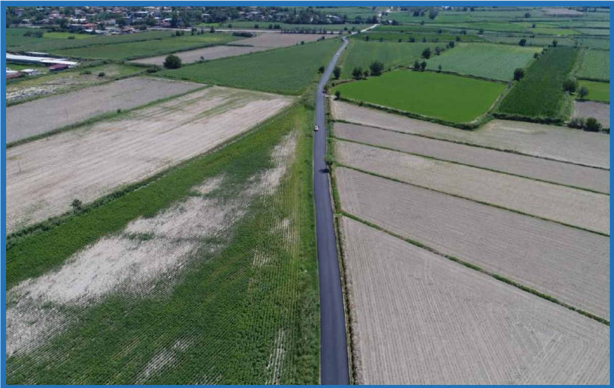
Aşağışamlı Mahallesi sıcak asfalt yol çalışması
