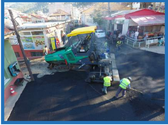
Şirinköy Mahallesi asfalt çalışması
