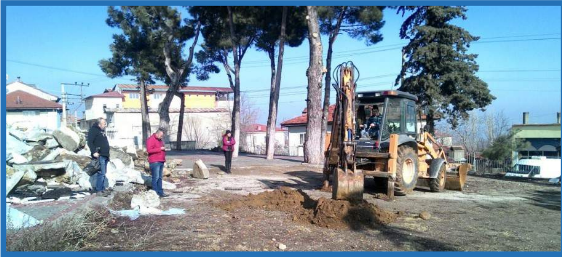
Göveçlik Mahallesi Araştırma Çukuru
