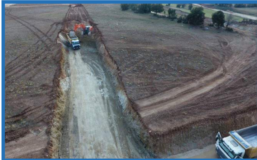
Karahasanlı Mahallesi yol açma
