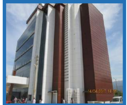
Özel Hastane Binası iskan kontrolü
