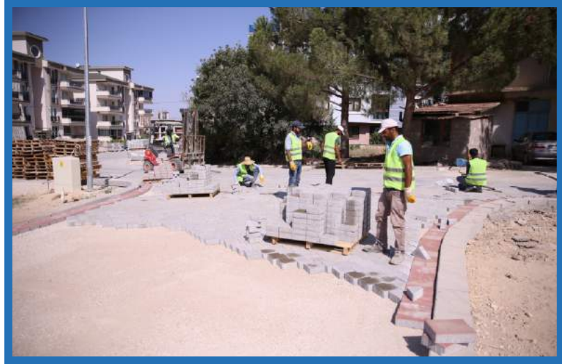
Karaman Mahallesi üstyapı çalışması
