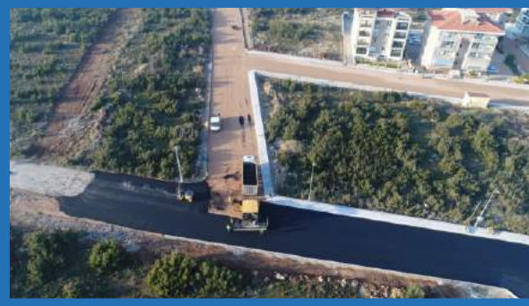
1200 Evler Mahallesi asfalt yol yapım çalışması
