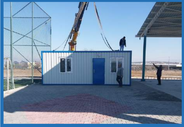
Hacıyüplü pazaryeri ile halı saha arasında çok amaçlı prefabrik bina yerleştirilmiştir.
