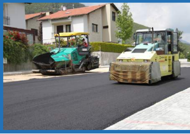
Servergazi Mahallesi asfalt yol yapım çalışması
