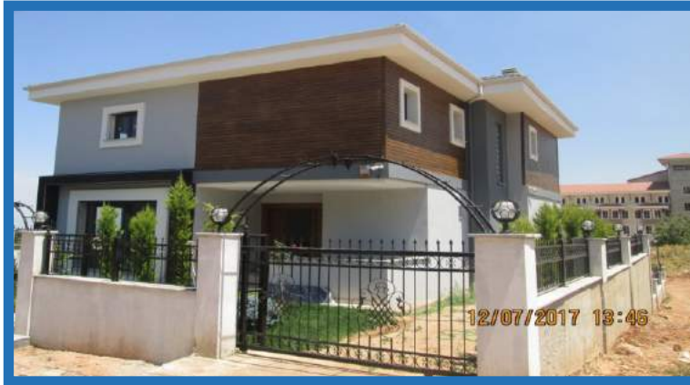
Şirinköy Mahallesinde konut iskan kontrolü
