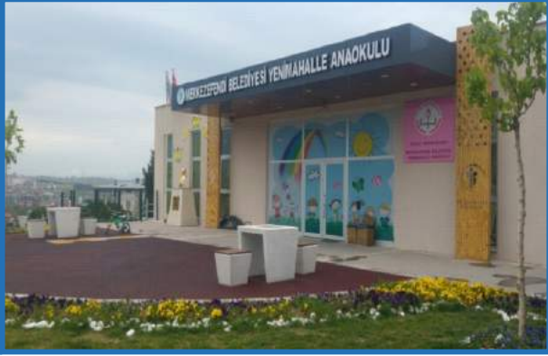
Yeni Mahalle Şehit Rıza Can Cad. Anaokulu
