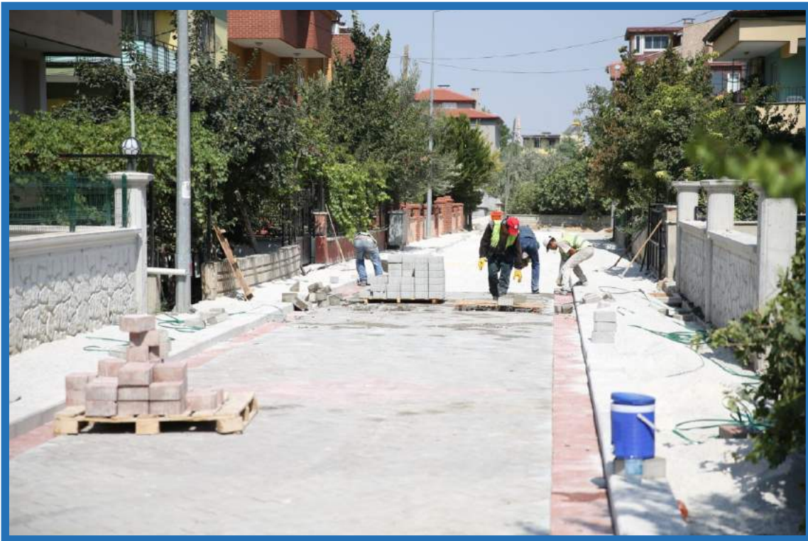
Akkonak Mahallesi üstyapı çalışması
