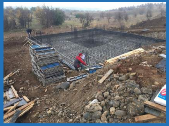
Yenişafak Mahallesinde Temel Vizesi Kontrolü
