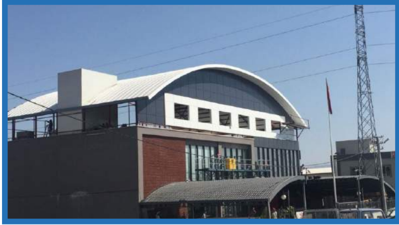
İşyerine Kaçak İlave Yapı
