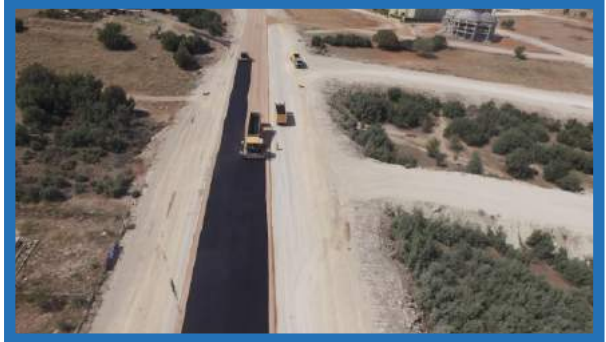
Karahasanlı Mahallesi asfalt yol yapım çalışması
