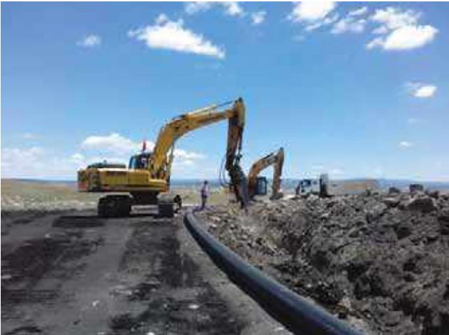
Şekil 258. İçme suyu Servisi Çalışmaları
