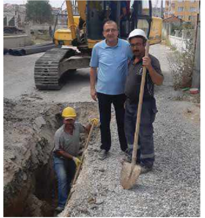
Şekil 270. Dumlupınar Mahallesi Yağmur Suyu Hat Çalışması
