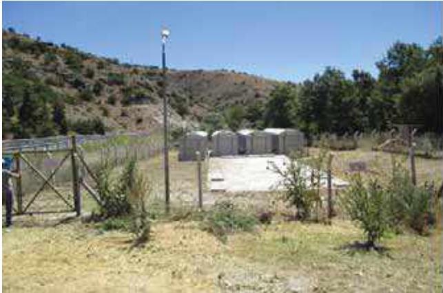
Şekil 266. Ilıca Paket Arıtma
