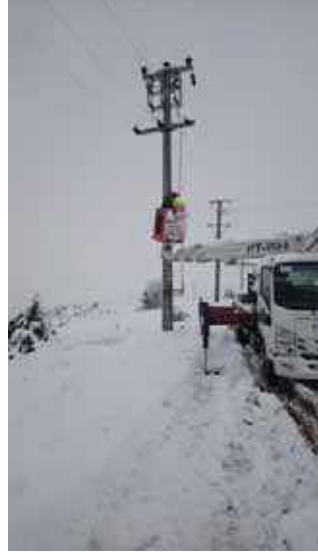
Şekil 269. Uydukent Bölgesi Elektrik Arızası Çalışması
