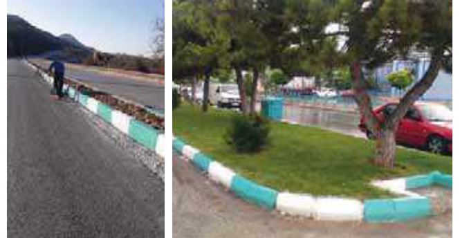
Şekil 217. Bordür Boyama Çalışmaları
