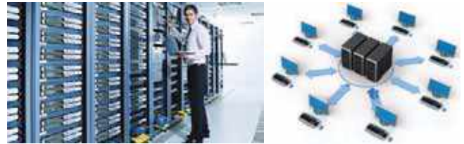
Şekil 37. Sunucu Odası Örneği
