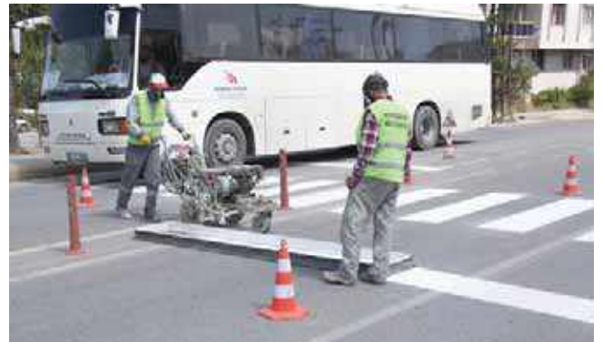
Şekil 67. Yaya Geçidi ve Kasis Boyama Çalışmaları
