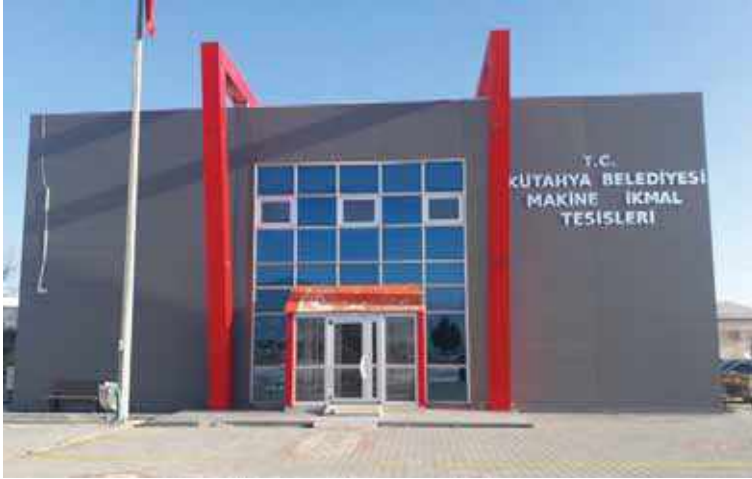
Şekil 243. Makina İkmal Binası
