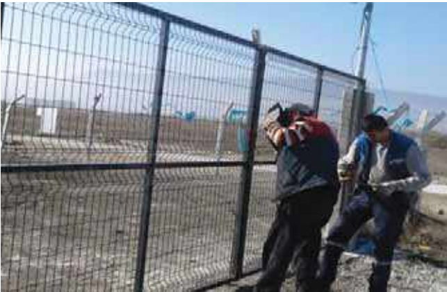
Şekil 245. Kaynak Atölyesi Çalışmaları
