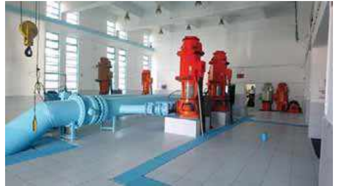
Şekil 267. Porsuk İçme suyu Tesis Binası
