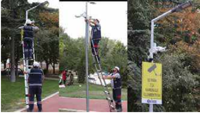
Şekil 214. Ressam Ahmet YAKUPOĞLU Parkı güvenlik kamerası montajı
