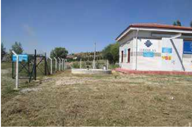
Şekil 265. Yoncalı Atık su Terfi Pompa İstasyonu
