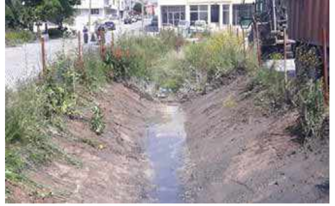
Şekil 261. Kanal Temizleme Çalışmaları
