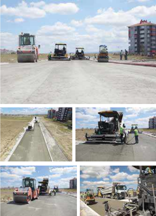
Şekil 73. Beton Yol Faaliyetleri
