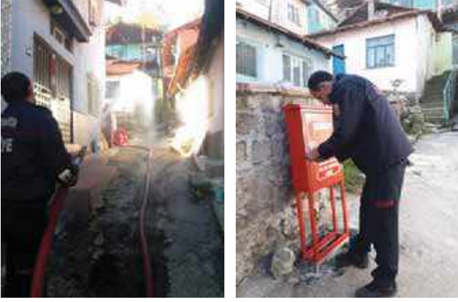
Şekil 181. Yangın Hidrantı Kontrolleri Ve Yeni Hidrant Montajları
