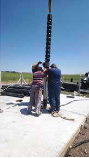
Şekil 268. Parmakören Mahallesi İçme suyu Kuyusu Pompa Çalışması
