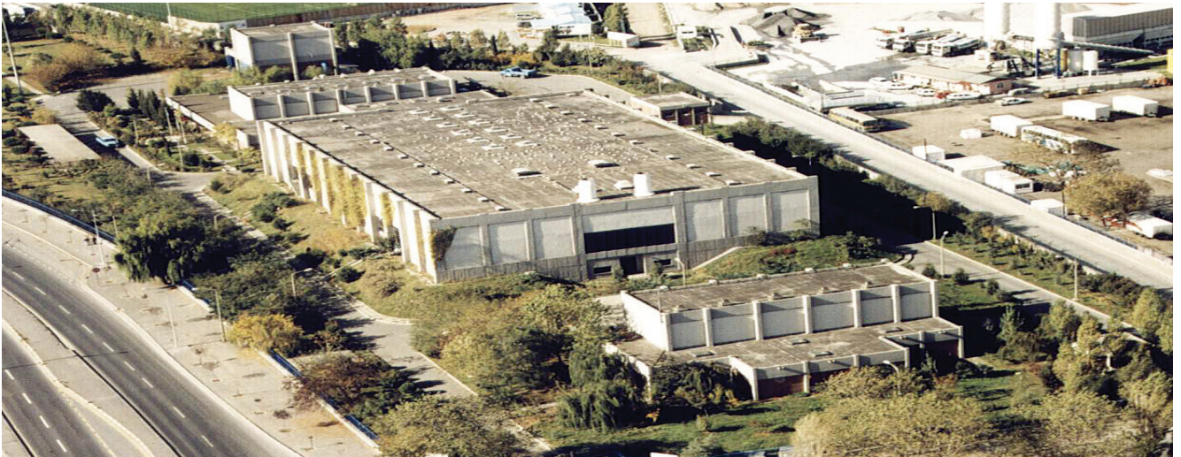
Yenikapı Atıksu Ön Arıtma Tesisi
