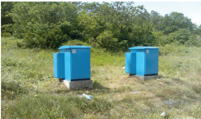
Atıksı Çelik Boru Deniz Deşarj Hatlarına Uygulanan Katodik Koruma
