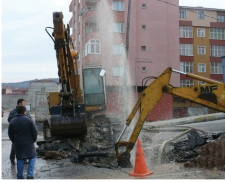
Ferhatpaşa Su Haznesi cazibe hattında şebeke branşman bağlantısındaki arıza onarımı.
