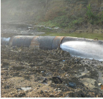
Terkos - Kâğıthane Ø 2200 mm Çelik Boruda Meydana Gelen Heyelan Deformasyonları ve Arıza Tamiri
