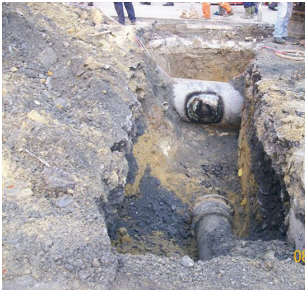
İkitelli Ön Gerilmeli Beton İçinde Ø400 mm HDP Boru Kırığı Tamiri
