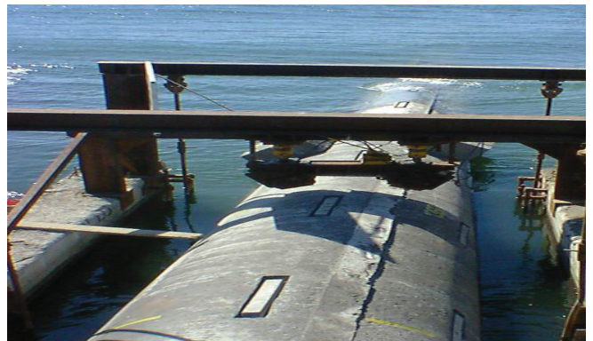
Kadıköy Deniz Deşarjına borunun iç yüzeyinin Mg Anot ile Galvanik usulle korunması.
