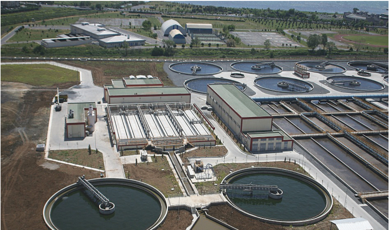
Paşaköy İleri Biyolojik Atıksu Arıtma Tesisi
