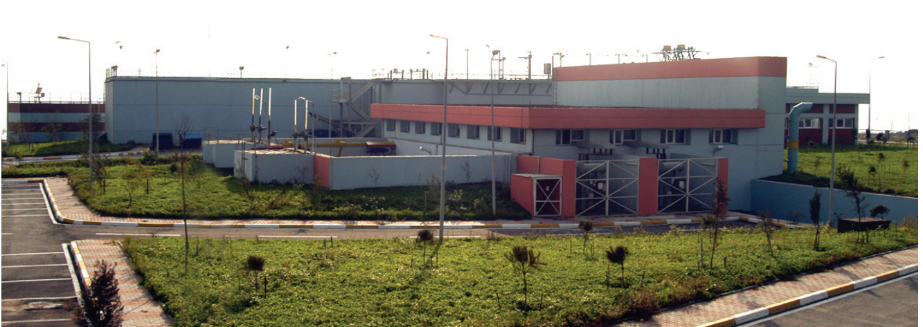
Küçükçekmece Atıksu Ön Arıtma Tesisi
