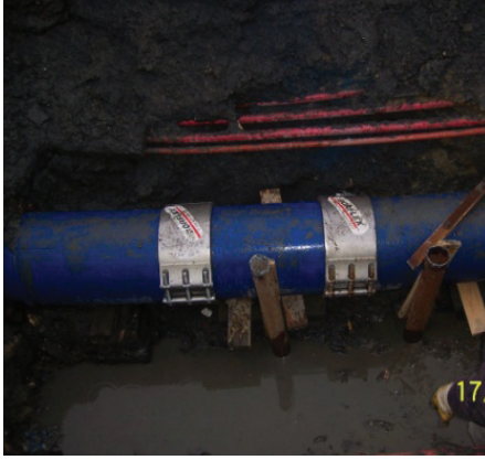
İkitelli Ön Gerilmeli Beton İçinde Ø400 mm HDP Boru Kırığı Tamiri
