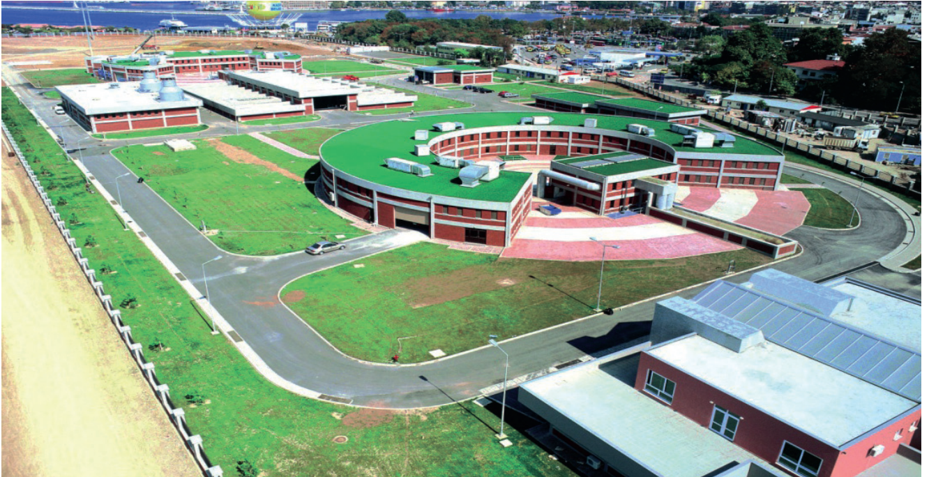
Kadıköy Atıksu Ön Arıtma Tesisi
