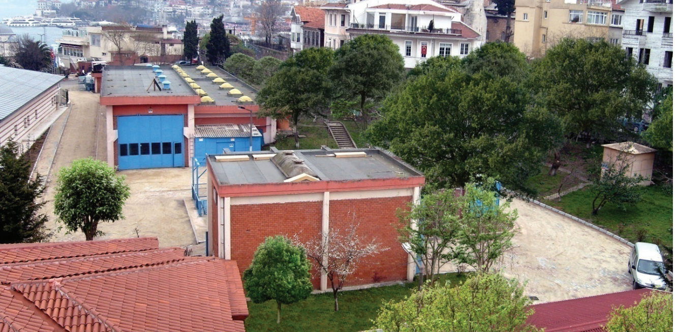
Üsküdar Atıksu Ön Arıtma Tesisi
