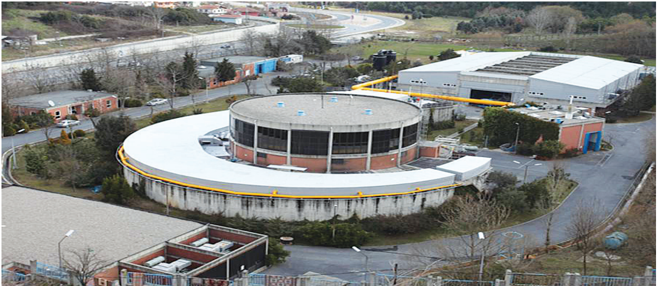
Baltalimanı Atıksu Ön Arıtma Tesis
