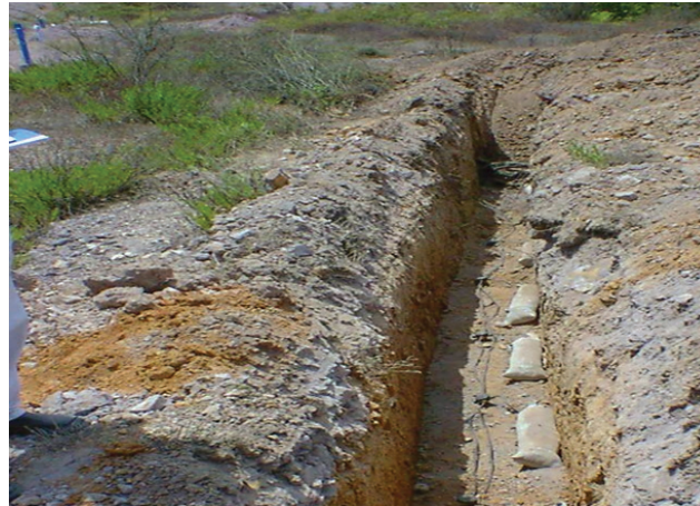
Galvanik Usulle Katodik Koruması yapılan isale hatta Mg Anotların döşenmesi.
