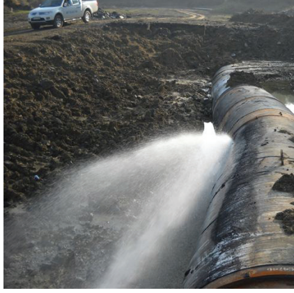
Terkos - Kâğıthane Ø 2200 mm Çelik Boruda Meydana Gelen Heyelan Deformasyonları ve Arıza Tamiri
