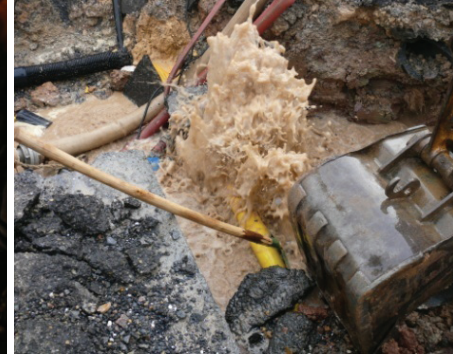
Ferhatpaşa Su Haznesi cazibe hattında şebeke branşman bağlantısındaki arıza onarımı.
