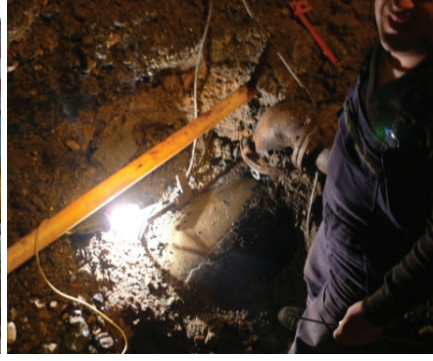
Ferhatpaşa Su Haznesi cazibe hattında şebeke branşman bağlantısındaki arıza onarımı.
