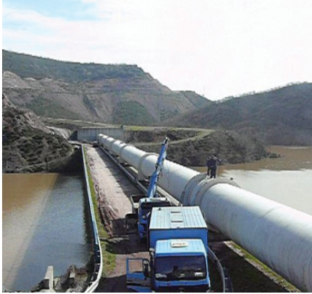
Pendik – Kartal Ø 1200 mm ÇB hatta tahliye bağlantı borusunda meydana gelen arızanın onarımı yapıldı.
