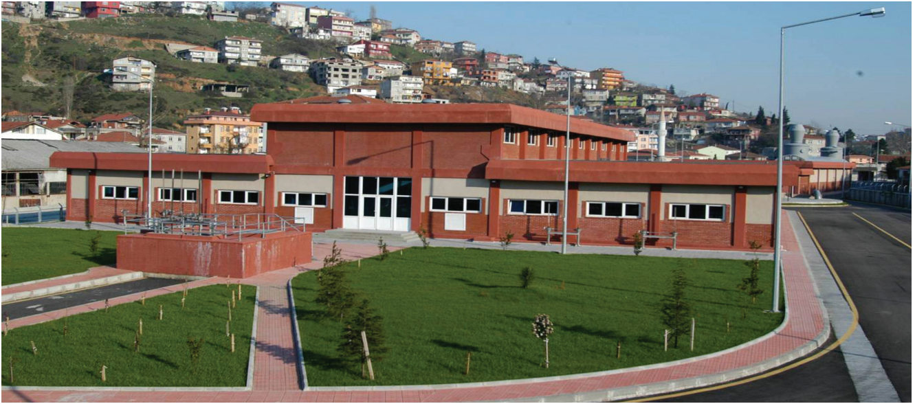
Küçüksu Atıksu Ön Arıtma Tesisi
