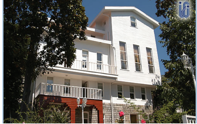
Boyacıköy Eğitim ve Sosyal Tesislerinden Görünüm
