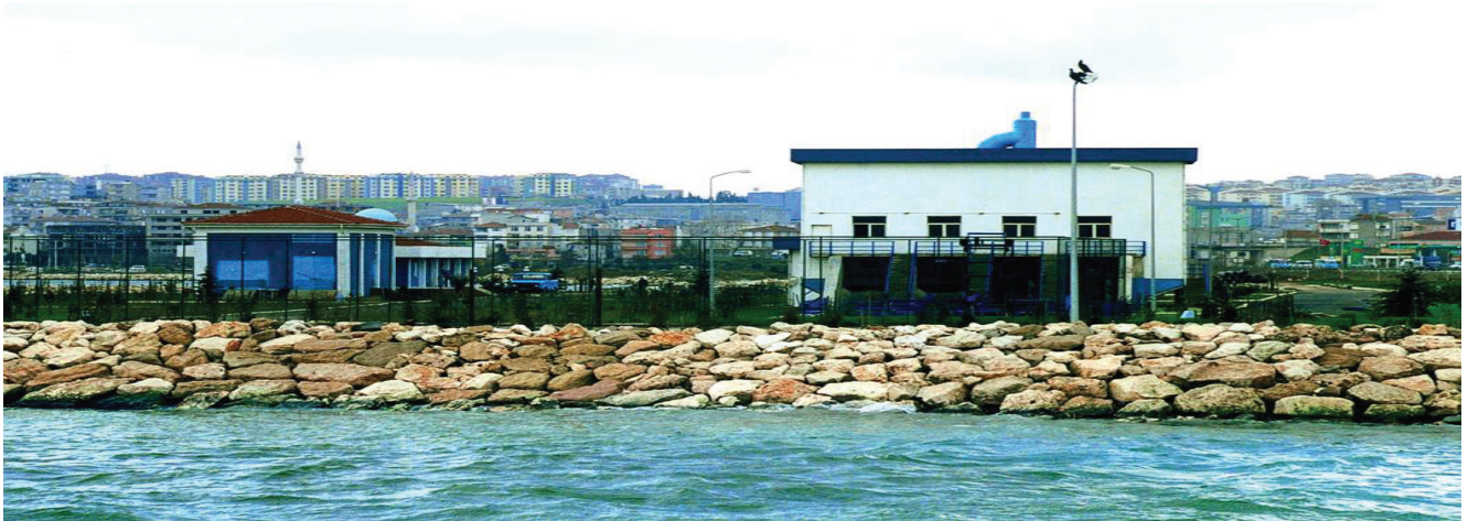
Büyükçekmece Atıksu Ön Arıtma Tesisi
