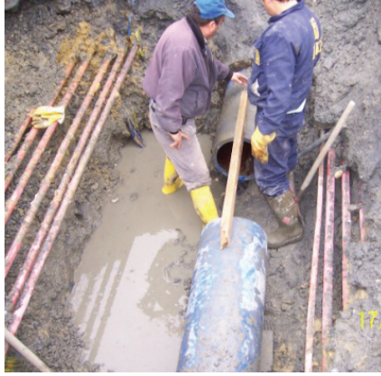
İkitelli Ön Gerilmeli Beton İçinde Ø400 mm HDP Boru Kırığı Tamiri
