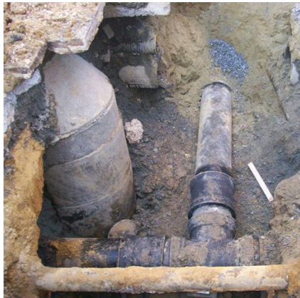
Esenler Ø400 mm Düktilfont İsale Hattı Bağlantıları
