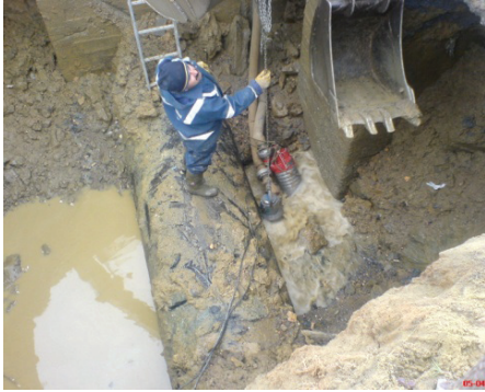
Pendik – Kartal Ø 1200 mm ÇB hatta tahliye bağlantı borusunda meydana gelen arızanın onarımı yapıldı.
