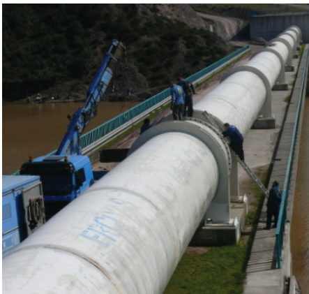
Yeşilçay-Ömerli Ø 3000 mm ÇGÖGBB hattın Darlık Barajı akadüğündeki genleşme parçalarının bakım ve onarımı yapıldı.
