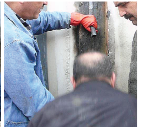
Yeşilçay-Ömerli Ø 3000 mm ÇGÖGBB hattın Darlık Barajı akadüğündeki genleşme parçalarının bakım ve onarımı yapıldı.
