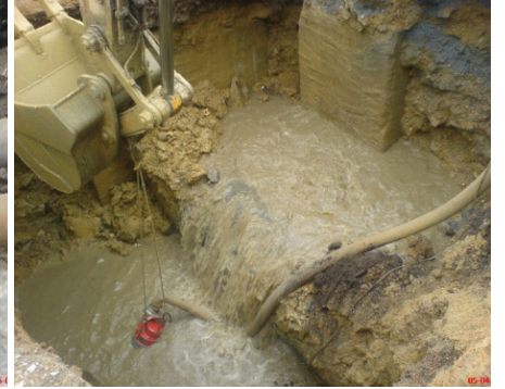
Pendik – Kartal Ø 1200 mm ÇB hatta tahliye bağlantı borusunda meydana gelen arızanın onarımı yapıldı.
