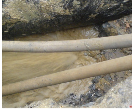
Pendik – Kartal Ø 1200 mm ÇB hatta tahliye bağlantı borusunda meydana gelen arızanın onarımı yapıldı.
