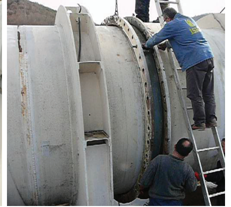
Pendik – Kartal Ø 1200 mm ÇB hatta tahliye bağlantı borusunda meydana gelen arızanın onarımı yapıldı.
