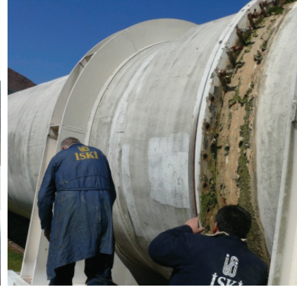
Pendik – Kartal Ø 1200 mm ÇB hatta tahliye bağlantı borusunda meydana gelen arızanın onarımı yapıldı.
