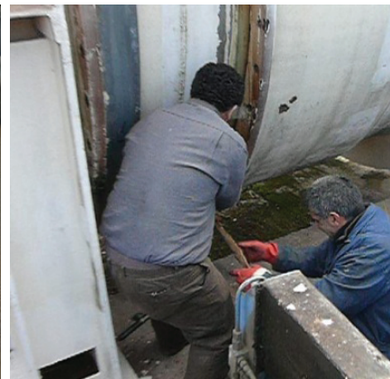
Yeşilçay-Ömerli Ø 3000 mm ÇGÖGBB hattın Darlık Barajı akadüğündeki genleşme parçalarının bakım ve onarımı yapıldı.
