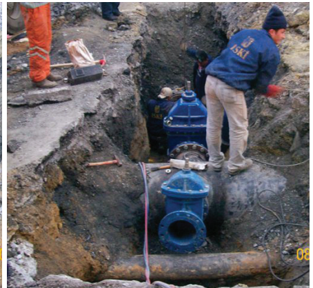
İkitelli Ön Gerilmeli Beton İçinde Ø400 mm HDP Boru Kırığı Tamiri
