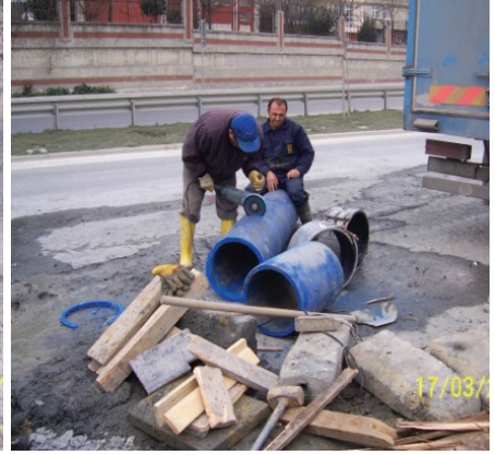
İkitelli Ön Gerilmeli Beton İçinde Ø400 mm HDP Boru Kırığı Tamiri
