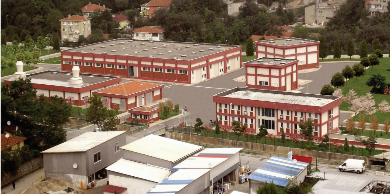
Paşabahçe Atıksu Ön Arıtma Tesisi
