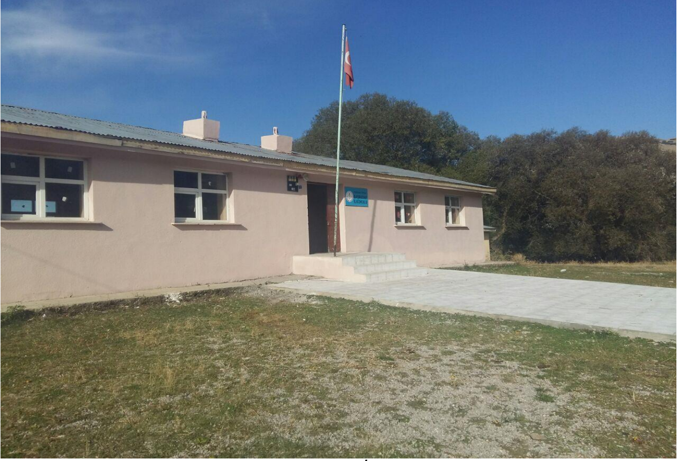
Erzincan Tercan Başbudak İlkokulu Onarımı
