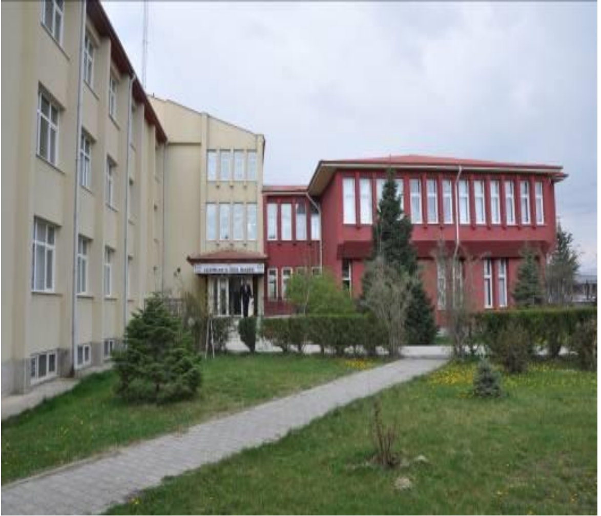
İl Özel İdaresi Hizmet Binası
