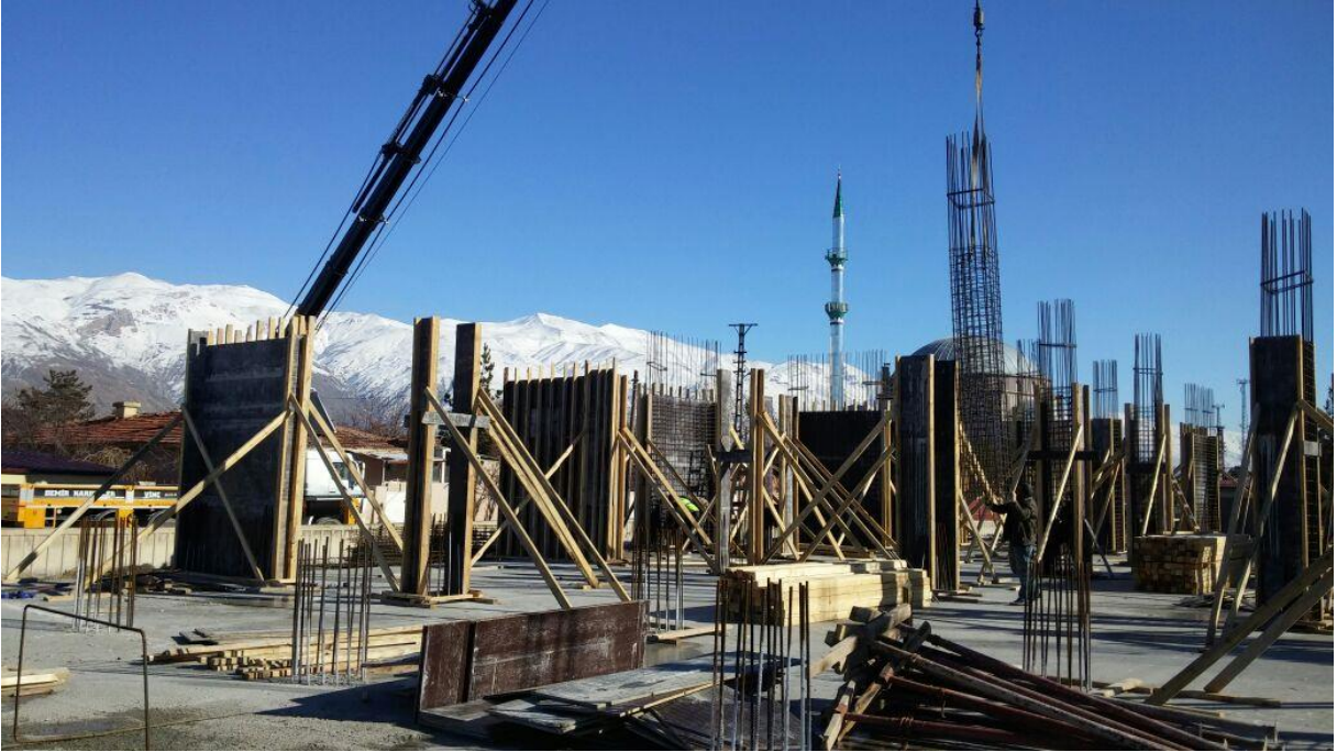
112 Acil Çağrı Merkezi Binası Yapım
