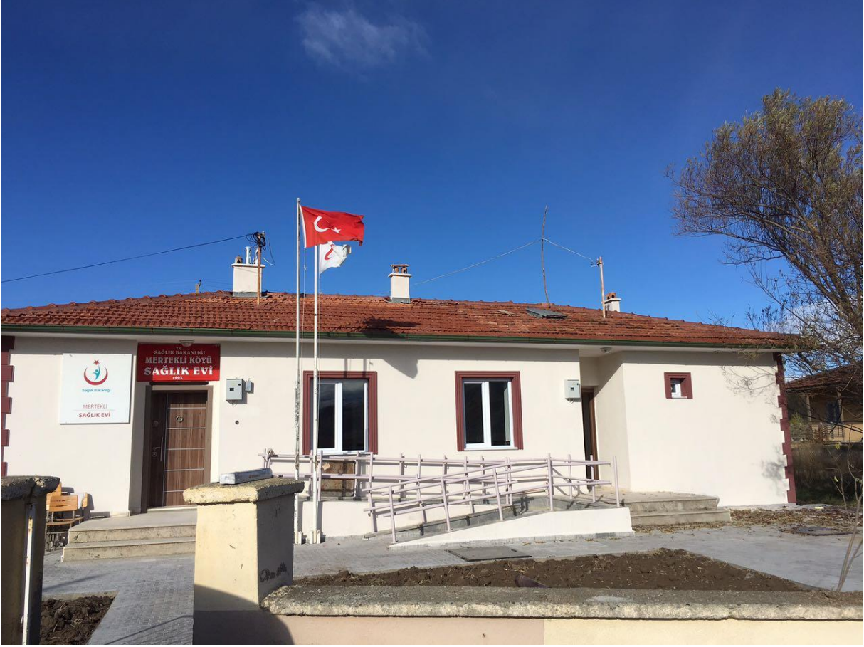
Erzincan Halk Sağlığı Müdürlüğü Aile Sağlığı Merkezleri Onarımı
