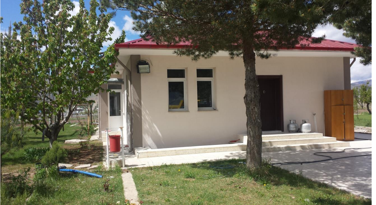
Erzincan İl Özel İdaresi Konkasör Tesisleri İdari Bina Onarımı
