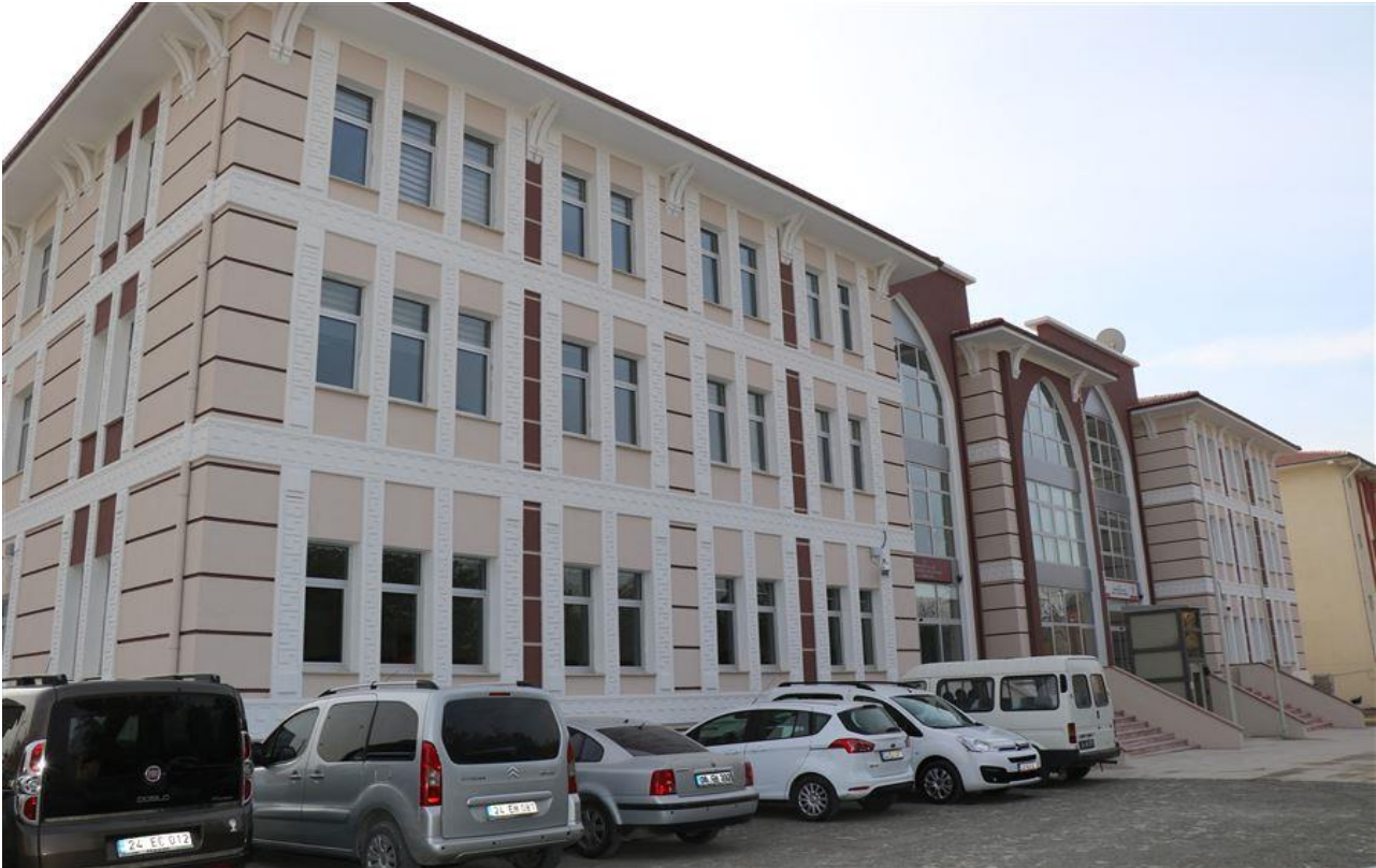
Erzincan Merkez Aile ve Sosyal Politikalar İl Müdürlüğü SHM Hizmet Binası
