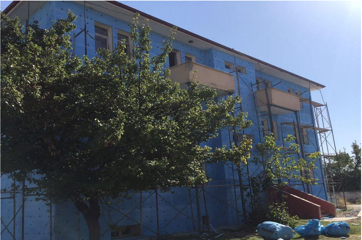
Erzincan İli Muhtelif Aile Sağlığı Merkezleri Onarımı
