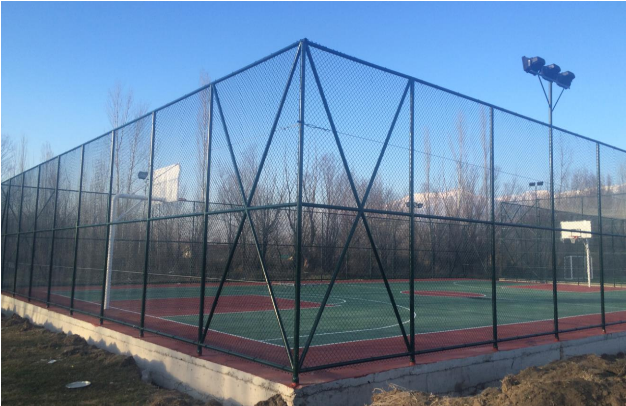
Sentetik Basketbol Sahası Yapımı
