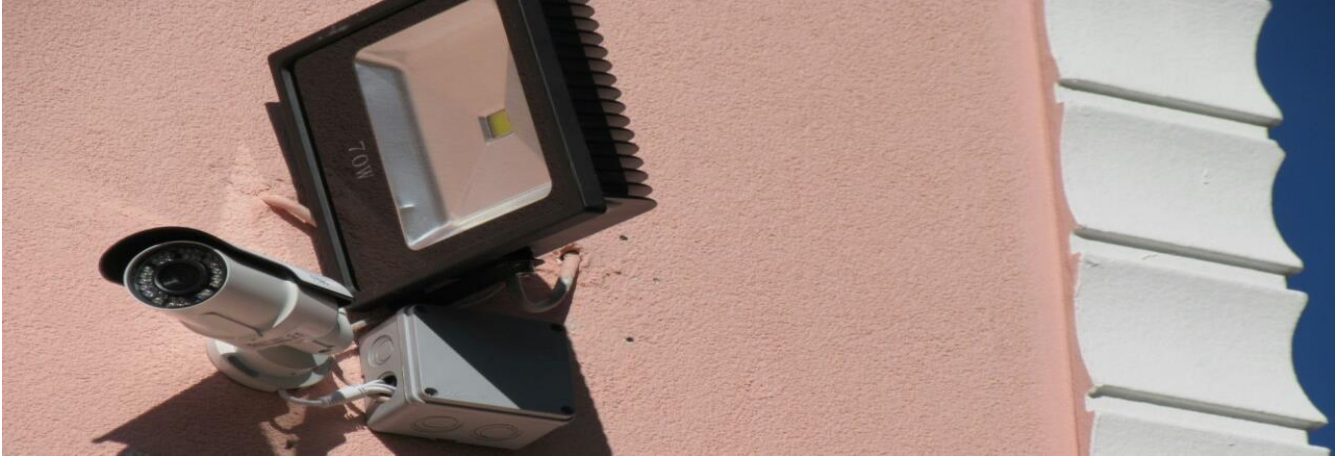
Çevre Aydınlatması ve Güvenlik Kamerası Yapımı
