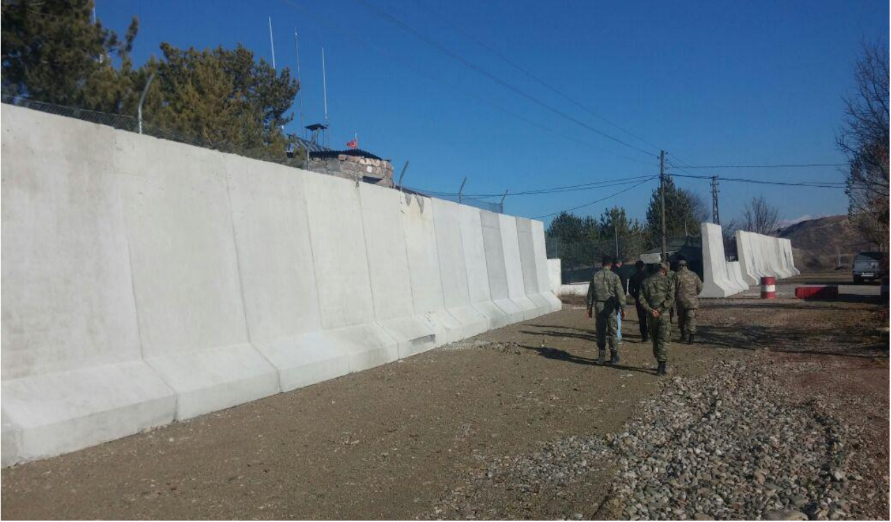
Kemah Alp Jandarma Karakolu Beton Bariyer Yapımı
