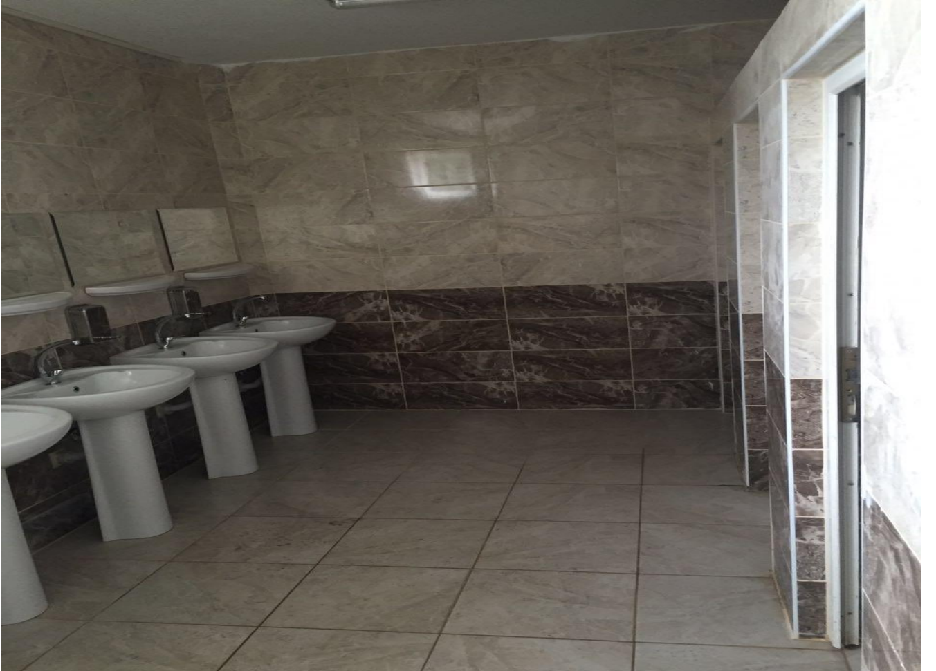
Wc Onarımı Yapımı
