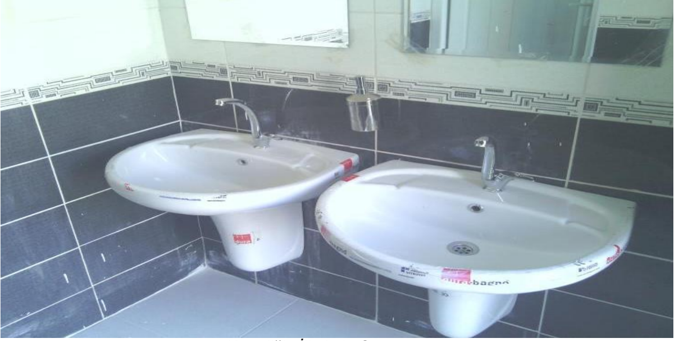
Karadiğın İlkokulu Onarımı
