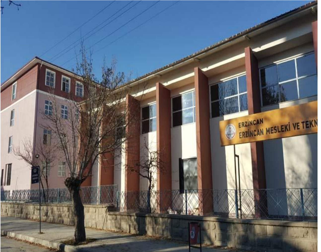
Teknik Endüstri Meslek Lisesi 16 Derslikli Okul ve Spor Salonu İkmal İnşaatı
