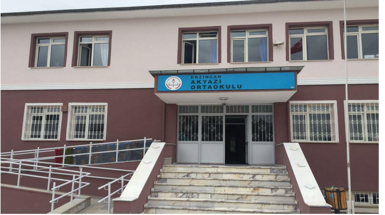
Akyazı Ortaokulu Onarımı
