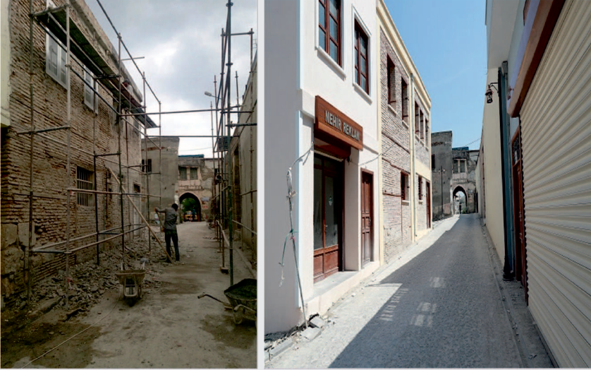
Avukat Turhan ARIN Sokağı, Sokak ve Cephe Sağıklaştırma Projesi
