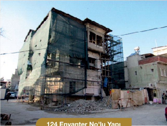
124 Envanter No'lu Yapı
