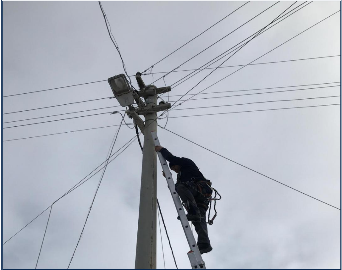
Şamandıra Kablosu Onarım İşİ
