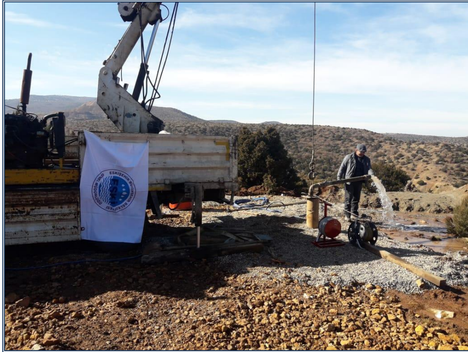
Su Sondajı Tecrübe Çalışması
