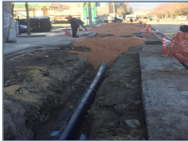
Ø225 mm PE100 Tramvay Hattı Deplase Çalışması
