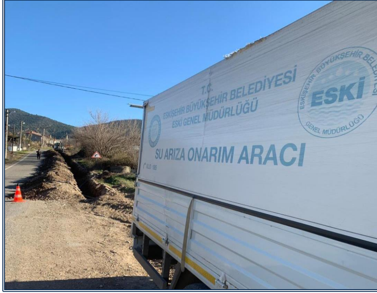
Terfi Hattı Kazı Çalışması
