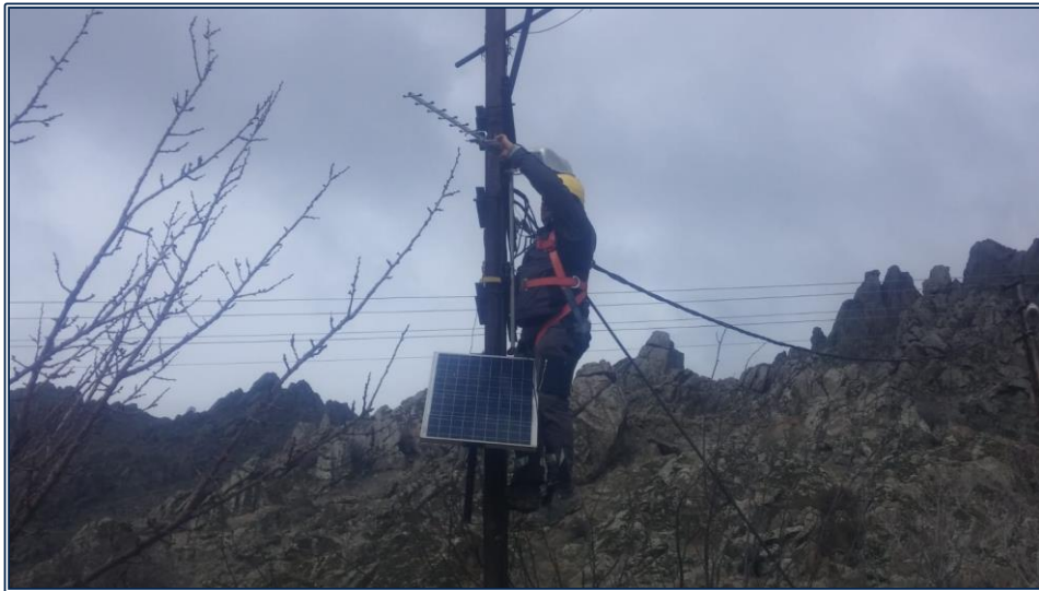
Anten Sistemi Kurulması İşi
