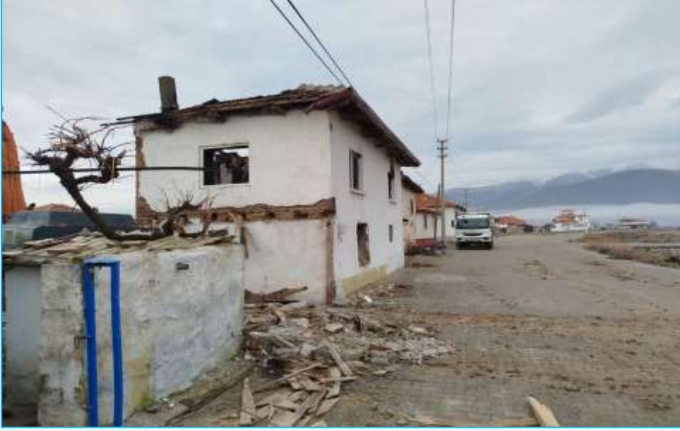
Yassihöyük mahallesi deprem hasarlı evlerin yıkımı
