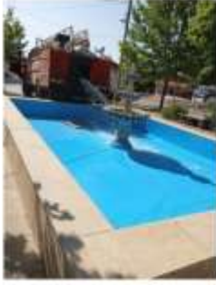
Sosyal tesis wc yapımı mutfak yenileme tamirata ve merkez havuz aktif edildi
