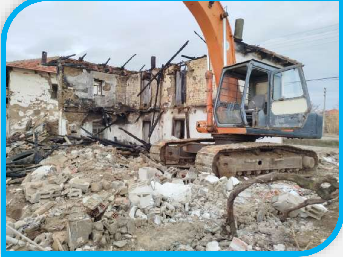
Yassihöyük mahallesi deprem hasarlı evlerin yıkımı
