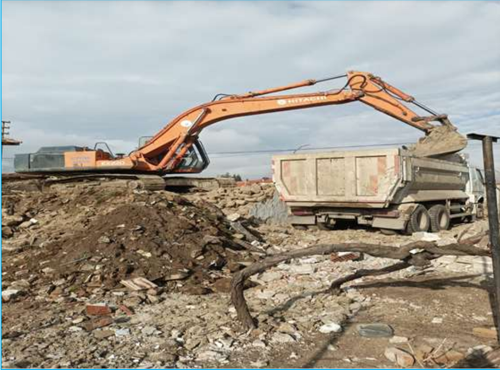
Yassihöyük mahallesi deprem hasarlı evlerin yıkımı
