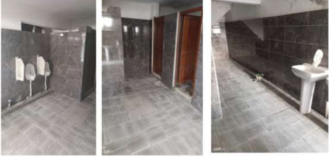
Yeşilyuva Mahallesi WC Yenileme
