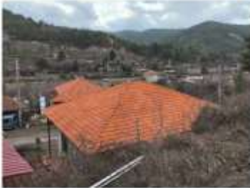
Boğazdere çatı yapıldı.
