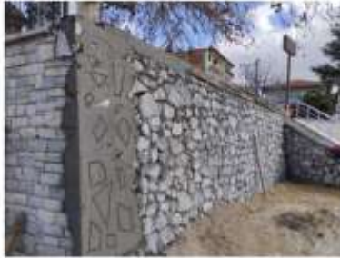
Yeşilyuva merkez istinat duvarı
