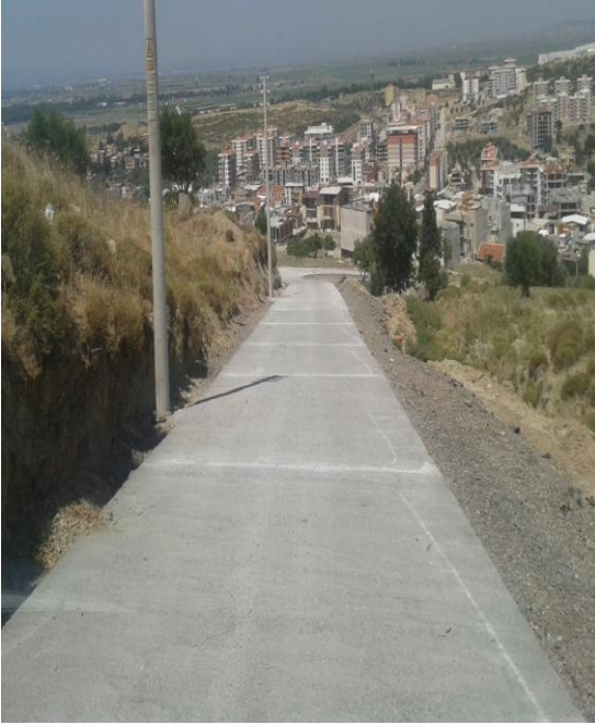
İnönü 9236 Sokak Beton Yol Çalışması
