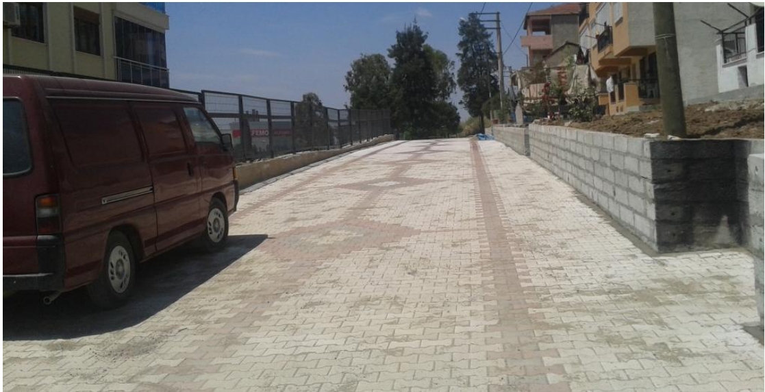
Küçük Çiğli 8785/3 Sokak Tretuvar ve Yol Çalışması
