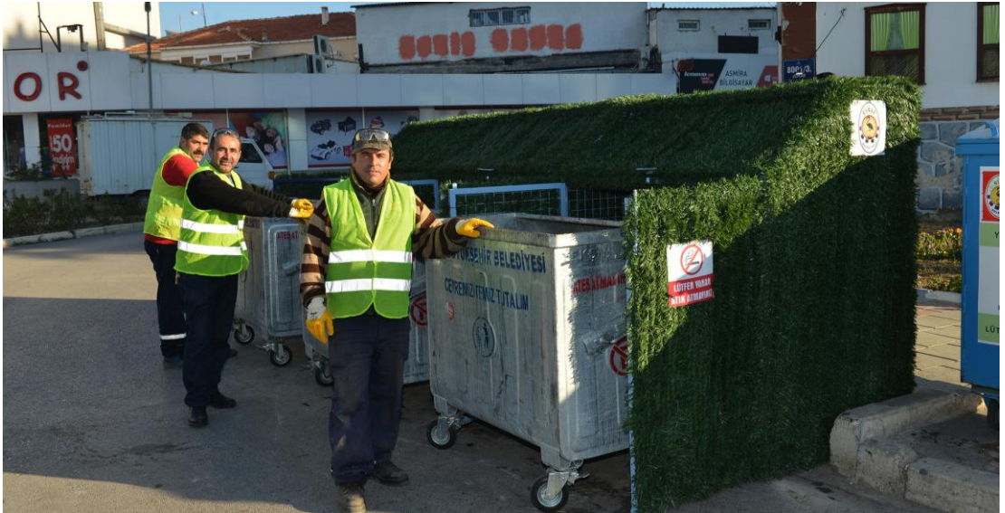
Yeni çöp konteynır alanlarının yapılması
