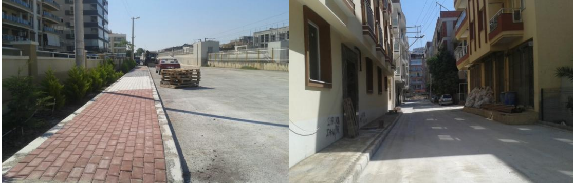
Küçük Çiğli 1671 Sokak ve 8754/1 sokak Tretuvar ve Beton Yol Çalışması
