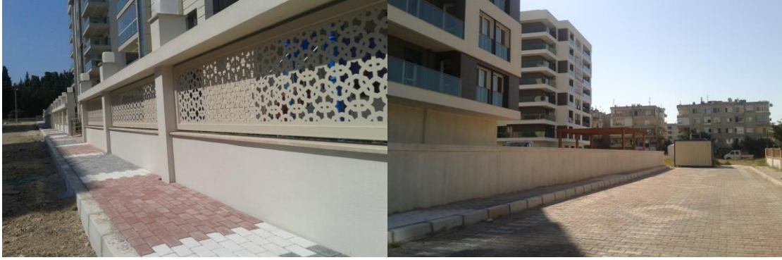
Ataşehir 8216/4 Sokak ve 8271/2 sokağın Tretuvar Çalışması
