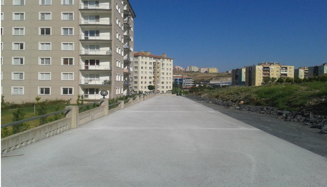
Cumhuriyet 9601/2 Sokak Beton Yol Çalışması
