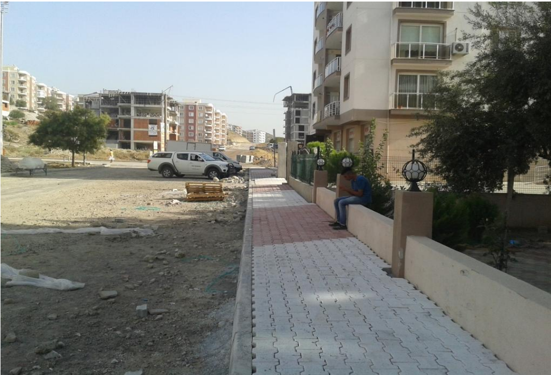
İnönü 9504_5 Sokak Tretuvar Çalışması
