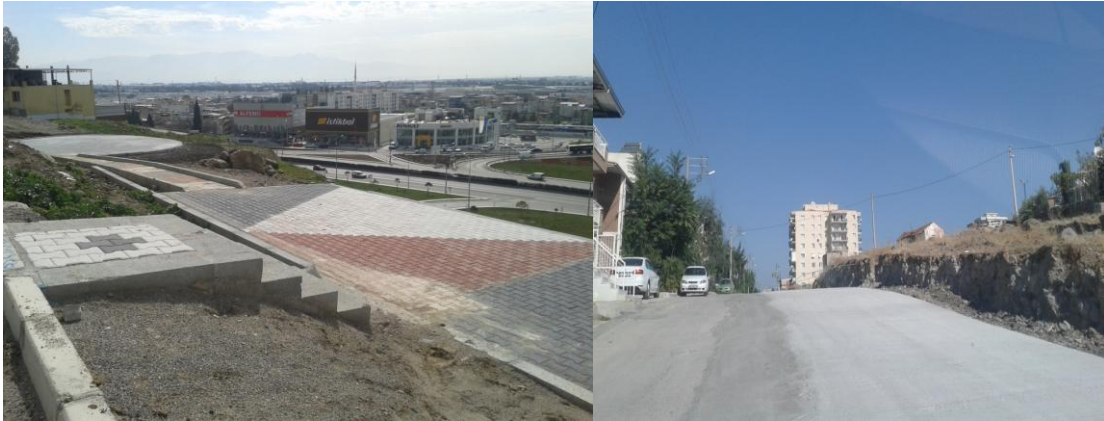
Esentepe 8809/3 Sokak Tretuvar Çalışması ve 8809/4 sokağın beton yol çalışması
