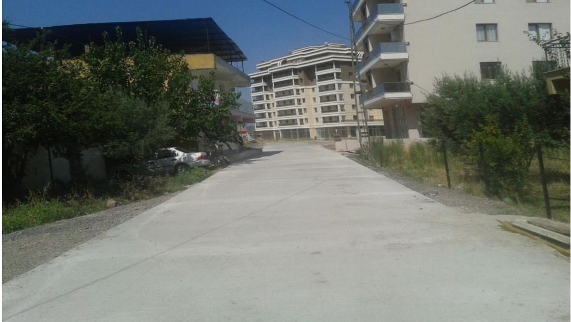
Balatçık 8788/1 Sokak Beton Yol Çalışması
