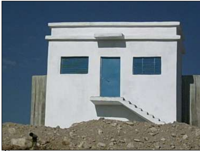
İçme suyu terfi binası
