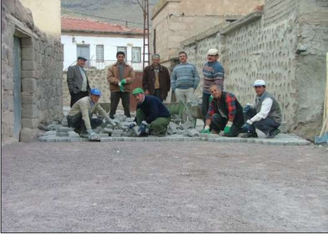
Köylere kilitli parke döşenmesi
