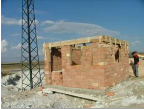
İçme suyu terfi binası inşaatı
