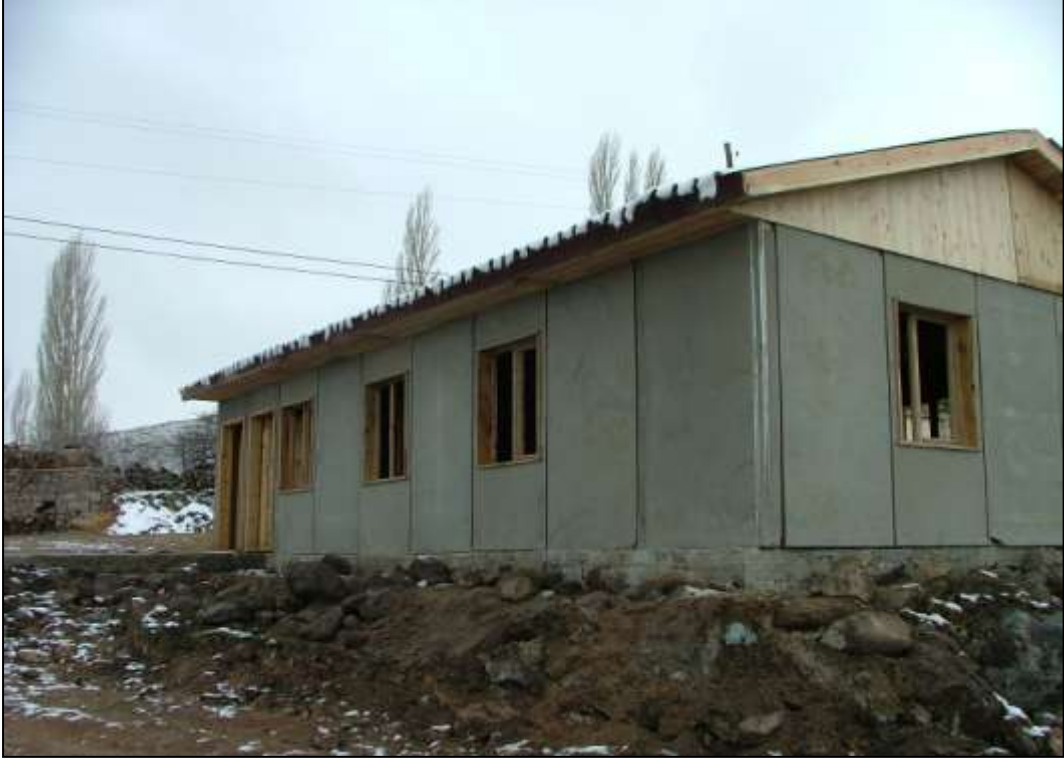
Muhtarlara köy konağı inşaatı
