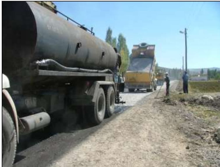
Köy yolları asfalt çalışmaları
