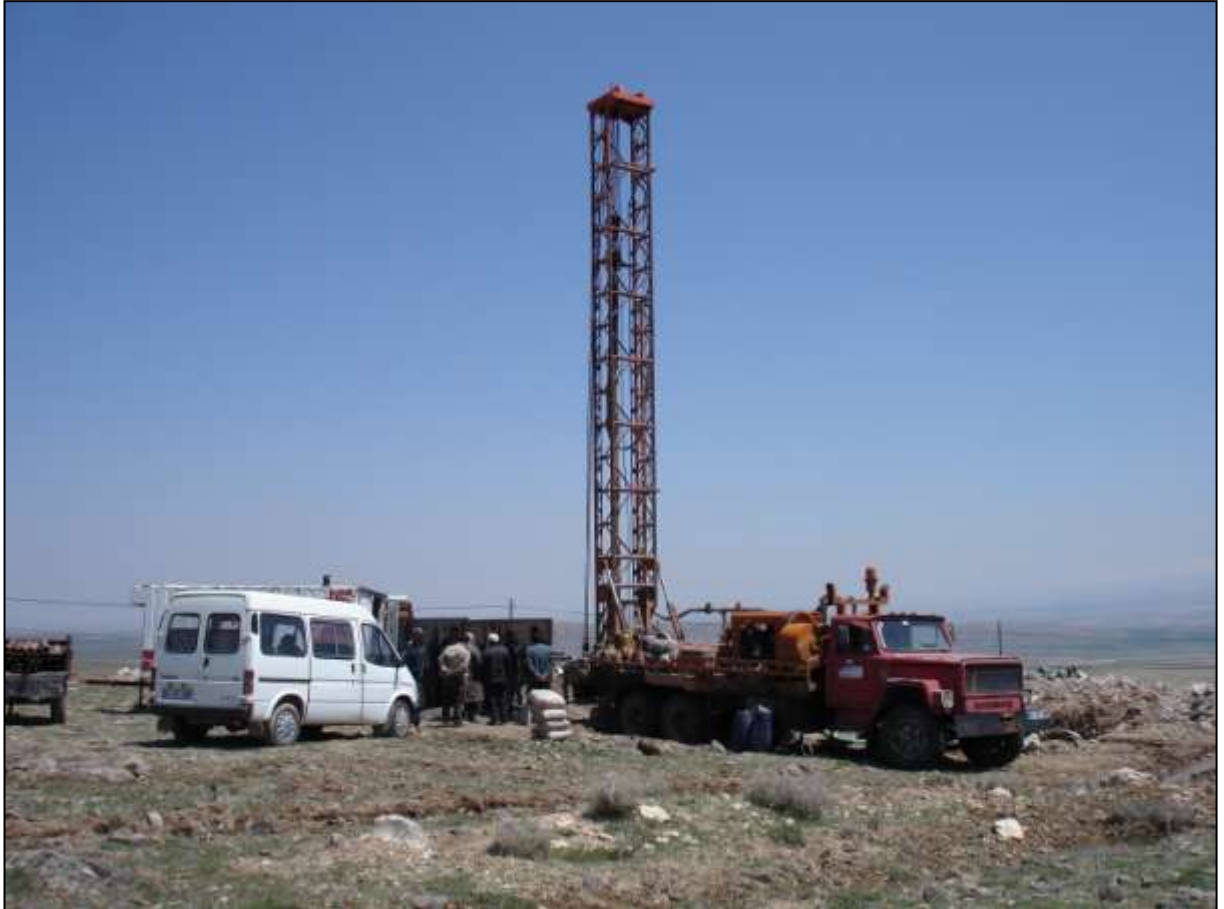
Sondaj kuyusu çalışması
