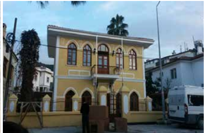
Güllük Sahil Sağlık Denetleme Merkezi Hizmet Binası Restorasyon İşİ
