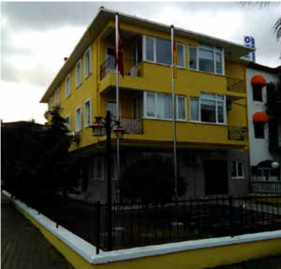
Çeşme Sahil Sağlık Denetleme Merkezi ve Lojmanları Muhtelif Onarım İşi
