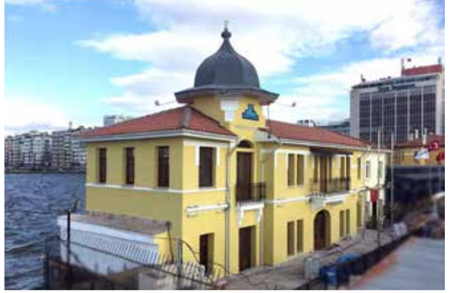
İzmir SSDM Hizmet Binası Restorasyon İşi
