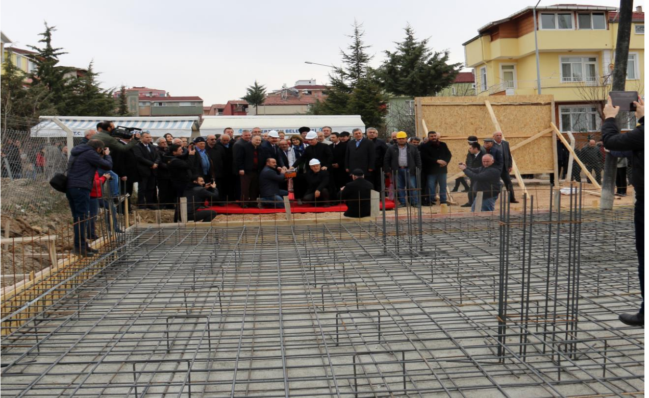
(Çerkes Evi inşaatı temel atma)
