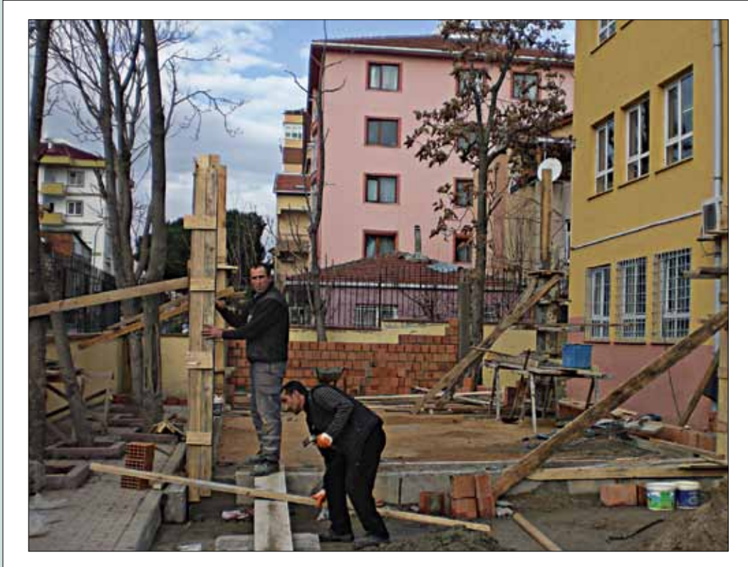
Karlıktepe Mah. A.Rıza Efendi İlköğretim Okulu Kantin Yapımı
