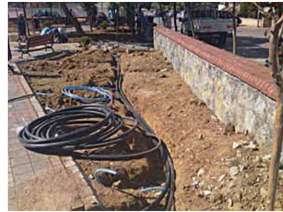
KORDONBOYU MAH. BAHAR PARKI TESİSAT HATTI YERLEŞTİRİLMESİ
