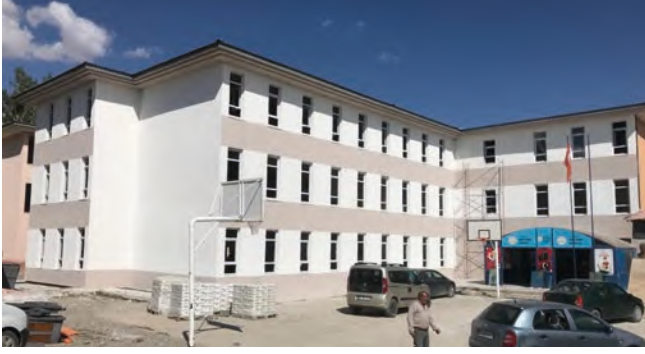
Karaçoban İsmet İnönü Okulu Mantolama ve Genel Onarımı
