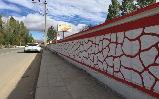
Hınıs İlçe Merkezi İstinat Duvarı Yapım İş
