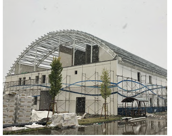
Olimpiyat Parkı Kapalı Spor Salonu Yapım İşi Toplam inşaat alanı : 3025 m 2 'dir
