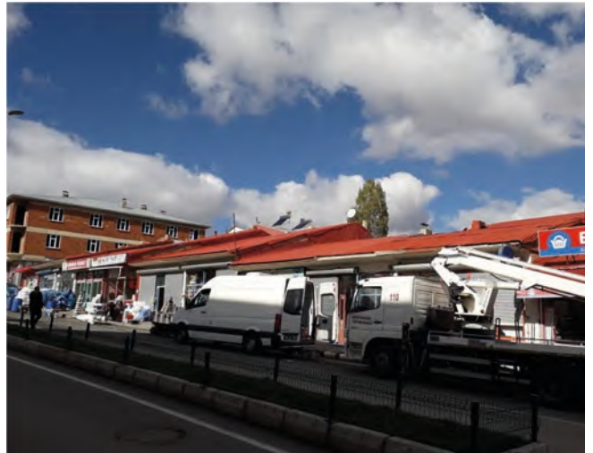
Çat İlçemiz Prestij Caddesi Çatıları Tarafımızdan Tamiri Yapılarak Boyandı.
