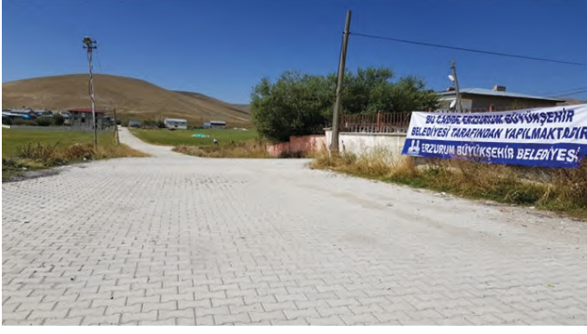
Aziziye İlçesi Toprakkale Mahallesi Kilit Parke ve Beton Bor- dür Çalışması
