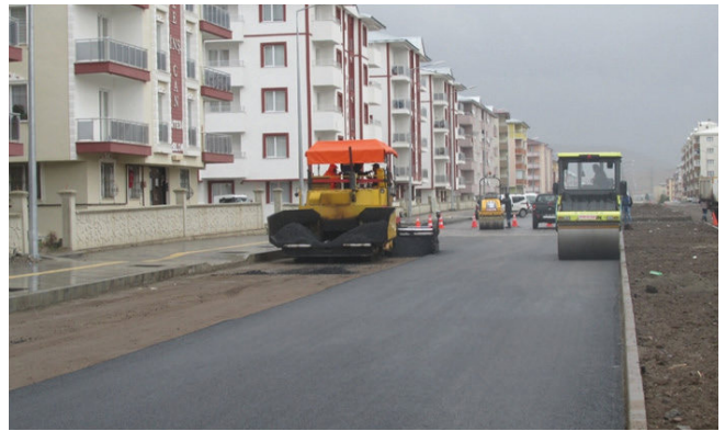
Yakutiye İlçesi Şehzade Sokak Asfalt Serim Yapım Çalışması
