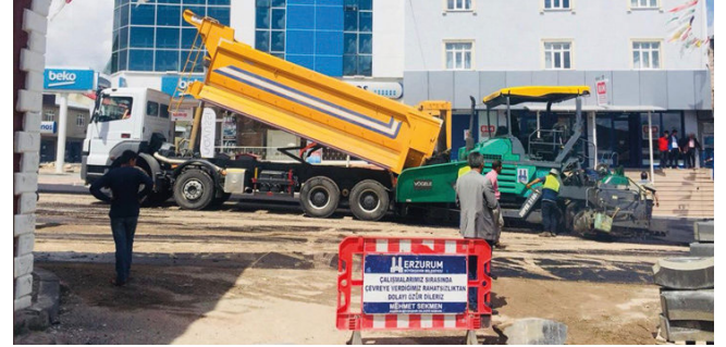
Karayazı İlçe Merkezi Asfalt Serim Yapım Çalışması
