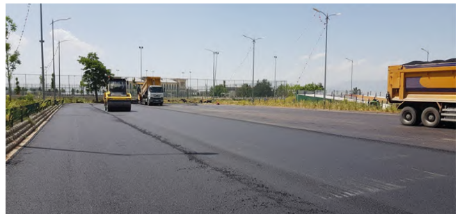
Kazım Karabekir Stadyum Otoparkı Asfalt Serim Çalışması
