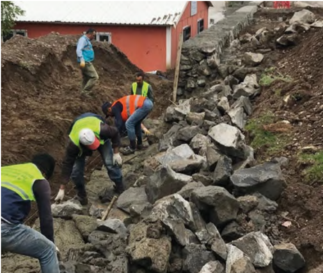
Palandöken İlçesi Yunus Emre Mahallesi Taş Duvar Yapım Çalışması
