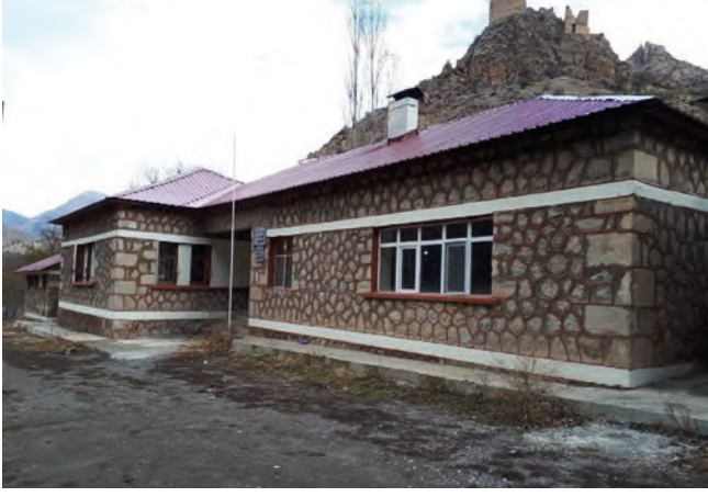
Uzundere Sapaca Köy Konağı Tadilatı
