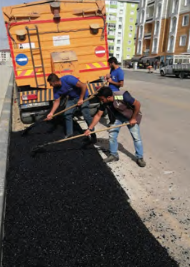
Kosova Caddesi Asfalt Yama Yapım Çalışması
