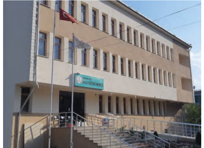
Oltu Halk Eğitim Binası Mantolama Çalışması
