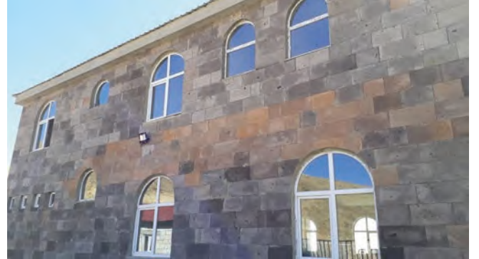
Hınıs Sıldız Cem Evi Bakım ve Onarım Çalışması
