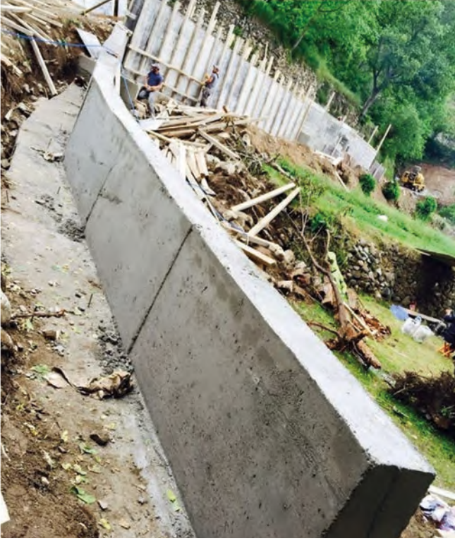
Tortum Derekapı Beton İstinat Duvarı Yapımı
