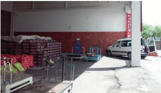
Haldeki Dükkan Tadilatları ve İzolasyon Çalışması
