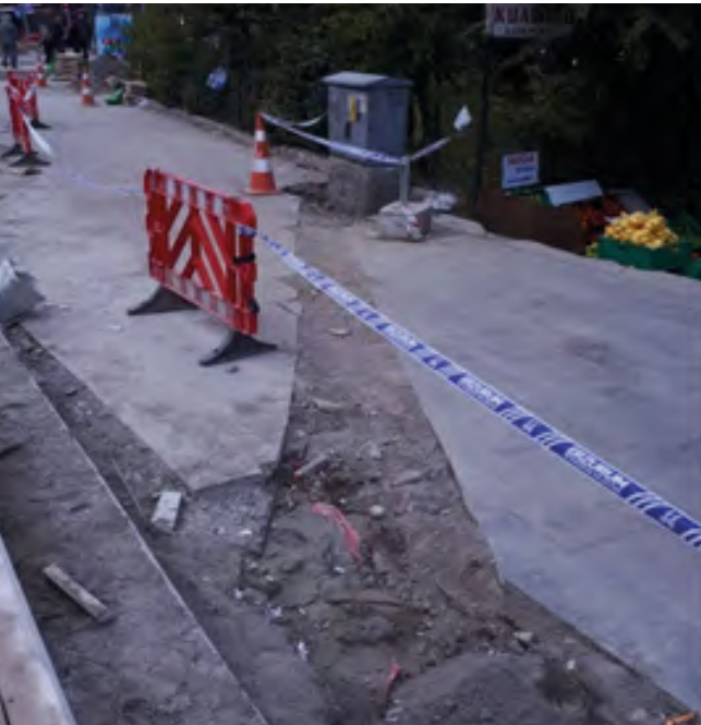
Gez Mahallesi Mevki Box Deplase Yapım İşi
