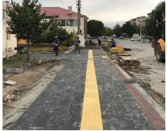
Palandöken Sultan Alparslan Caddesi Beton Parke ve Beton Bordür Yapım Çalışması
