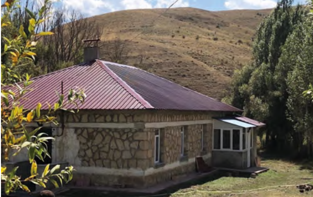
Aşkale Merkez Çatören Köy Konağı Çatısı
