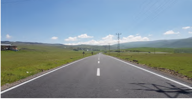
Çat İlçesi Ağaköy Mahallesi Asfalt Serim Yapım Çalışması
