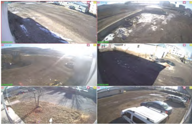
Horasan İlçe Şantiyesi 9 IP kamera kurulumu yapılarak merkezimizden izlenebilmektedir.
