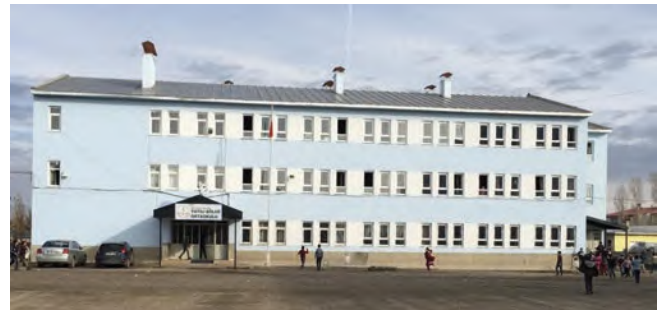
Horasan YBO Bakım Onarımı
