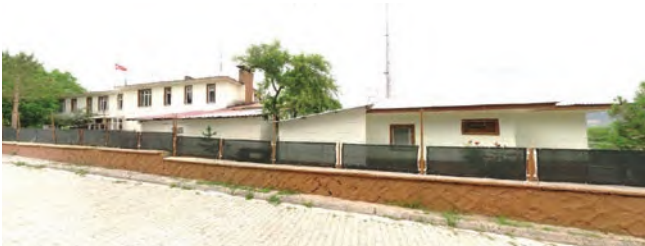
Olur İlçe Jandarma Binası Bakım Onarım Çalışması
