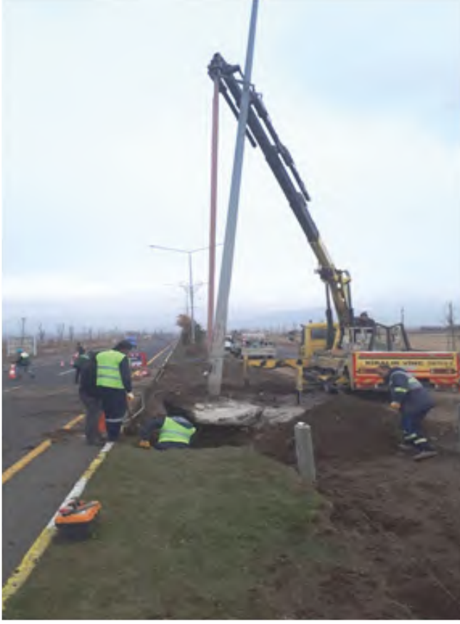
Havaalanı Yolu Direk Deplase Yapım İşi
