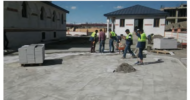
Yakutiye İlçesi Güllüce Camii Andezit Plak ve Andezit Bordür Yapım Çalışması
