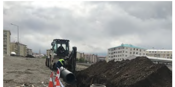
Yakutiye İlçesi Kosova Caddesi Yağmur Suyu Hattı Yapım Çalışması
