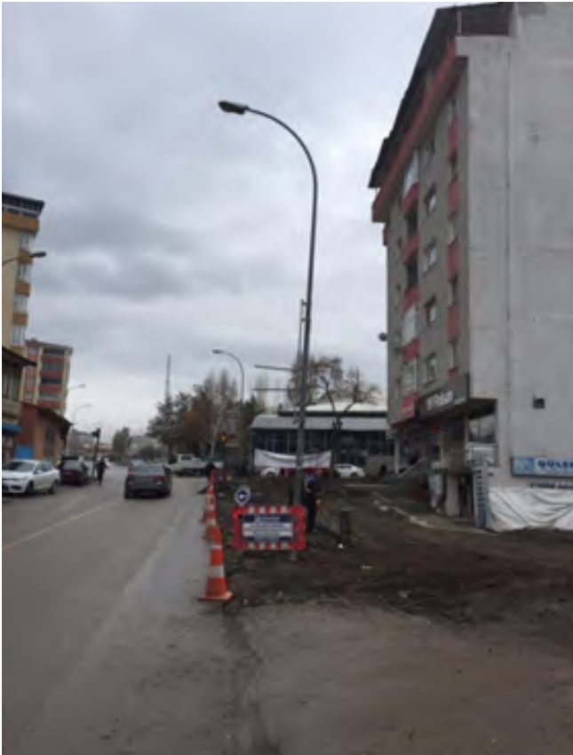
Şükrü Paşa Cami Önüdirek Deplase Yapım İşi
