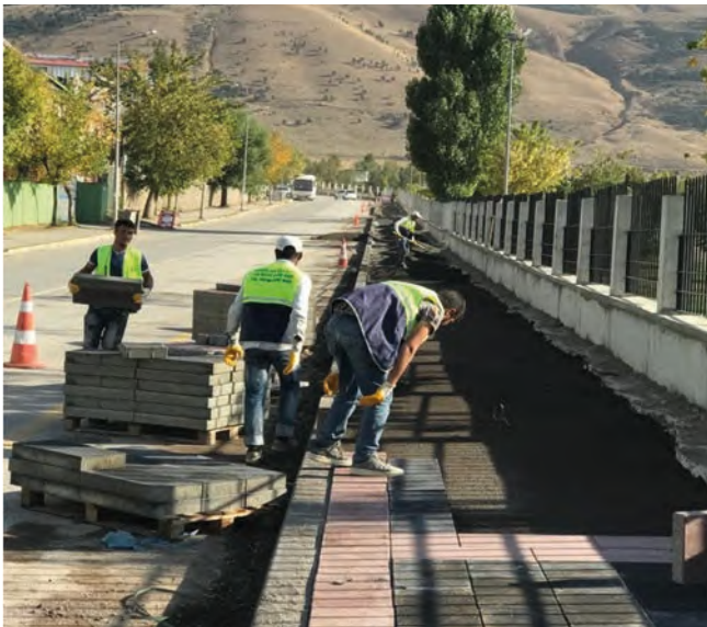
Palandöken İlçesi Recep Tayyip Erdoğan Parkı Çevresi Beton Parke ve Beton Bordür Yapım Çalışması
