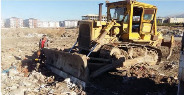
1415 Adet İş Makinesi Arazi ve Atölyemizde Bakım Onarımı Yapılmıştır.
