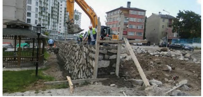
Yakutiye İlçesi Tepe Mezarlık Caddesi Taş Duvar Yapım Çalışması
