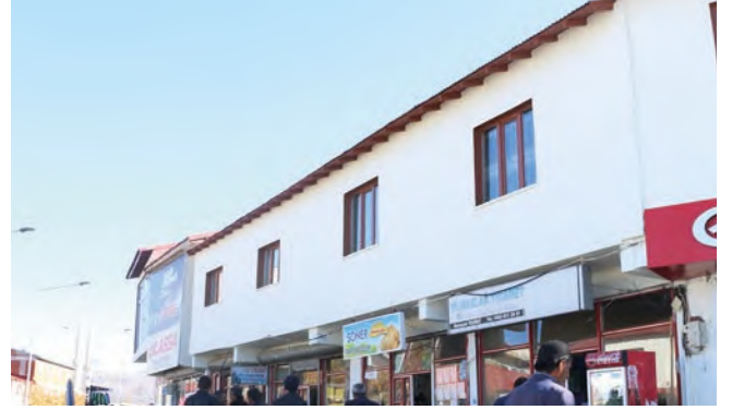
Çat İlçesi Cephe Sağıklaştırma Çalışması
