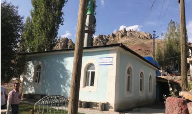
Narman Kışlaköy Cami Onarımı
