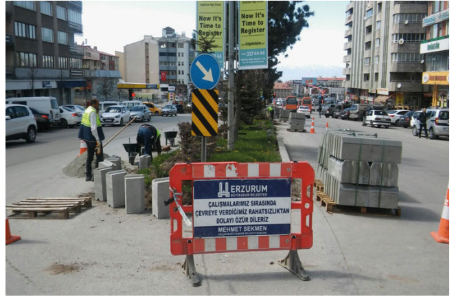
Yakutiye İlçesi Orhan Şerifsoy Caddesi Orta Refüj Beton Bordür Yapım Çalışması
