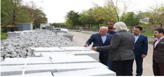
Beton Parke ve Beton Bordür Yapım Çalışması
