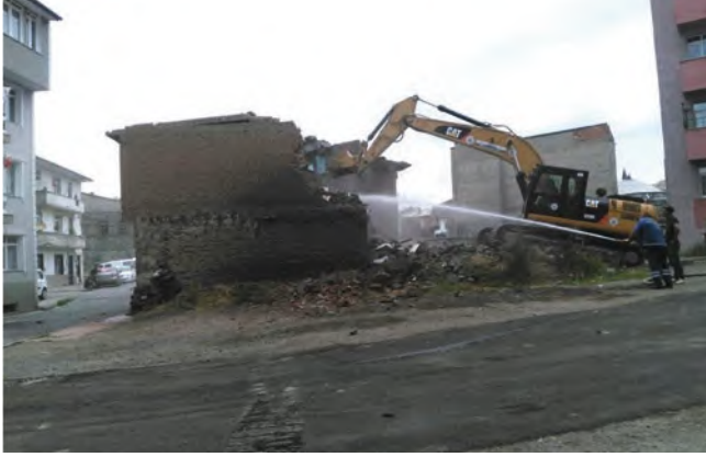
Yakutiye İlçesi Kazım Karabekir Mahallesi Kentsel Dönüşüm Çalışması
