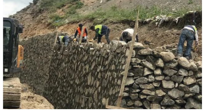
Palandöken İlçesi Çat Yolu Taş Duvar Yapım Çalışması
