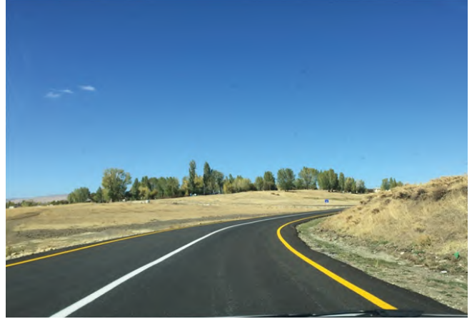
Hınıs İlçesi Muş Yolu Bağlantısı Asfalt Serim Yapım Çalışması
