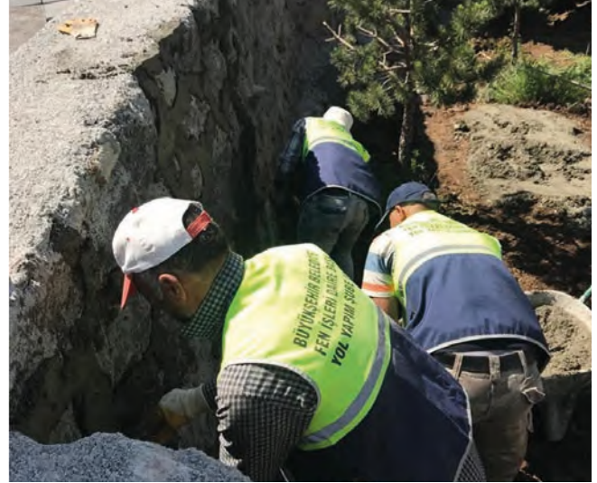
Palandöken İlçesi Atatürk Bulvarı Taş Duvar Yapım Çalışması
