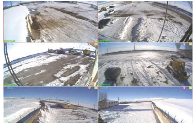
Karayazı İlçe Şantiyesine 10 IP kamera kurulumu yapılarak merkezimizden izlenebilmektedir.
