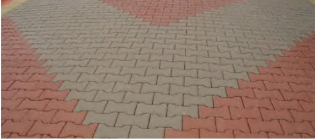
Parke Taşı Ve Bordür Yapımı
