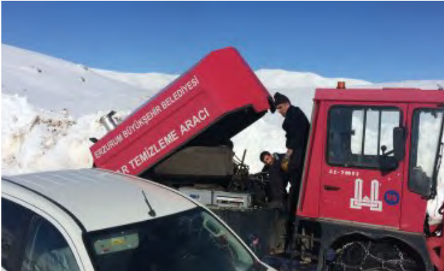
Rotatif ve Trak Araçlarımızın Bakım ve Onarımları
