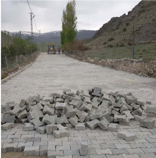
Tortum İlçesi Tortum Kale Mahallesi Kilit Parke ve Beton Bor- dür Çalışması
