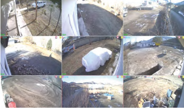
Olur İlçe Şantiyesine 12 IP kamera kurulumu yapılarak merkezimizden izlenebilmektedir.
