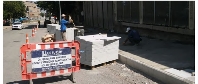
Yakutiye İlçesi Nenehatun Caddesi Andezit Plak ve Andezit Bordür Yapım Çalışması
