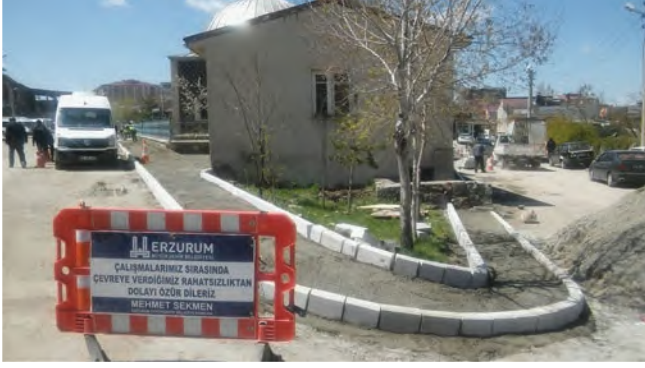
Yakutiye İlçesi Hacı Hasan Camii Andezit Plak ve Andezit Bordür Yapım Çalışması
