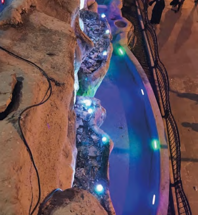
Müceldili Konağı Şelale Led Ve Wallwasher Aydınlatma Yapım İş
