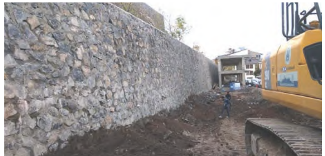
Yakutiye İlçesi Bat Pazarı Taş Duvar Yapım Çalışması
