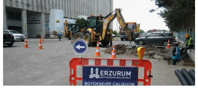
Yakutiye İlçesi Yönetim Caddesi Yağmur Suyu Kılcal Hattı Ya- pım Çalışması
