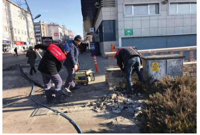
Sorumlu Olduğumuz Alanlarda 1095 adet Elektrik Arızası Onarımı.
