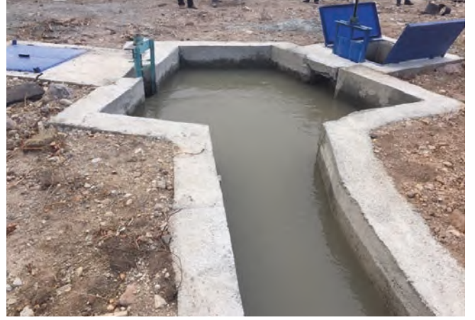
Pasinler Porsuk Mahallesi Sulama Tesisi Çalışması
