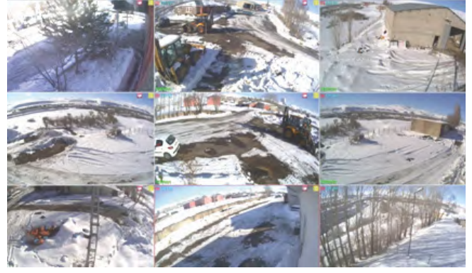
Tekman İlçe Şantiyesine 15 IP kamera kurulumu yapılarak merkezimizden izlenebilmektedir.
