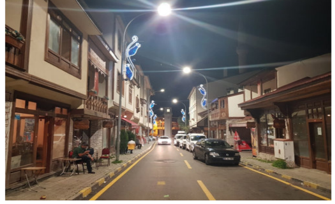
Uzunlere İlçesi Prestij Cadde Yapım Çalışması
