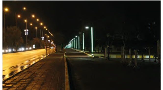
Aydınlatma Yapım İşleri
