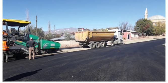
Narman İlçesi Şekerli Mahallesi Asfalt Serim Yapım Çalışması
