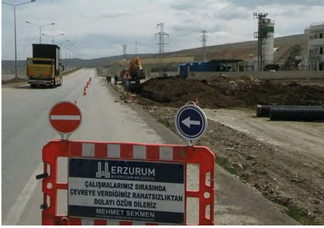
Yakutiye İlçesi Kurtuluş Mahallesi Yağmur Suyu Hattı Yapım Çalışması
