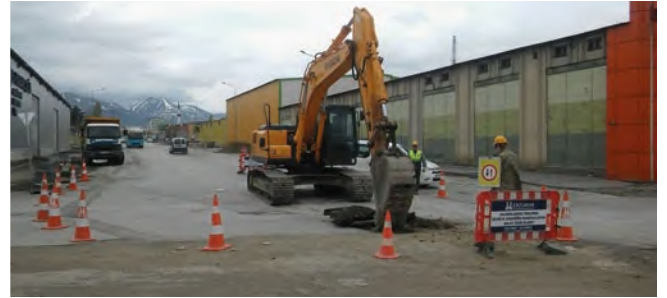
Yakutiye İlçesi Endüstri Caddesi Yağmur Suyu Hattı Yapım Çalışması
