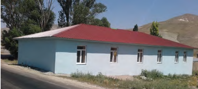
Mescitli Taziye Evi İç Dış Cıva Cephe Mantolama Kapı Ve Pencerelerin Yapımı Seramik Yapımı
