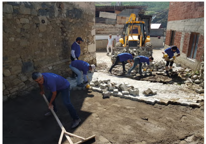
Aziziye İlçesi Rizekent Mahallesi Kilit Parke ve Beton Bordür Yapım Çalışması
