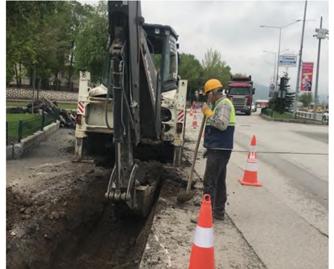
Palandöken İlçesi Eşref Bitlis Caddesi Yağmur Suyu Hattı Ya- pım Çalışması
