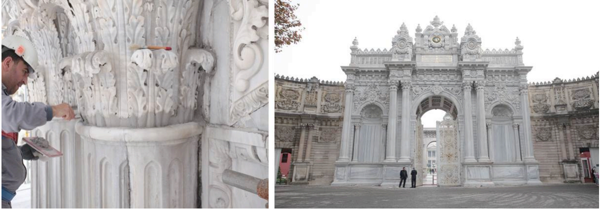
Hazine Kapısı Batı Cephesi Taş Temizliği ve Onarımı
