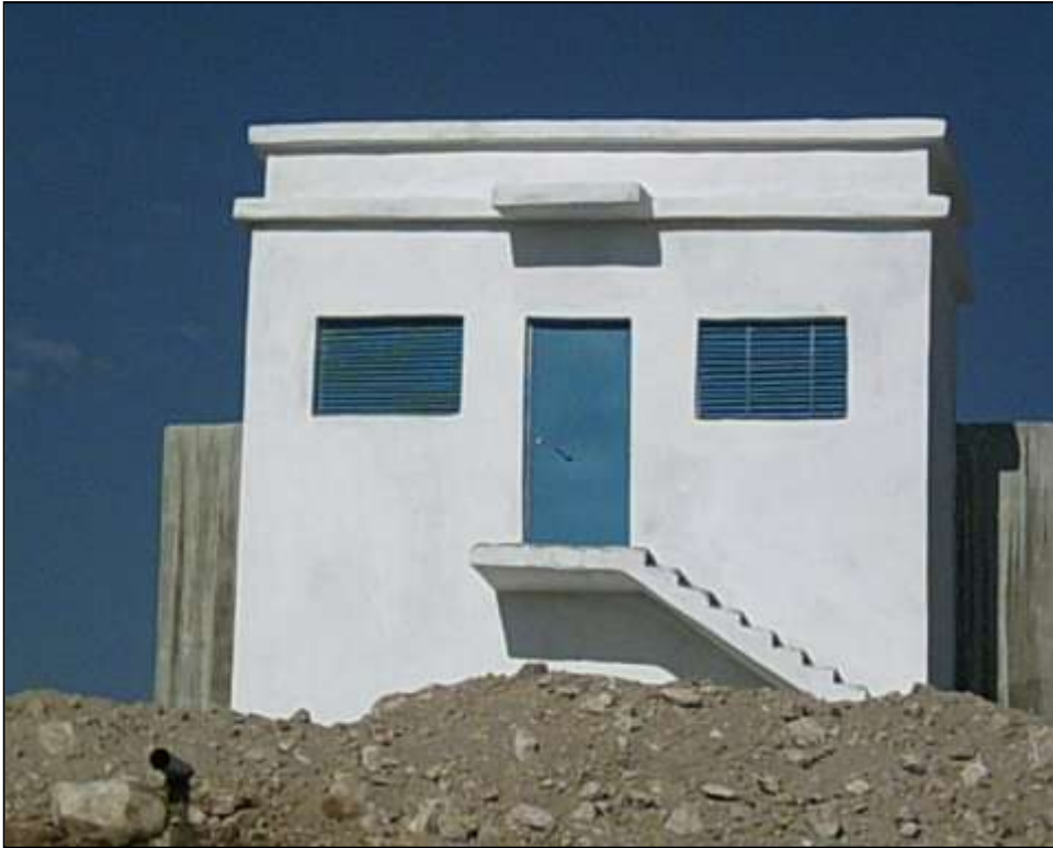
İçme Suyu Terfi Binası
