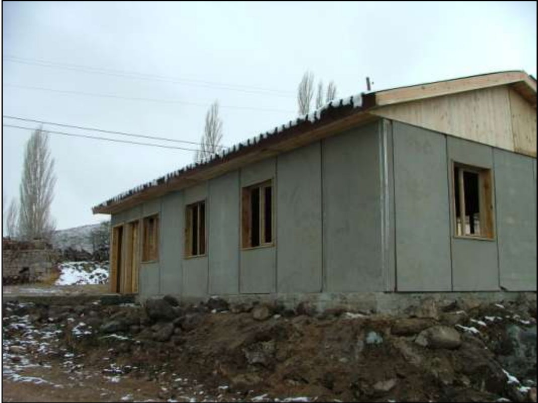
Köy Konağı Çalışması
