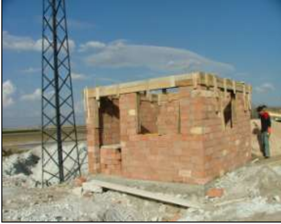
İçme suyu terfi binası inşaatı
