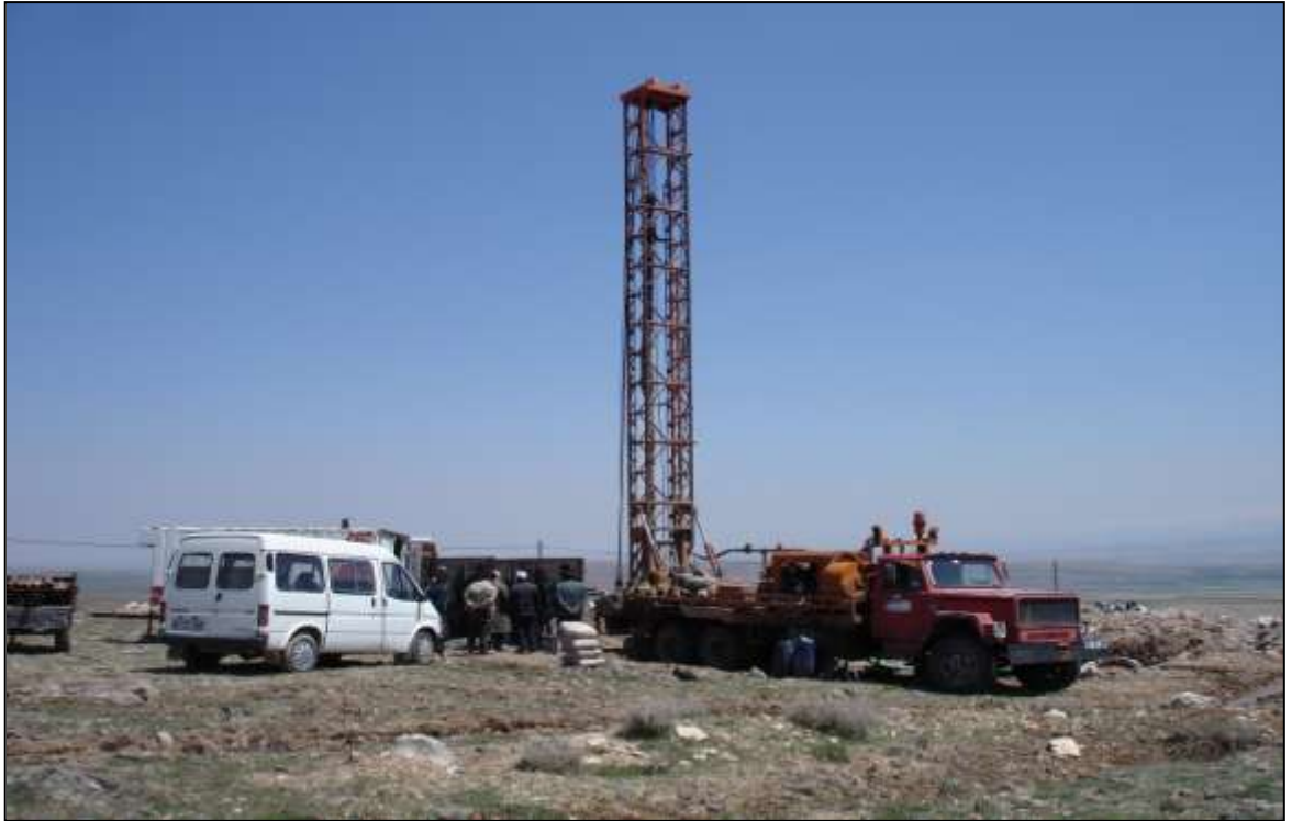
Sondaj Kuyusu Çalışması
