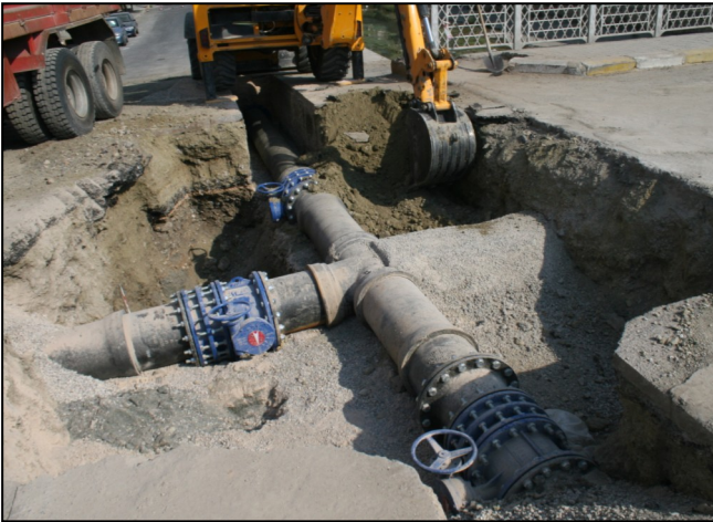
Su Şebekesi Döşeme Çalışmaları
