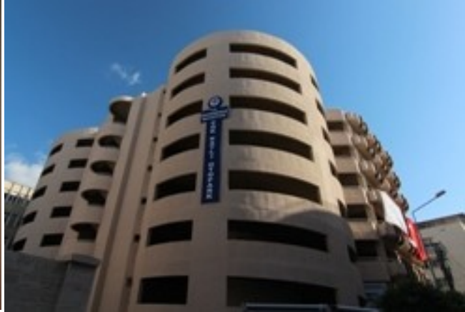
Bakım Onarımı Yapılan Katlı Otoparkımız
