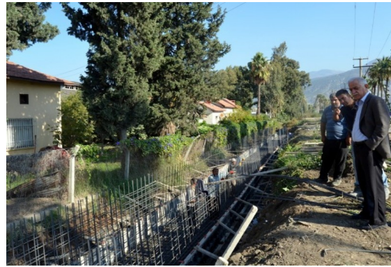
D. Demir Yolları Sahası Yağmursuyu Kanal Çalışması
