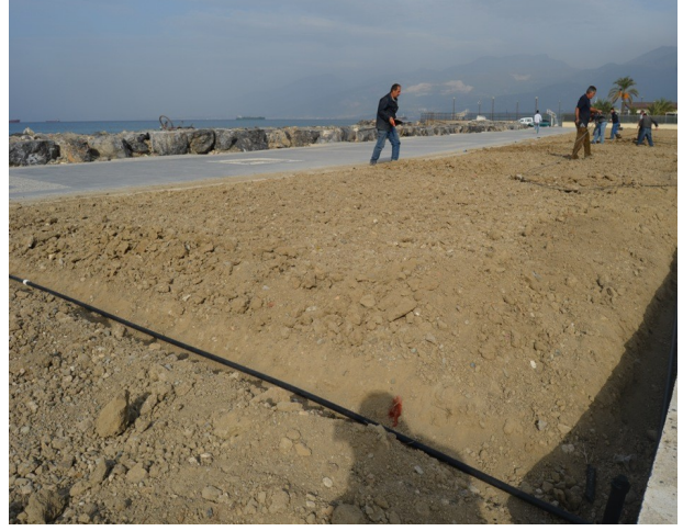
Sahil Bandına Yerleştirilen Sabit Sulama Sistemi
