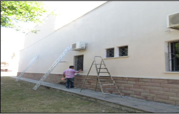
İç ve Dış Cephenin Boyanması
