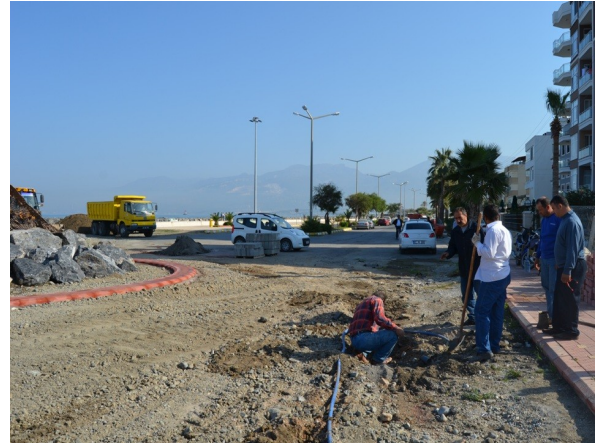
Aşıklar Parkına Kurulan Otomatik Sulama Sistemi
