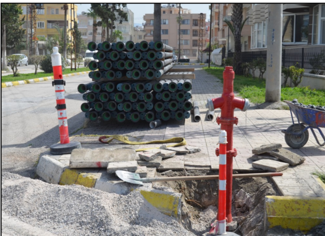
Yeni Su Şebekesi Döşenen Caddelere Yangın Hidrantlarının Yerleştirilmesi
