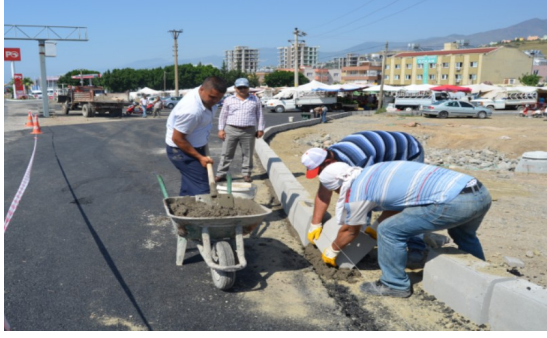
E-91 Üzeri Bordür Döşenmesi
