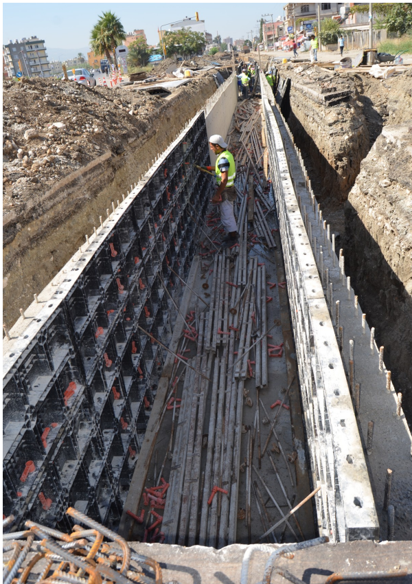
Arsuz Yolu Kanal Çalışması
