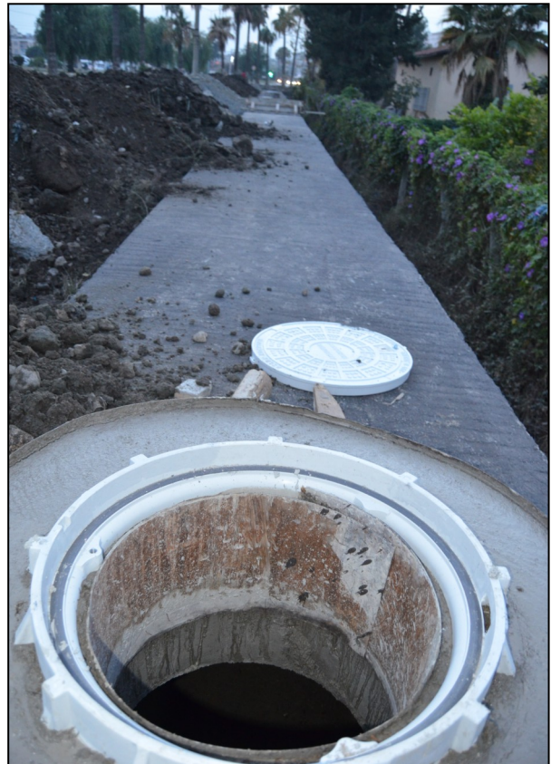
D. Demir Yolları Sahası Yağmursuyu Kanal Çalışması
