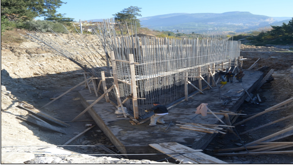
Akçay Deresi üzerine Betonarme Köprü Ayak Temelleri (Güzelçay Mahallesi )
