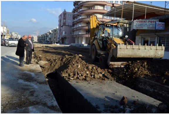
Gürsel Mahallesi Yağmursuyu Kanal Çalışması
