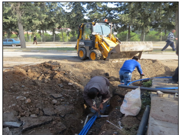
Su Şebekesi Döşeme Çalışmaları
