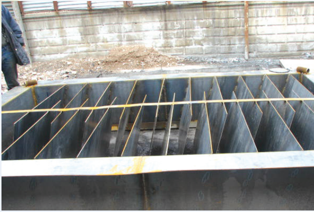
Plastik Geri Dönüşüm İşletmeleri Atıksu Arıtma Tesisleri
