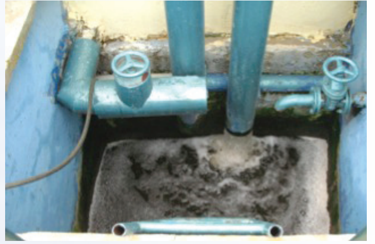
Resim 15. Başarakavak Atıksu Arıtma Tesisi Çıkış Suyu Kalitesi
