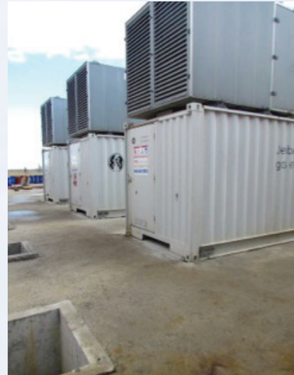
Resim 10. Gaz motorları bölgesi beton saha
