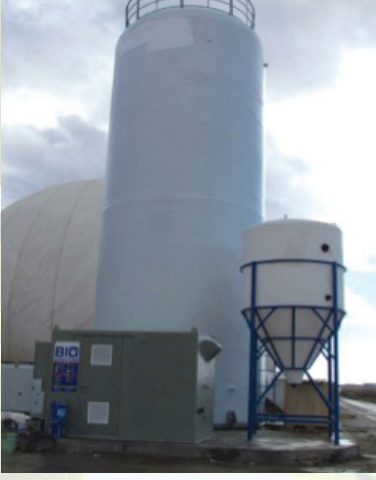
Resim 11. Yeni kurulan Desülfürizasyon ünitesi
