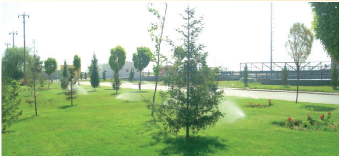
Atıksu Arıtma Tesisi son hali
