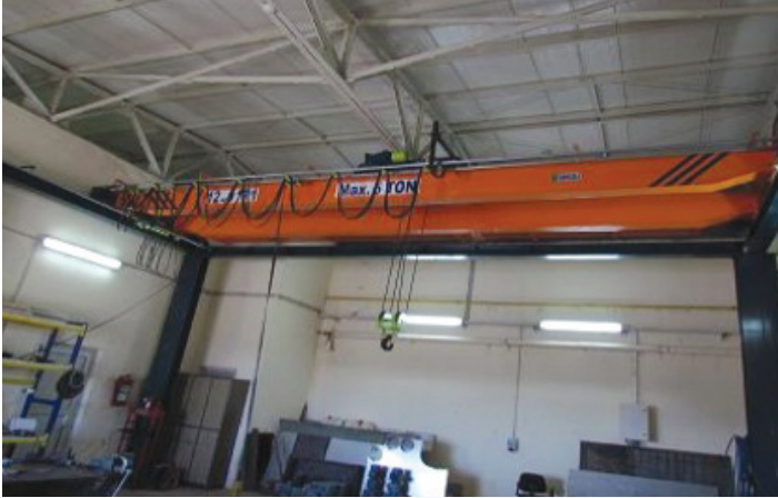
Resim 7. Atölye binasına kurulan gezer vinç sistemi
