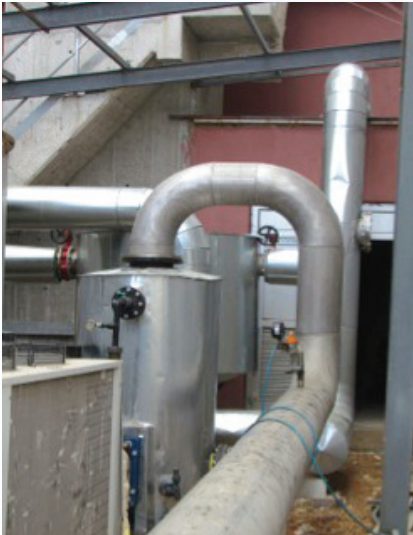
Resim 9. Gaz hatlarına yapılan yalıtım sistemi
