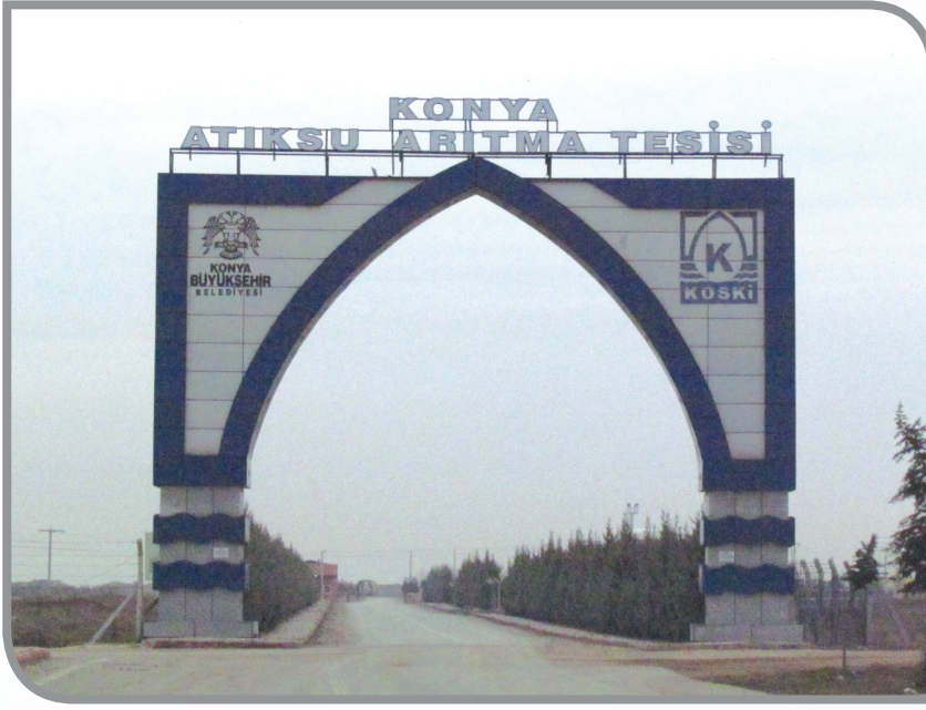
Atıksu arıtma tesisi girişi
