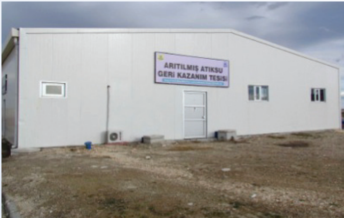
Resim 3. Arıtılmış atıksu geri kazanım tesisi
