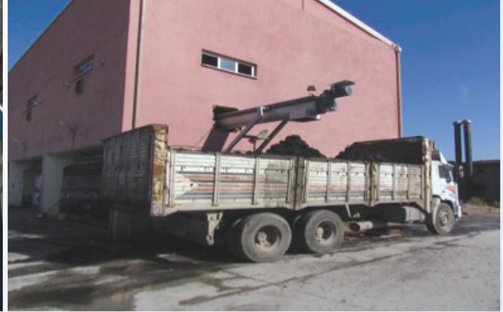
Resim 8. Çamur susuzlaştırma ünitesine kurulan helezon sistemi
