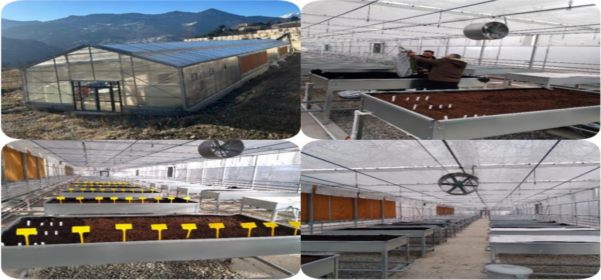
Şekil 17: İnşaatı tamamlanan 480 m 2 'lik üretim serası
